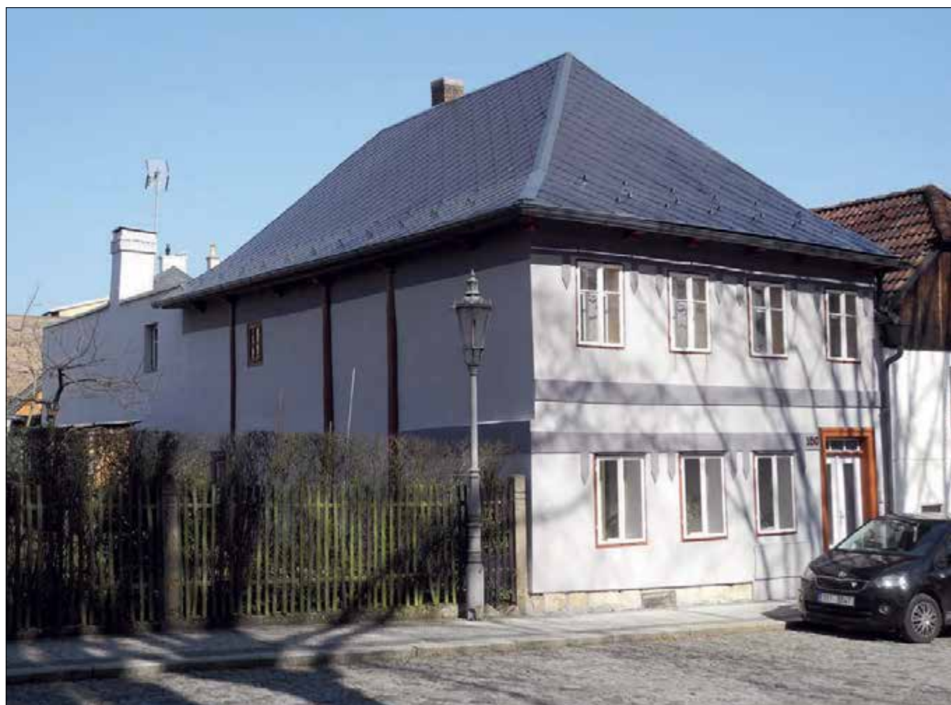
Bělá pod Bezdězem (správní obvod obce Mladá Boleslav), dům čp. 152 po opravě střechy a fasády. Klasicistní dům je součástí historické zástavby památkové zóny, která není jmenovitě zapsanou kulturní památkou. Patří k těm příkladům obnovy, při které se vcelku dobře podařilo zachovat charakteristické prvky stavby a jejího vývoje. K nim patří například viditelná zhlaví trámů pod přesahem střechy, obnovená krytina z vláknocementových šablon, která nahradila eternitové šablony, ale i okna v lici fasády byť částečně již se zjednodušeným členěním. Při opravě průčelí byla respektována dochovaná podoba s plastickým členěním z 20. století (foto E. Vyletová).
