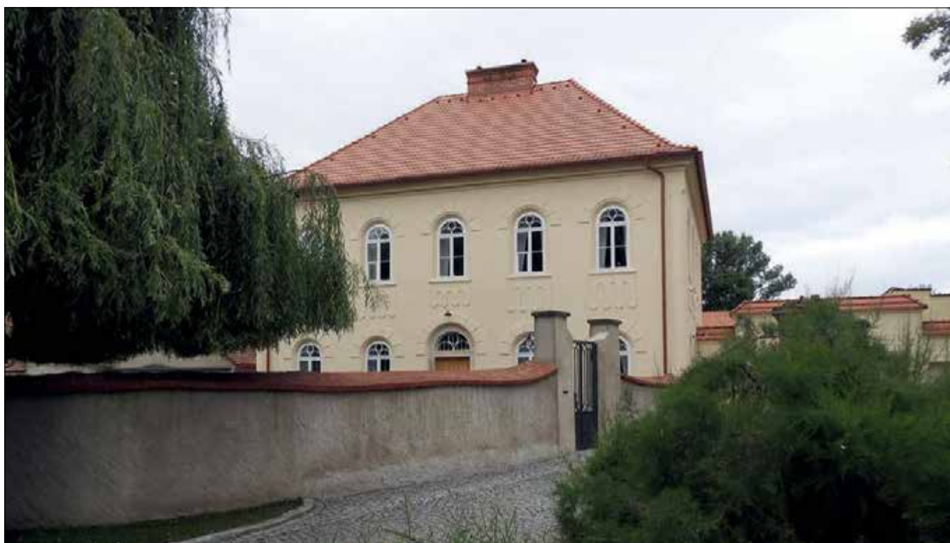
Vrbeno (správní obvod obce Mělník), VPZ, čp. 1. Výstavná budova fary je vedle kostela druhou dominantou návsi. V posledních letech prochází postupnou celkovou obnovou, která byla v loňském roce završena velmi zdařilou obnovou fasády. Akce je o to cennější, že se jedná o stavbu, která není kulturní památkou a vlastník tak veškerou obnovu realizuje bez nároku na finanční příspěvek (foto J. Berková).
