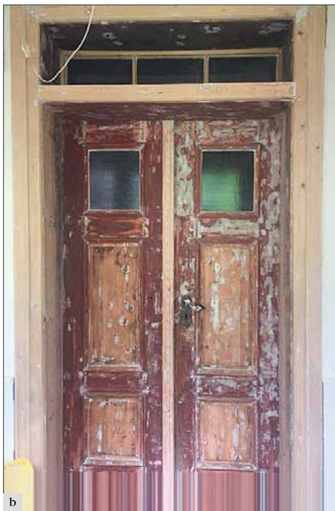
Stará Hut' (správní obvod obce Dobříš), Památník Karla Čapka na Strži: a – stav před započítím prací; b – nález hnědého a okrového rozbarvení původních domovních dveří; c – foto z dubna roku 2022, kvalitní práci prověřila zima; d – respektování barevnosti krycího náteru dveří z doby Čapkova pobytu (foto D. Hofreiterová).
