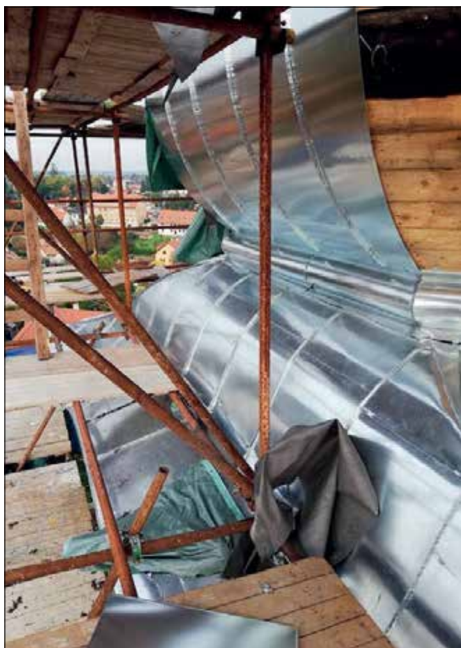
Brandýs nad Labem (správní obvod obce Brandýs nad Labem - Stará Boleslav), kostel Obrácení sv. Pavla, pečlivě a kvalitně provedená oprava plechového opláštění střechy zvonice s bání (foto A. Švejdarová).
