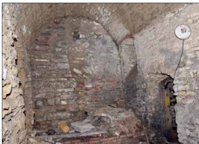
Buštěhrad (okres Kladno), Hradní čp. 17 – OPD sklepa, který ale leží a náležel sousednímu domu, si vyžádal mimo jiné alespoň základní zaměření půdorysů i řezu. Ty jsou nezbytné pro vyhodnocení stavebního vývoje převyšovaného a místy dvoupodlažního suterénu. Navíc jde o průzkum prostor, u kterých neznáme vývoj a ani dispozici a návaznost souvisejícího nadzemního objektu. O původu sklepa nicméně svědčí pozdně gotický portál v pravé nico (foto V. Jesenský).
