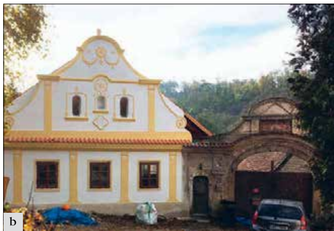
Sázava - Davle (správní obvod obce Černošice), obnova fasády hlavního štítového průčelí klasicistního domu v areálu usedlosti čp. 2; a – stav před obnovou, b – stav po obnově (foto M. Hanzlíková).
