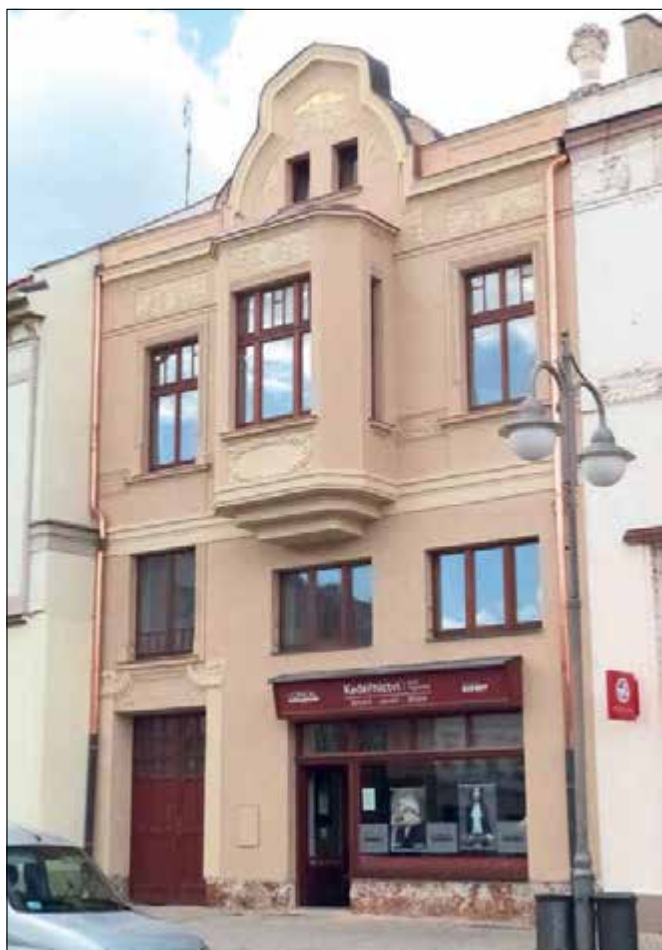
Rakovník (správní obvod obce Rakovník), MPZ, Husovo nám. čp. 114, domovní průčelí po dokončené opravě fasády (foto E. Volfová).
