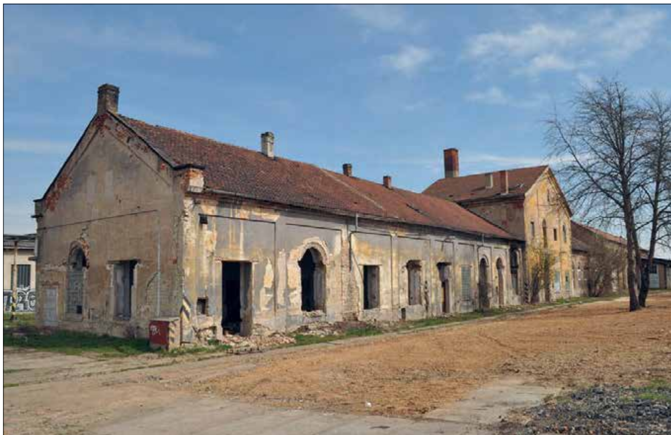
Kralupy nad Vltavou (okres Mělník), bývalé dílny Buštěhradské dráhy, pohled od jihozápadu. K nejstarší části z roku 1855, s patrovou nástavbou vodárny, byla v následujícím půlstoletí přistavěna navazující křídla dílen s jednotnými, obloukově završenými okny, stejnými jako na Chválově nejznámější realizaci – nádraží Praha-Dejvice (foto I. Minář).
