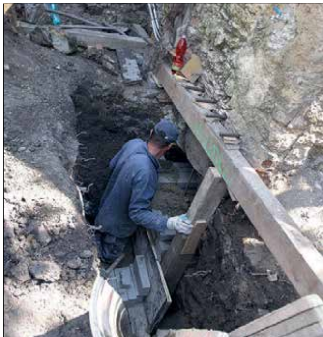
Středokluky (správní obvod obce Černošice), dům v areálu usedlosti čp. 43 – probíhající podezdí zadní části hospodářského dílu, úsek s výrazně poškozeným opukovým zdívem, které bylo nutné před podezděním provizorně vynést pomocí ocelových tyčí a roznašecího trámků (foto M. Hanzlíková).
