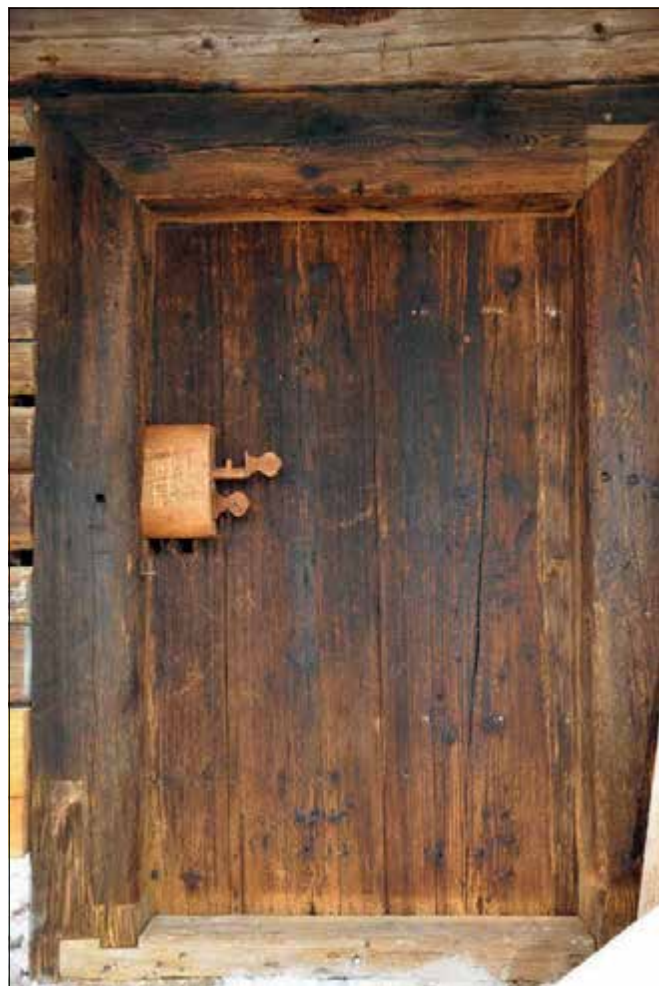
Starosedlský Hrádek (správní obvod obce Příbram), roubená hospodářská stavba u mlýna čp. 4. Detail opraveného portálu s repasovanými dveřmi, na něž byla osazena replika dřevěného zámku, stav v listopadu 2021 (foto J. Pešta).
