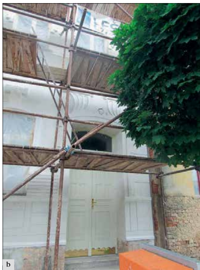
Český Brod (správní obvod obce Český Brod): a, b – rekonstrukce secesní fasády čp. 385 na základě historických fotografií, dochovaných původních plánů a studia českobrodských secesních fasád (foto A. Švejdarová).
