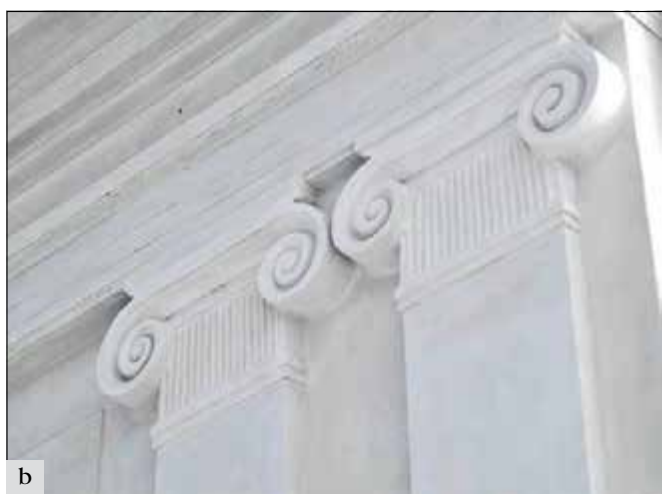
Březno (správní obvod obce Mladá Boleslav), kostel sv. Václava, detaily štukatérské obnovy plastického členění klasicistní předsíně: a – hlavice pilastrů provedené z části z pískovce a z cihel měly ve velkém rozsahu narušené omítky; b – hlavice pilastrů po obnově (foto E. Vyletová).
