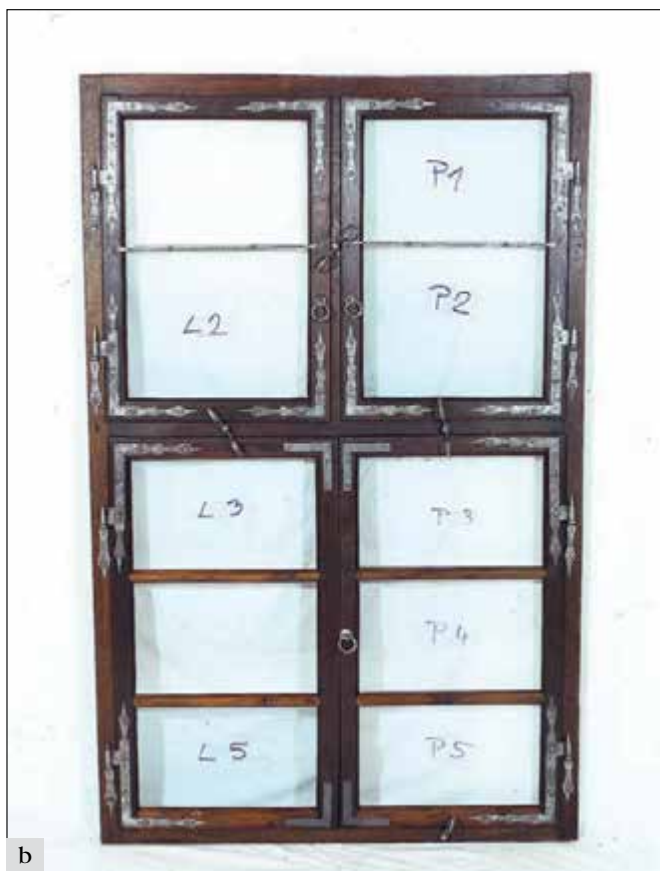
Hájek u Červeného Újezdu (správní obvod obce Černošice), františkánský klášter, západní křídlo: a, b – stav před a po restaurování barokního okna, v rámci koncepce byly respektovány mladší úpravy jako dřevěné příčle ve spodních křídlech a dva novodobé úhelníky (foto D. Raška).
