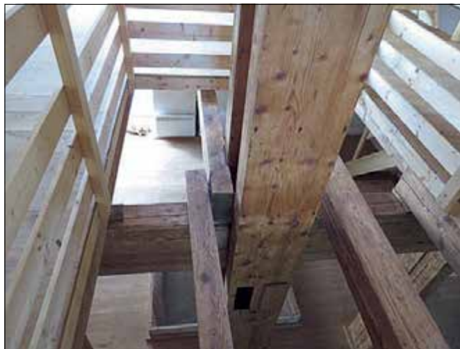
Hvoždany (správní obvod obce Příbram), špýchar, opravená násypka jako součást interiéru (foto E. Kosová).
