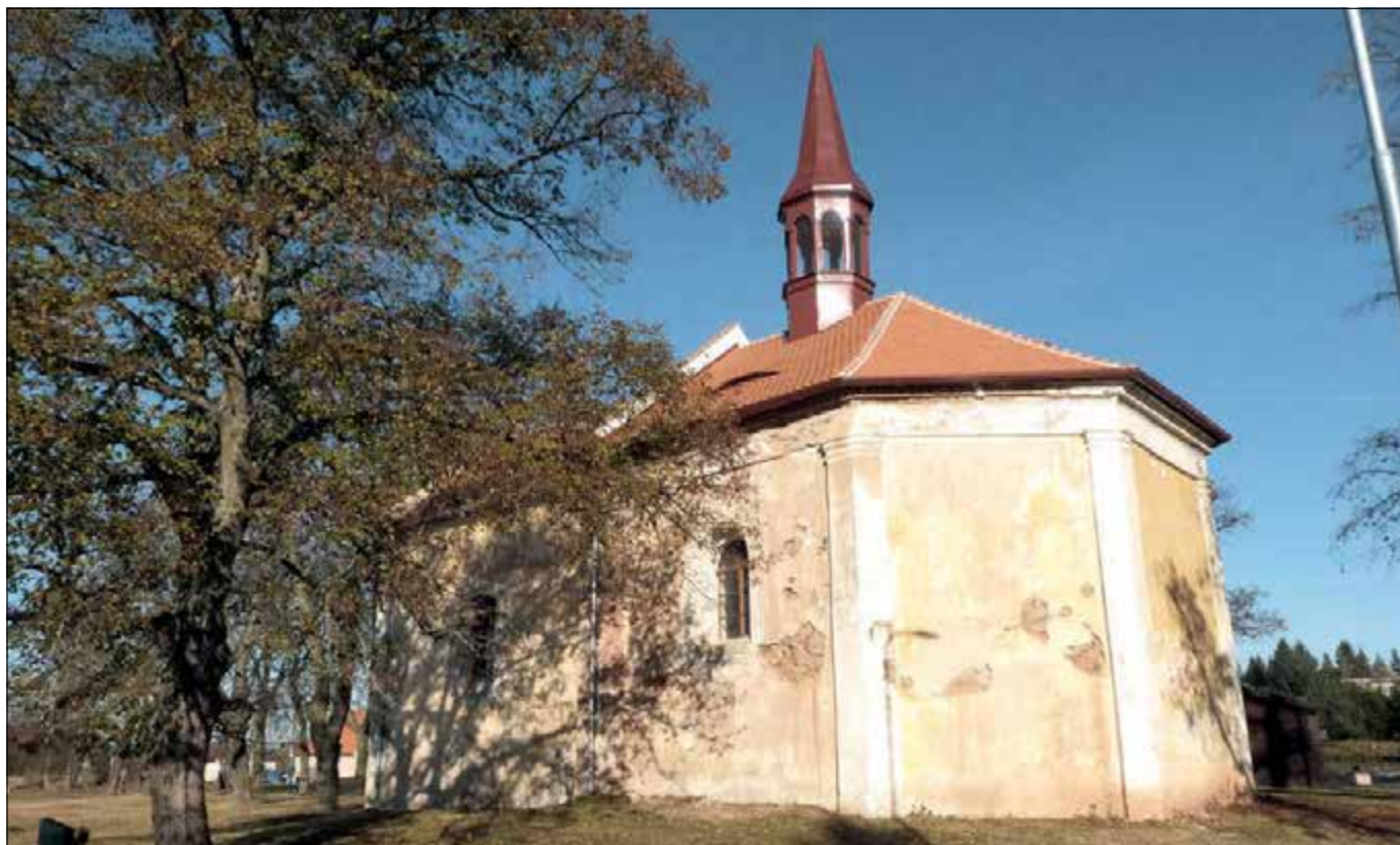
Žďár (správní obvod obce Rakovník), kaple sv. Marka a Martina, dokončená oprava krovu nad presbytářem s položenou novou střešní krytinou z pálených bobrovek (foto E. Volfová).
