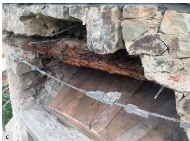
Lochovice (správní obvod obce Hořovice), zámek: a – pohled na jihovýchodní věž od příjezdové cesty, 1. a 2. okno; b – interiér věže, průzkum stavu po odhalení dvou trámů v nadpraží, 1. okno; c – vnější pohled na nadpraží 1. okna (foto D. Hofreiterová).
