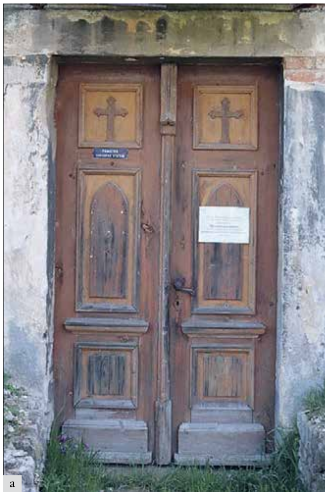
Bošín, (správní obvod obce Nymburk), kostel Nanebevzetí Panny Marie: a, b – hlavní vstupní dveře před a po obnově. Monochromní barevnost v odstínu hořčičné žluté byla zjištěna stratigrafickým průzkumem výplní a plně odpovídá předpokládané době vzniku výplní, tj. konec 19. století (foto B. Schmidová).
