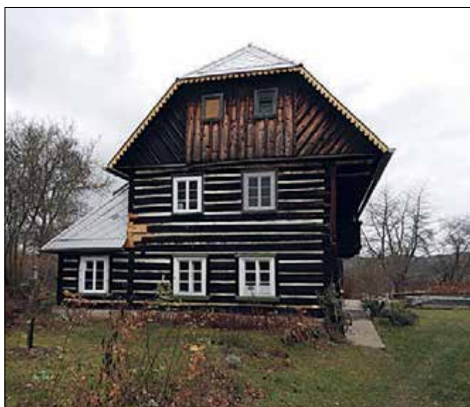
Jestřebice (správní obvod obce Mělník), VPZ, roubený dům usedlosti čp. 5. V rámci realizované obnovy střechy byly provedeny dílčí opravy roubení a doplněny dobové zdobné detaily štítu (foto J. Berková).
