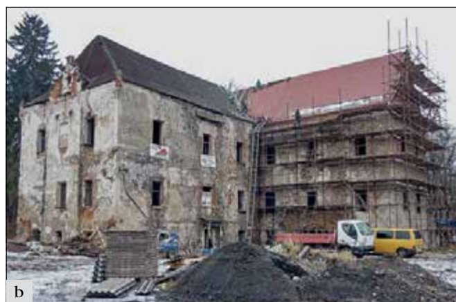
Zvěstov (správní obvod obce Votice), zámek, obnova západního křídla: a – stav v létě 2013, kdy bylo ze západního křídla zachováno po odstřelu v 70 – tých letech 20. století jen torzo; b – stav na konci roku 2021, kdy probíhala pokládka krytiny na novém krovu, který byl postaven na sanovaném a doplněném zdivu západního křídla (foto D. Primusová).
