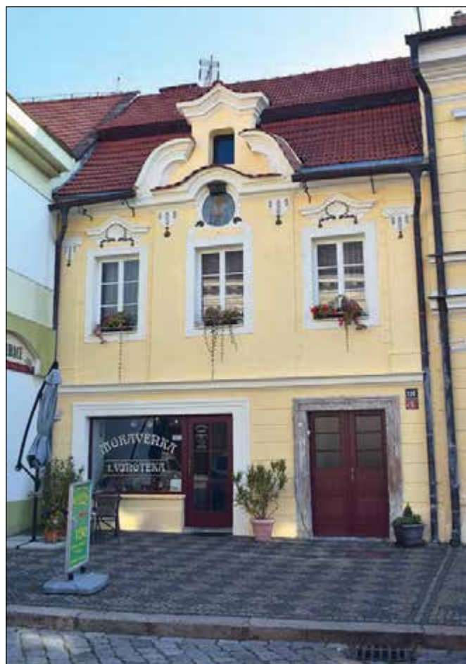
Mělník (správní obvod obce Mělník), dům čp. 136, foto z průběhu realizace (foto P. Kalinová).
