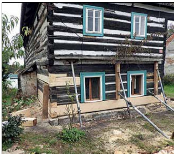
Dobřeň (správní obvod obce Mělník), VPR, roubený dům usedlosti čp. 8, stav v průběhu obnovy po výměně poškozených trámů světnice a před osazením parapetních říms (foto J. Berková).
