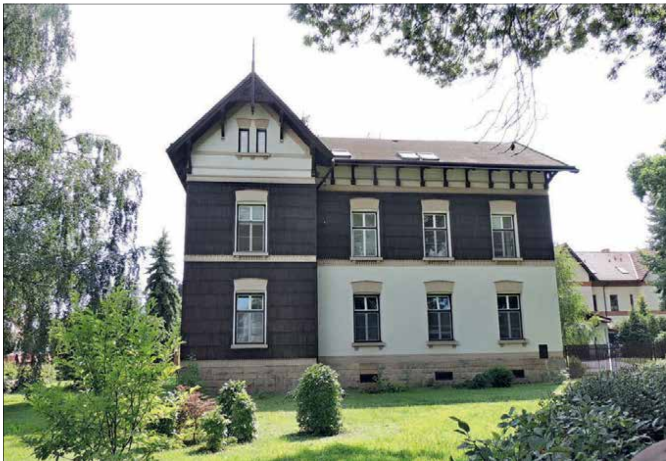
Nymburk (okres Nymburk), inspektorský dům čp. 406 ve Školní ulici, pohled od severu: V souboru tří domů navržených na prohlášení za kulturní památku vyniká dům čp. 406 dobře zachovaným vnějším pláštěm. Na snímku tak můžeme vidět téměř všechny prvky charakteristické pro architektonické řešení inspektorských domů: kamenem obložený sokl, cihelné záklenky a parapety oken, ozdobně vyskládané cihelné římsy, prořezávané panely a okřídlení štítů, vyřezávané konzoly vynášející přetažené vaznice a krokve. Jako jediný ze tří domů je také dosud obklopen udržovanou zahradou. Alespoň částečně tak zprostředkovává dojem z původního urbanistického řešení východního okraje kolonie, kde navazovala na hlavní třídu spojující nádraží s městem (foto A. Jankulíková).
