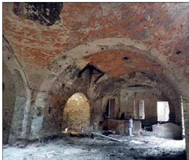
Jince (ORP Příbram), dřevouhelná vysoká pec Barbora, vnitřní prostora huti po zahájení prací, říjen 2021 (foto O. Hrdlička).
