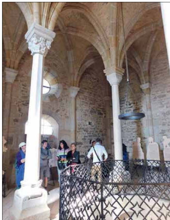
Cheb, kaple sv. Erharda a sv. Uršuly, horní etáž stavby v přechodovém románsko-gotickém slohu (foto E. Zápalková)
