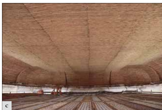
Starkoč (správní obvod obce Čáslav), kostel Nanebevzetí Panny Marie: a – stav kostela v roce 2012; b, c – pohled na obnovenou konstrukci fabionového stropu, omítka stropu bude následovat v další etapě (foto J. Černochová).
