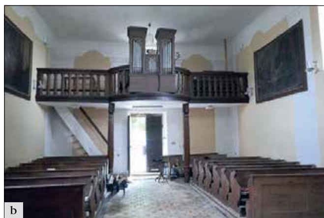
Lhotka (správní obvod obce Hořovice), kaple sv. Anny: a, b – v kapli sv. Anny byly vlhkostí velmi poškozené spodní partie omítek, spolu s jejich opravou proběhla i obnova výmalby. Prvky interiéru měly tři barvy, které však postrádaly tektoniku – pilastry nic nenesly. Barevnost byla proto změněna tak, aby korespondovala s vnější výzdobou fasád. Namísto tří barev byly použity jen dvě. Hlavice byly opticky potlačeny, ale pilastry opět získaly svou symbolickou tektonickou funkci, vynikl i obloučkový motiv uprostřed zrcadel (foto H. Řepková).
