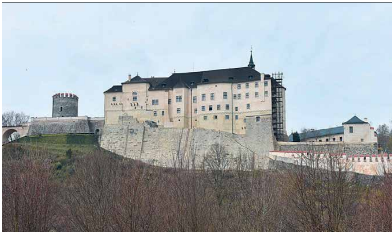
Český Šternberk (správní obvod obce Benešov), hrad, oprava východní fasády hradního paláce. Fasády hradu byly na počátku 20. století opatřeny tvrdou omítkou, která již byla poškozena. V loňském roce proběhla sanace podnože, která vznikla opláštěním skály kamenem, obnova východní fasády byla dokončena (foto D. Primusová).
