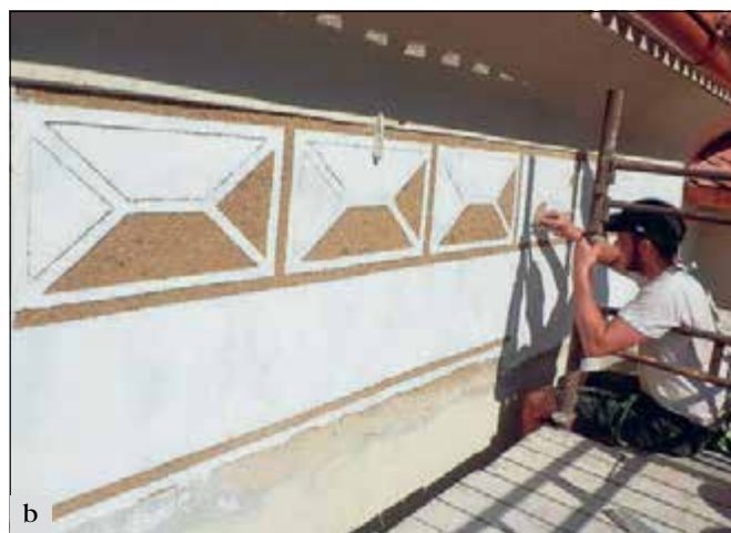
Olbramovice (správní obvod obce Votice), čp. 1: a – před obnovou torza sgrafit na jižním průčelí; b – rekonstrukce sgrafit na jižním průčelí obráceném k rybníku (foto H. Řepková).
