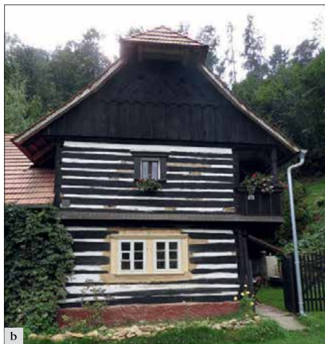
Skalsko (správní obvod obce Mladá Boleslav), VPZ, dům čp. 58. Okenní výplně mají zcela zásadní vliv na celkový výraz stavby. V rámci nevelké dílčí etapy se podařilo rekonstruovat původní podobu oken v přízemí a do jednoho z nich vrátit i vlastníkem nalezená původní okenní křídla (foto J. Berková).
