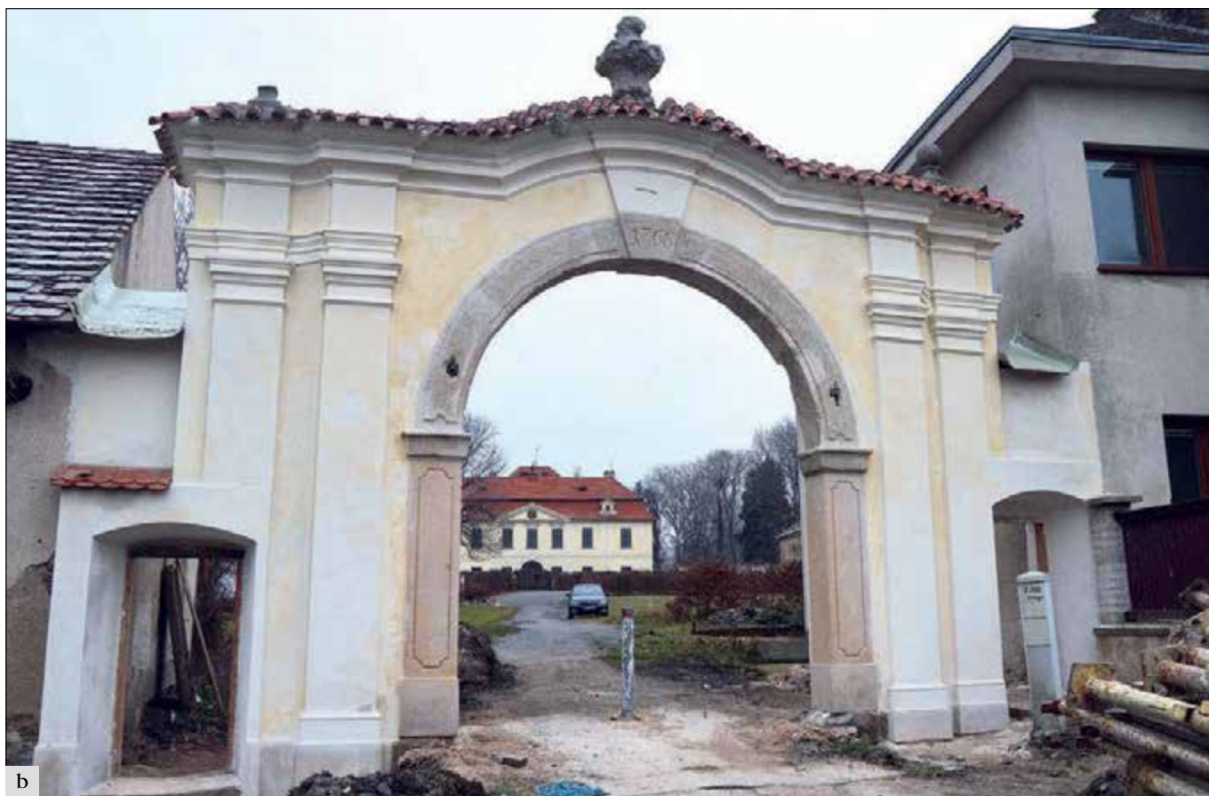
Bečváry (správní obvod obce Kolín): a – brána zámeckého areálu s odstraněným portálem ve 2. polovině 20. století z důvodu umožnění vjezdu autům místního JZD, v torzech dochovaná štuková výzdoba umožnila rekonstrukci barokního stavu; b – brána po obnově štukové výzdoby a navrácení původního záklenku portálu deponovaného majitelem zámku desetiletí ve stodole hospodářského dvora (foto D. Havlíková).
