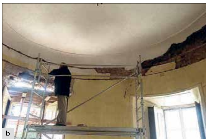
Lhotka (správní obvod obce Hořovice), kaple sv. Anny: a, b – v kapli sv. Anny byly vlhkostí velmi poškozené spodní partie omítek, spolu s jejich opravou proběhla i obnova výmalby. Prvky interiéru měly tři barvy, které však postrádaly tektoniku – pilastry nic nenesly. Barevnost byla proto změněna tak, aby korespondovala s vnější výzdobou fasád. Namísto tří barev byly použity jen dvě. Hlavice byly opticky potlačeny, ale pilastry opět získaly svou symbolickou tektonickou funkci, vynikl i obloučkový motiv uprostřed zrcadel (foto H. Řepková).
