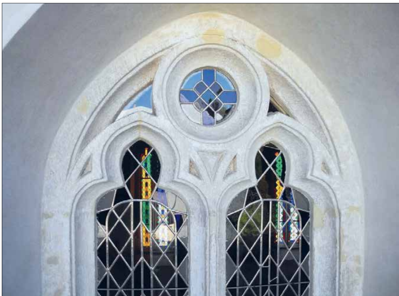
Loukov (správní obvod obce Mnichovo Hradiště), kostel Nejsvětější Trojice. Součástí opravy fasády bylo restaurování okenních kružeb a vitráží. Na snímku je zachycen detail okenní kružby po očištění od vrchních nesoudržných nátěrů, po doplnění tmelů v místech poškození a s restaurovanými vitrážemi (foto E. Vyletová).
