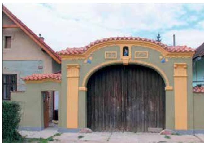
Benátecká Vrutice (správní obvod obce Lysá nad Labem), klasicistní brána u čp 22 – stav po obnově s doplněním štukových prvků včetně čísla popisného a iniciál vlastníka (foto M. Hanzlíková).
