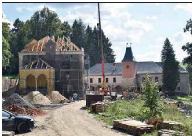
Smilkov (správní obvod obce Votice), zámek, celková obnova. V areálu novogotického zámku ve Smilkově byla v roce 2021 zahájena celková obnova dlouhodobě nevyužívaných a neudržovaných budov. Byly obnoveny střechy obou křídel zámku, na kterých byla položena krytina z břidlice. Upravena a novou střechou opatřena byla také věž. Kromě toho probíhala obnova fasád zámku (foto D. Primusová).
