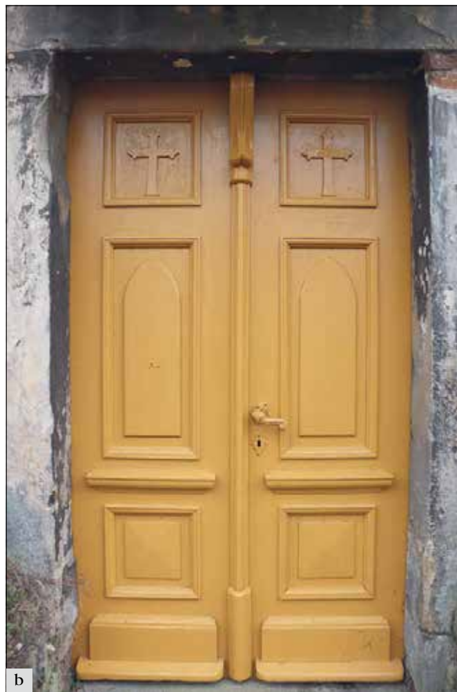
Bošín, (správní obvod obce Nymburk), kostel Nanebevzetí Panny Marie: a, b – hlavní vstupní dveře před a po obnově. Monochromní barevnost v odstínu hořčičné žluté byla zjištěna stratigrafickým průzkumem výplní a plně odpovídá předpokládané době vzniku výplní, tj. konec 19. století (foto B. Schmidová).
