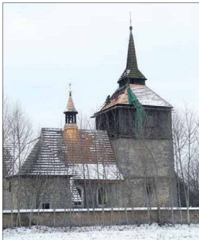
Březina (správní obvod obce Mnichovo Hradiště), kostel sv. Vavřince. Kostel gotického původu má zachovány hodnotné tesařské konstrukce včetně zvonové stolice ve věži dendrochronologicky datované do 16. století. V letošním roce probíhaly tesařské opravy vnitřní dřevěné konstrukce věže s výměnou krytiny z dřevěného šindele nad spodní částí střechy (foto E. Vyletová).
