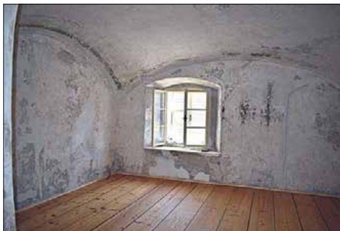
Kolín (správní obvod obce Kolín), interiér sakristie v patře západního křídla zámku. Sakristie je umístěná nad průjezdem původně středověké brány městského opevnění, která byla stavěná jako součást zaniklého dominikánského kláštera, po husitských válkách se stala součástí hradu Bedřicha ze Strážnice a následně zámku Pernštejnů či později Žerotínů. Samotná kaple se sakristií je prvně zachycena na plánech ze 17. století. Na fotce stav po snímání druhotných vrstev, omítky po zajištění (foto D. Havlíková).
