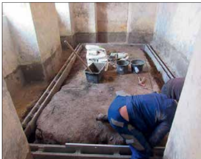
Čelákovice (správní obvod obce Brandýs nad Labem - Stará Boleslav), fara, oprava interiérů přízemí, bylo provedeno odvětrání suterénních konstrukcí podlahy pomocí vzdušných kanálů (foto A. Švejdarová).
