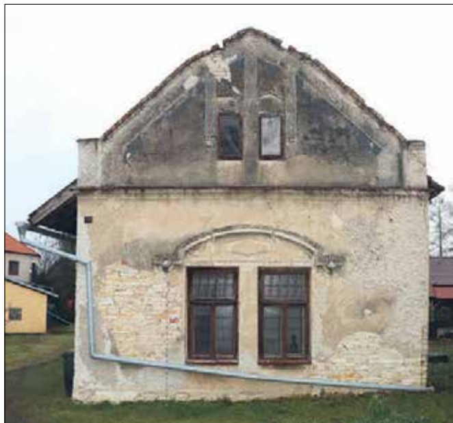
Libice nad Cidlinou (správní obvod obce Poděbrady), dům čp. 45, originálně pojedené uliční průčelí domu čp. 45 s atypickým zalomením štítu a plastickým členěním v duchu geometrické secese. Vzhledem k chystaným razantním stavením úpravám domu byla v závěru roku 2021 provedena dokumentace průčelí, avšak pouze v jeho spodní části. Dokumentace štítu má být umožněna po postavení lešení (foto B. Schmidová).
