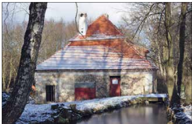
Drahenice (správní obvod obce Příbram), mlýn čp. 23. Celkový pohled na budovu mlýna s dokončenou střechou, stav v prosinci 2021. Oprava střechy je pro dlouhodobě chátrající stavbu nesporně velkým přínosem (foto J. Pešta).
