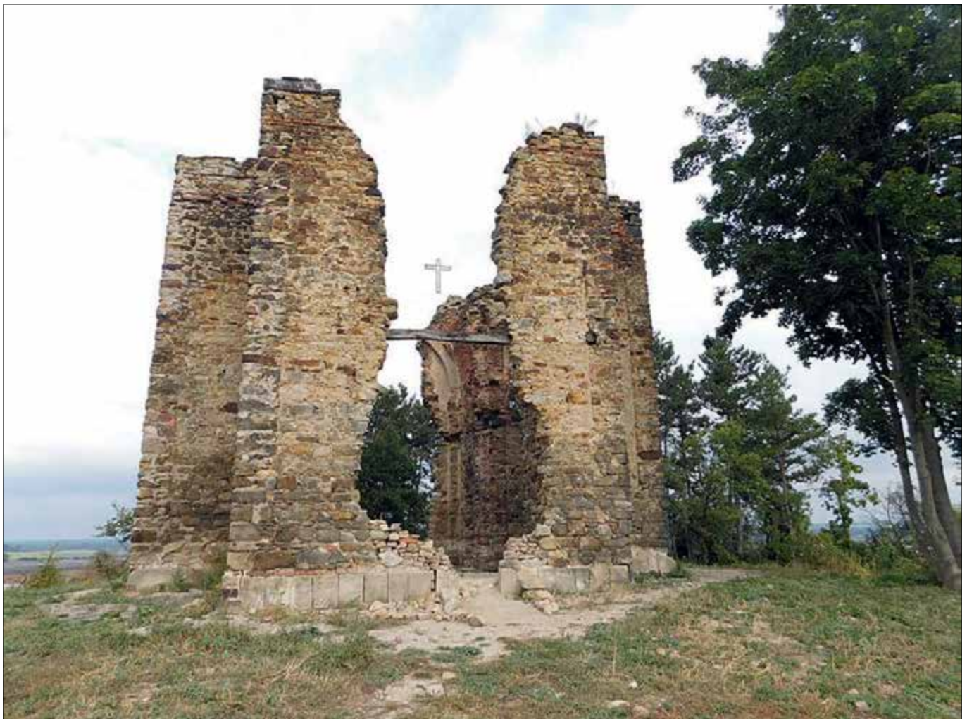
Bříství (správní obvod obce Lysá nad Labem), Křížová Hůra, zřícenina kaple Povýšení sv. Kříže, stav po vyklučení náletových dřevin a srovnání terénu (foto E. Zápalková).
