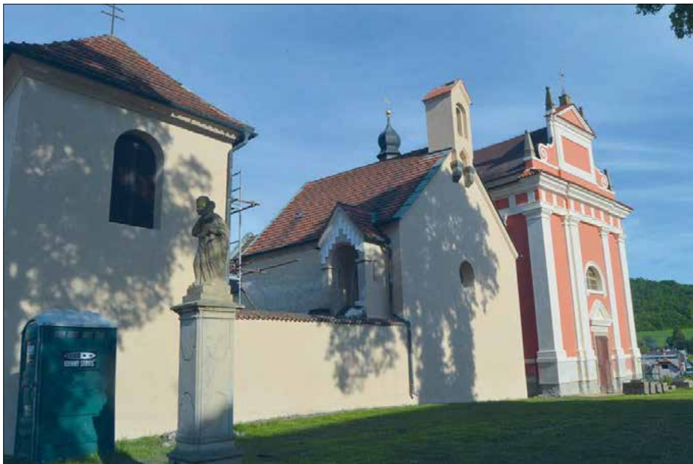
Tetín (správní obvod obce Beroun), kostel sv. Kateřiny se zvonící a kostelem sv. Ludmily v pozadí, pohled na západní fasády po obnově vnějších omítek, u sv. Kateřiny i střechy včetně krovu (foto D. Havlíková).
