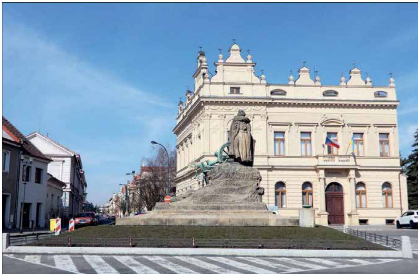
Český Brod (správní obvod obce Český Brod), pomník Prokopa Holého, dílo Karla Opatrného z let 1908–1910. Pomník byl ve dvou etapách zrestaurován a následně proběhla i obnova obruby a oplocení. Nejzávažnější poškození představovala dožilá vnitřní konstrukce kovových prvků, která způsobovala jejich sesedání a namáhání spojů. Pro kámen byla velmi důležitá výměna nevhodné spárovací hmoty a ztenčení černých kruzů (foto T. Cachová).
