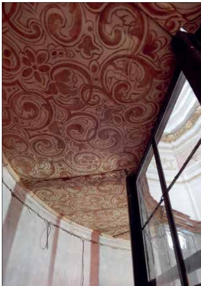
Nové Dvory (správní obvod obce Kutná Hora), kostel sv. Anny. Dlouhodobě probíhající obnova objektu byla svou recentní etapou zaměřena na restaurování oratoře. Mimo prosklené části, kde došlo k výměně ahistorických skel a doplnění chybějících odpovídajícím materiálem, restaurování kování, polychromie, sochařské a řezbářské výzdoby, došlo také k obnově dřevěného stropu s nově odkrytou malbou, která byla restaurována. Stav po zpětném osazení (foto L. Maděrová).
