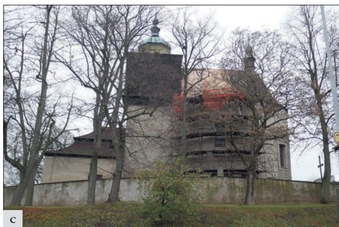
Pravonín (správní obvod obce Vlašim), kostel sv. Jana Křtitele: V roce 2022 byla dokončena oprava krovu a výměna šindelové krytiny; a – doplnění římsy; b – probíhající práce, pohled ze severu; c – pohled z jihu na dokončenou poslední etapu (foto H. Řepková).
