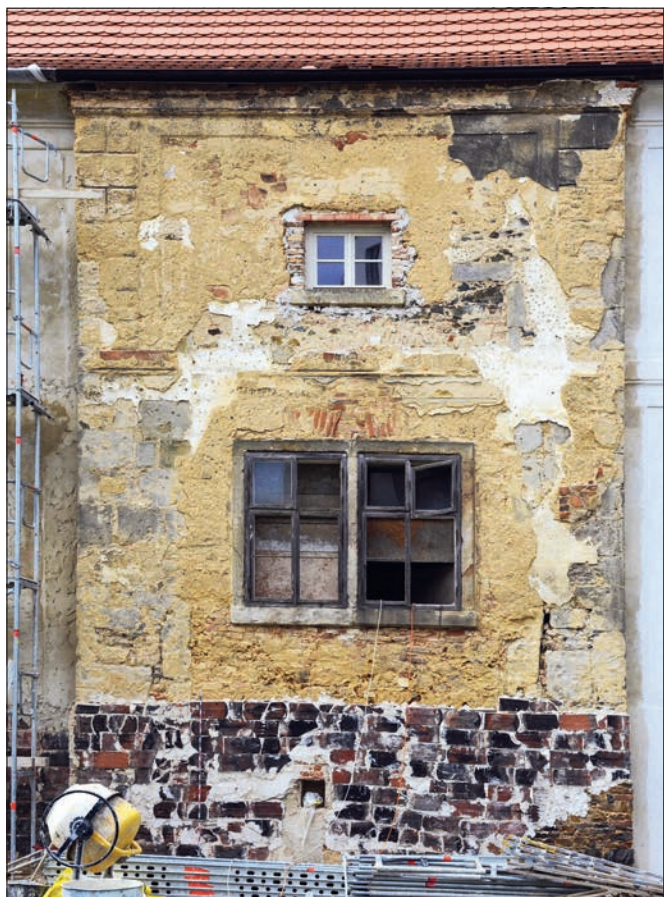
Pakoměřice (okres Praha východ), zámek, severovýchodní průčelí. Střední rizalit prozrazuje těleso věže původní středověké tvrze s průjezdem do dvora. Na průčelí je patrná zazděná vjezdová brána. Po zdokumentování byly nálezy překryty fasádou rekonstruující barokní stav.
