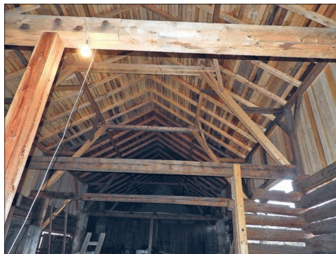
Loukov, (správní obvod obce Mnichovo Hradiště), VPZ, stodola v usedlosti čp. 28. Krov nad roubenou částí stodoly byl ve zcela havarijním stavu a vyžádal si poměrně značný rozsah výměn. V následujícím roce bude na plně bednění položena krytina z vláknocementových šablon, která již kryje mladší polovinu stodoly, jejíž krov byl obnoven před několika lety (foto J. Berková).
