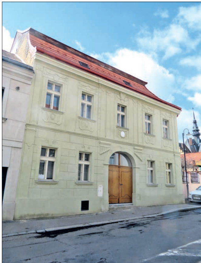
Slaný, čp. 53. Kvalitní obnova bohaté klasicizující fasády domu čp. 53, KP, která značně utrpěla při posledních nevhodných opravách, provedených na konci minulého století (přetažení, a tedy deformování všech prvků a detailů vrstvou nevhodného materiálového složení). Tato vrstva byla odstraněna a všechny prvky vráceny do původních tvarů, četné profily byly vytaženy podle šablony, barevný odstín vápenného nátěru byl zvolen na základě provedeného průzkumu barevnosti. Završením této obnovy bylo zhotovení nových vrat, které byly provedeny podle původních, již zaniklých, vrat dle historické fotografie (foto E. Mikešová).
