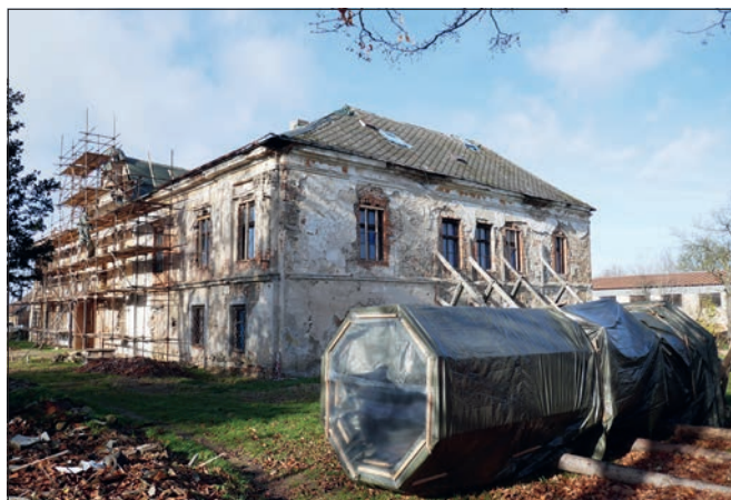
Pravonín (správní obvod obce Vlašim), zámek: V roce 2022 byla dozděna zřícená část průčelí zámku. Před obnovou krovu byla sejmuta osmiboká věžička a uskladněna na pozemku (foto H. Řepková).
