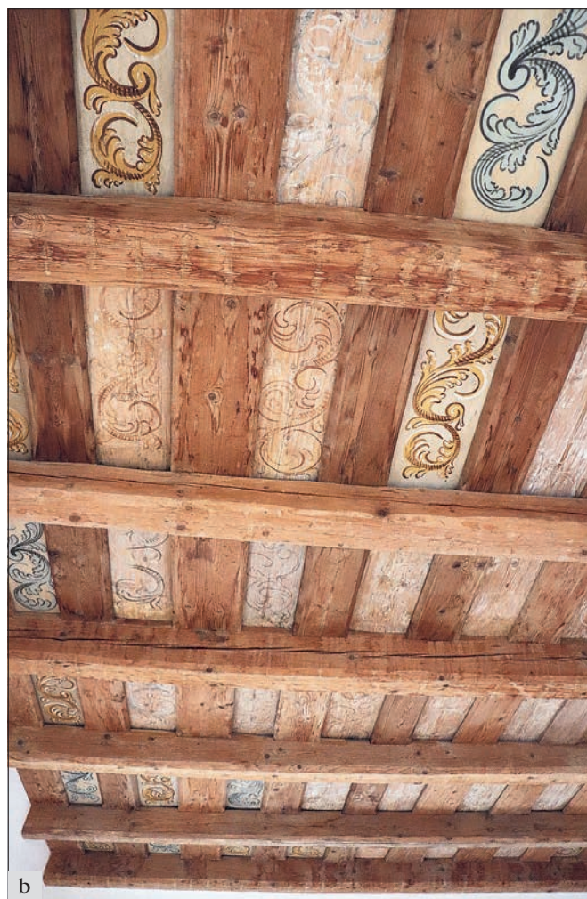
Osečany (správní obvod obce Sedlčany), zámek čp. 1: a – drůhotně poskládaný strop z několika místností ve 2. patře zámku před zahájením obnovy; b – stav po restaurování a přeskládání záklopových prken (foto J. Černochovej).
