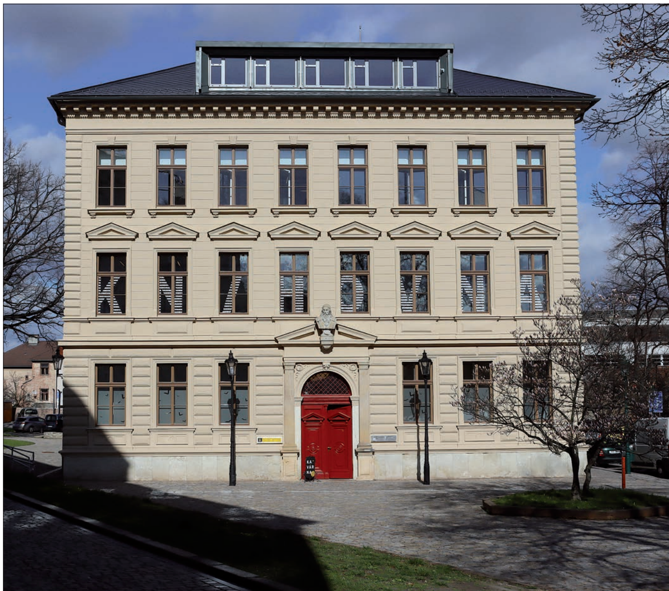
Kutná Hora, Městská knihovna. Školský objekt postavený v roce 1892 v novorenesančním stylu prošel v letech 2020–2022 celkovou rekonstrukcí. Kvalitně opraveno bylo architektonické členění fasády, kde pozitivní roli sehrála nová špaletová okna s profilovaným poutcem, osazená kopiemi historického zasklení. Novým prvkem exteriéru se staly kubicky tvarované střešní vikýře a přístavba dvou prosklených výtahových těles při boční fasádě, které odráží přístup arch. Jiřího Krejčíka k rekonstrukci, založený na souznění dochované historické struktury objektu s neskrývanou vizualizací nového funkčního řešení (foto A. Pospíšil).
