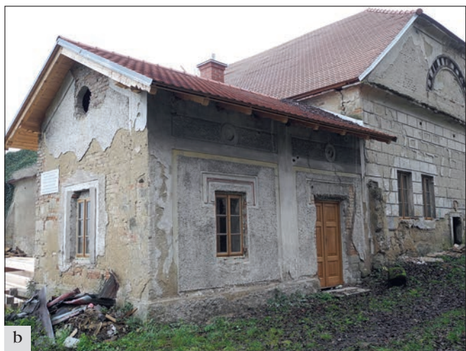
Březno (správní obvod obce Mladá Boleslav), kočárovna v areálu zámku: a – před opravou byl objekt značně poškozen v důsledku dlouhodobého zatékání; b – v současné době probíhá postupná oprava tesařských konstrukcí s obnovou taškové krytiny a z části již zaniklých truhlářských výplní (foto E. Vyletová).
