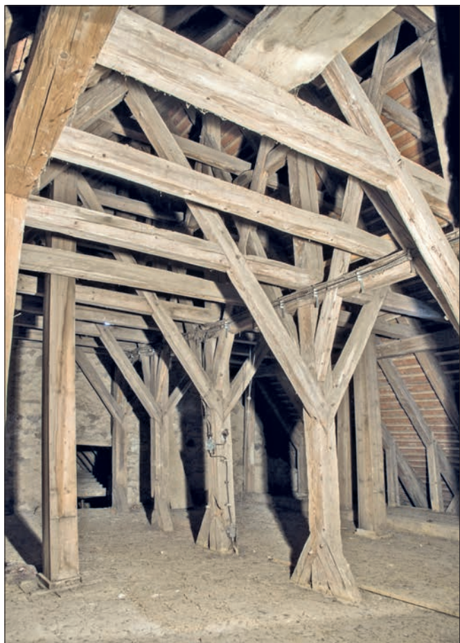
Nechvalice (okres Příbram), kostel sv. Mikuláše – Krov nad lodí kostela datovaný dendrochronologicky do roku 1476 se velmi podobá krovu nad lodí sedlčanského kostela sv. Martina, který je o 35 let starší. Oba patří k nejhodnotnějším krovovým konstrukcím na Příbramsku (foto J. Veselý, 2022).
