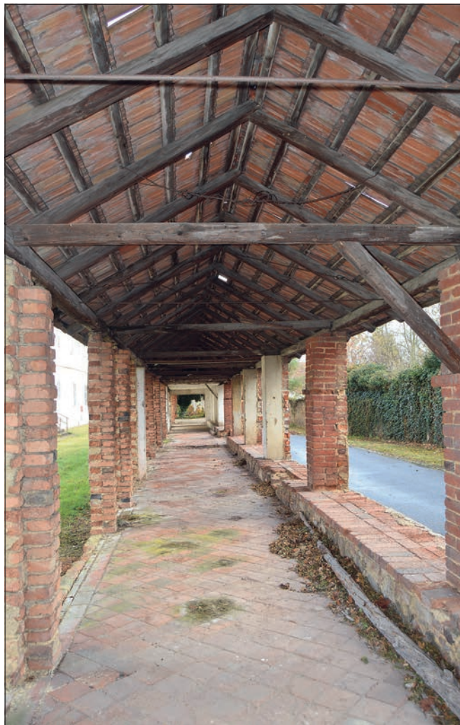
Lítaň (správní obvod ORP Beroun), zaniklá kolonádová chodba v zámeckém areálu, pohled do interiéru měsíc před nečekanou a neohlášenou demolicí (foto D. Havlíková, únor 2023).
