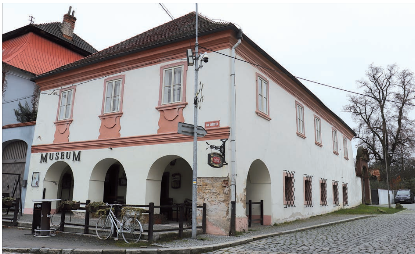
Kostelec nad Černými lesy (správní obvod obce Říčany), městské muzeum čp. 41. Na objektu byla osazena jednoduchá, zdvojená okna z 2. pol. 20. století. Při výměně oken v úrovni 1. patra byla navržena původní podoba dvojitých oken, provedených dle archívni fotografie z počátku 20. století (foto J. Černochová).
