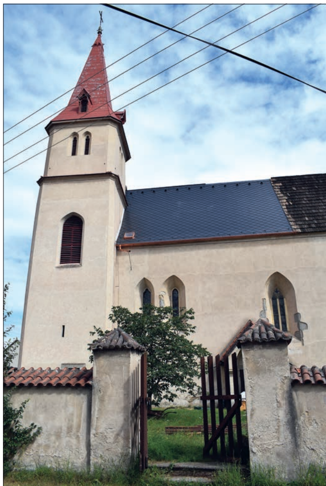
Arnoštovice (správní obvod obce Votice), kostel sv. Šimona a Judy, obnova střechy. Po dlouhých odkladech byla v tomto roce zahájena oprava havarijní střechy kostela. V rozsahu poloviny plochy střechy byla v tomto roce provedena lokální oprava a posílení krovu a byla položena nová krytina ze šedých vláknitocementových šablon. Tento materiál byl nakonec schválen, protože z důvodu nedostatku finančních prostředků a dožilé šindelové krytiny hrozilo vážné poškození dalších částí této velmi hodnotné památky (foto D. Primusová).
