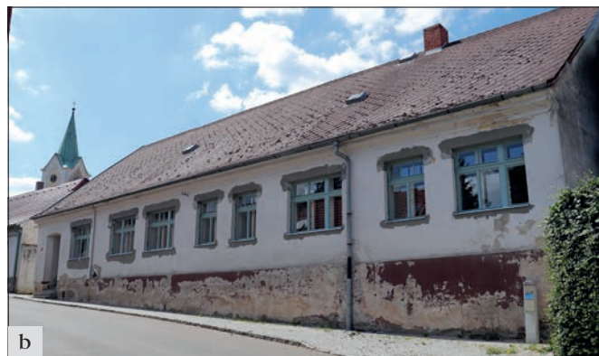
Sedlec-Prčice (správní obvod obce Sedlčany), MPZ, Sedlec čp. 69: a – vzhled domu byl ve 2. polovině 20. století narušen nevhodnou úpravou okenních otvorů a výplní; b – obnova okenních otvorů a jejich osazení adekvátními dvojitými okenními výplněmi pomohly výrazně rehabilitovat podobu historického domu (foto J. Černochová).
