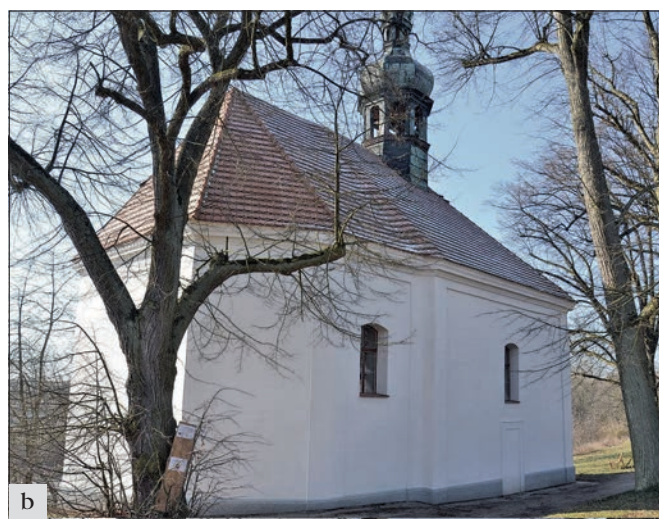
Čistá (správní obvod obce Rakovník), kaple sv. Anny, obnova fasády, výměna okenních výplní: a - severní fasáda; b - čelní fasáda s novými vstupními dveřmi (foto D. Konstatská).
