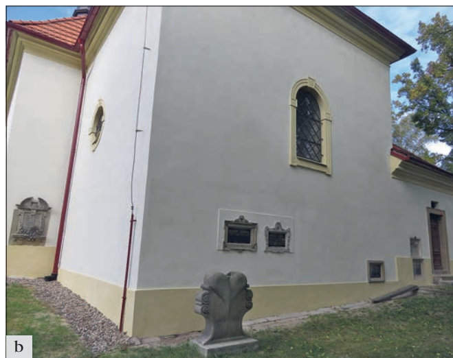
Družec (správní obvod obce Kladno), kostel Nanebevzetí Panny Marie: a – došlo k opravě fasád na severní, jižní a východní straně. Práce byly provedeny v nejvyšší řemeslné kvalitě, dořešeny byly některé nejasné detaily (podoba soklu, návaznosti na kamenné náhrobky); b – kamenné prvky byly obnoveny restaurátorským způsobem (foto E. Mikešová).
