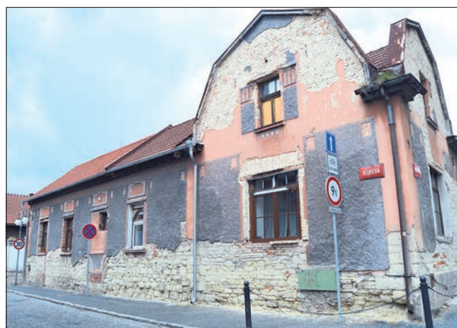
Byšice (okres Mělník), příklad běžné budovy, tvořící součást historické zástavby obce, která díky vysoké tehdejší úrovni stavitelství představuje ve svém původním výrazu a detailu provedení velmi hodnotou architekturu; dnes zcela běžně prováděné účelové úpravy většinou tuto skutečnost zcela opomíjí a výsledkem bývá často až karikatura původního domu (foto J. Mrázek).
