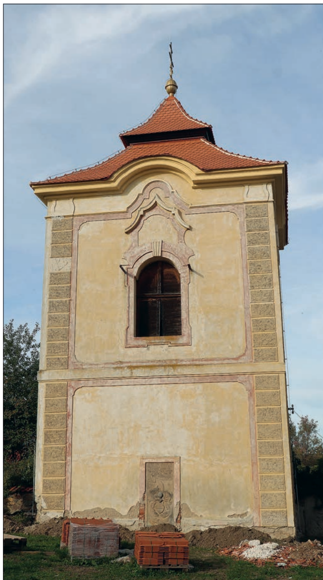
Kluky (správní obvod obce Čáslav), areál kostela sv. Jana Křtitele: zvonice po opravě krovu a výměně střešní krytiny. Na horní část střechy byla na místo dosavadní falcované krytiny navržena bobrovka (foto J. Černochovej).
