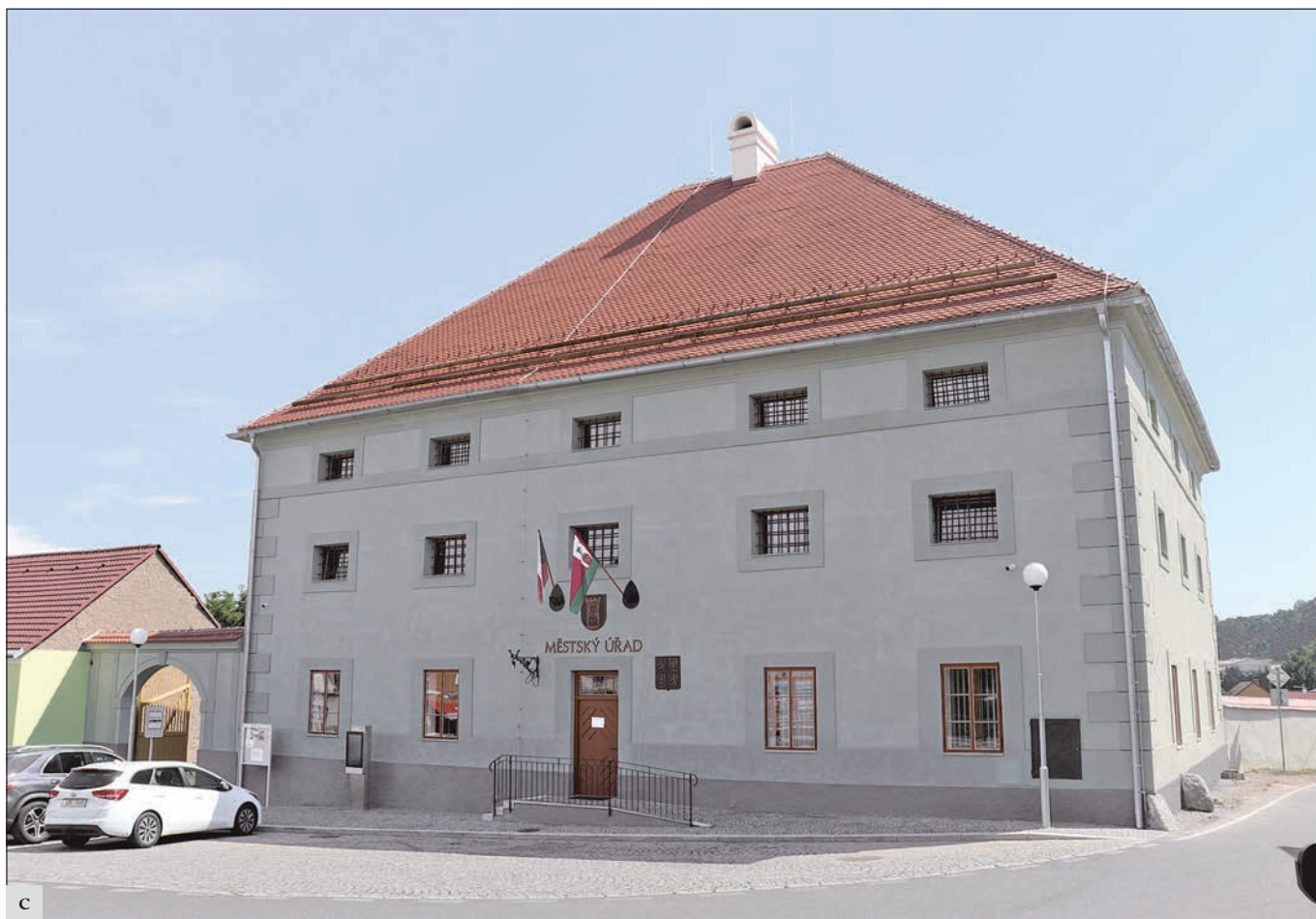
Krásná Hora nad Vltavou (správní obvod obce Sedlčany), sýpka čp. 45: a – objekt před zahájením obnovy; b – při opravě fasády byly nalezeny zbytky omítek zřejmě raně barokního původu s iluzivním členěním, na snímku je ryté nárožní kvádrování; c – do sýpky byl po dokončení obnovy přemístěn městský úřad (foto J. Černochová).
