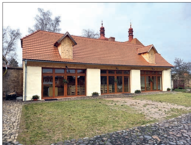
Mnichovo Hradiště (správní obvod obce Mnichovo Hradiště), areál děkanství, kočárová kolna po obnově, listopad 2022 (foto O. Hrdlička).
