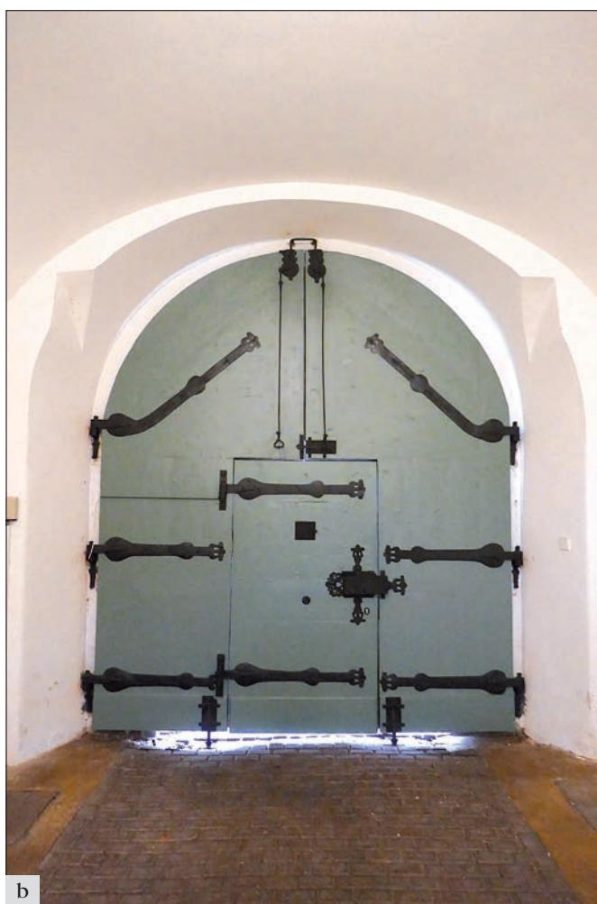
Stará Boleslav (správní obvod obce Brandýs nad Labem – Stará Boleslav). V roce 2022 proběhla obnova svlakových uličních i dvorních vrat kanovnické rezidence: a, b – hlavní vrata zevnitř před a po obnově; c – vrata zvenku po obnově, d – detail kování (foto H. Řepková).
