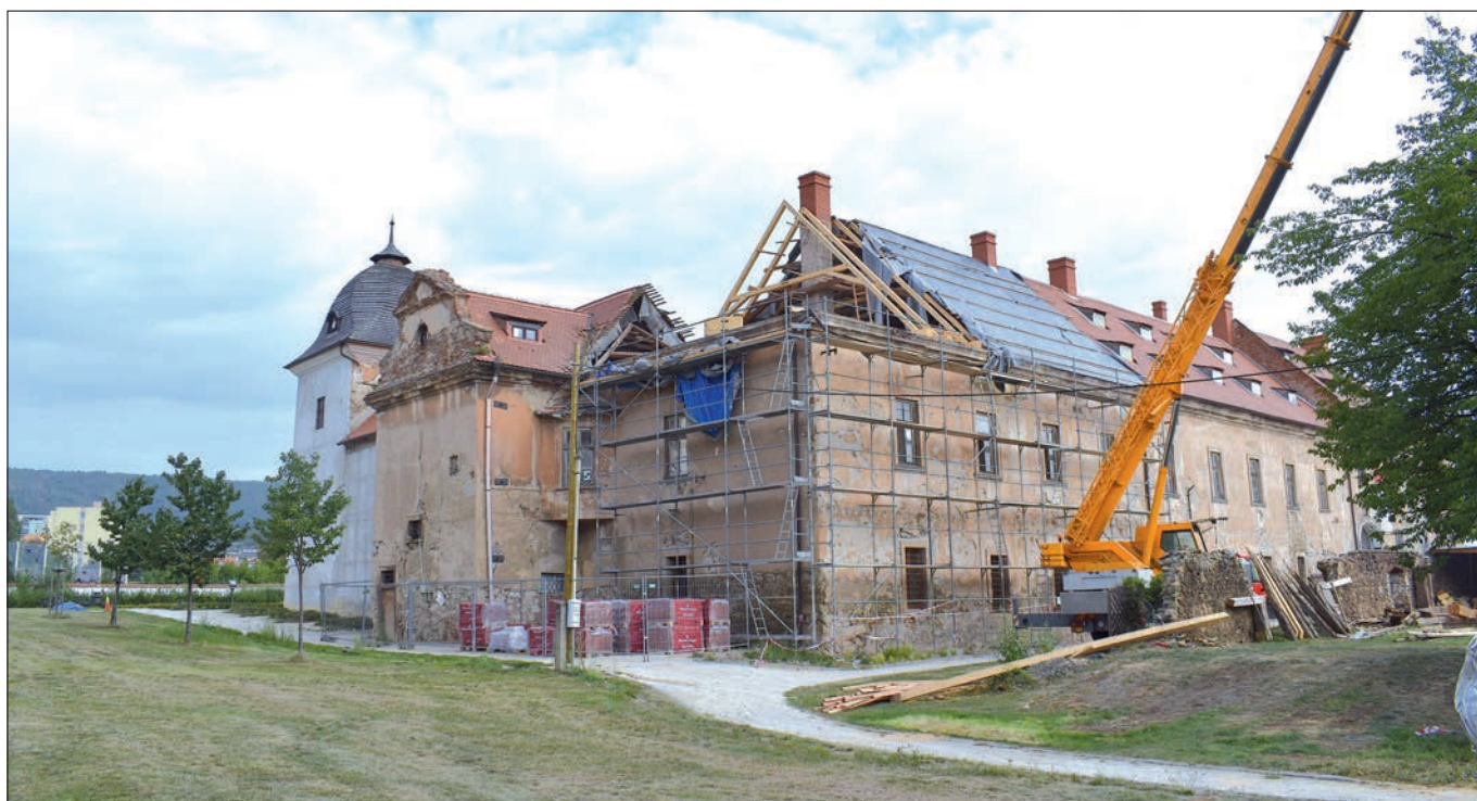
Králův Dvůr (správní obvod ORP Beroun), jihozápadní nároží zámku, pohled na rozsah rekonstrukce krovu a krytiny v rozpracovanosti (foto D. Havlíková, 2022).
