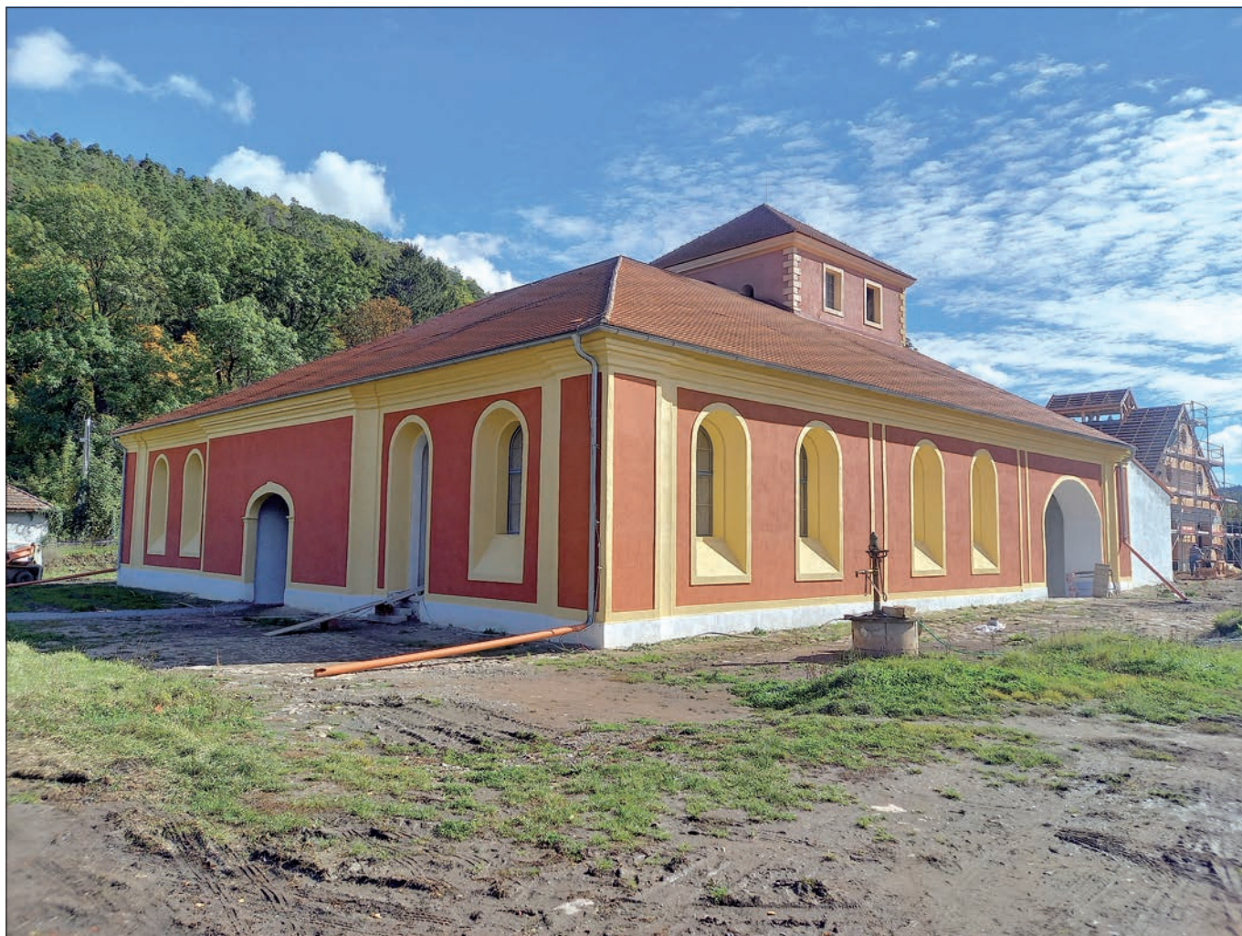
Jince (správní obvod obce Příbram), dřevouhelná vysoká pec Barbora, fasáda objektu po obnově, říjen 2022 (foto O. Hrdlička).
