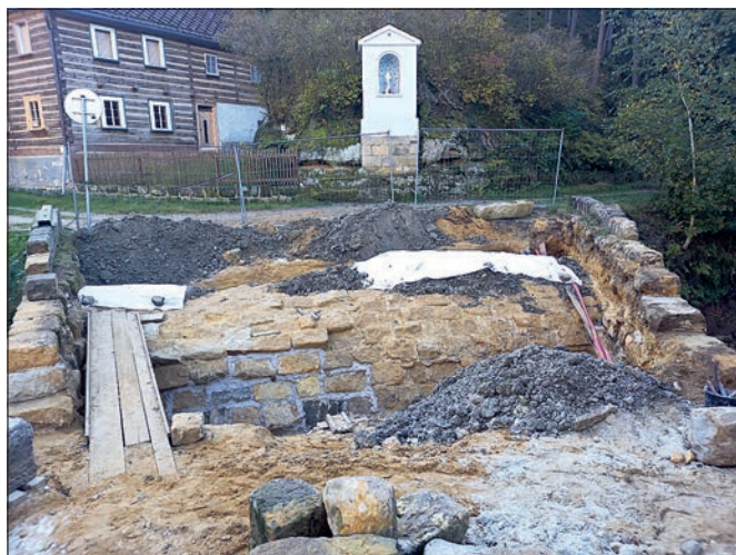
Ráj u Mšena (správní obvod obce Mělník), mostek přes Pšovku, stav po odhalení rubu klenby, říjen 2022 (foto O. Hrdlička).
