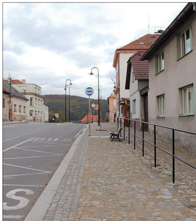
Stříbrná Skalice (správní obvod obce Říčany), OP. V souvislosti s rekonstrukcí průtahu obcí byla přilehlá zádlažba pochozích komunikací v rozsahu ochranného pásma i v jeho prostředí provedena z kamenných odseků na místo stávajících asfaltových povrchů a betonové zámkové dlažby. Při akci byl kladen důraz na využití všech původních kamenných obrub a další kamenné zádlažby. Problematický byl výběr veřejného osvětlení, které by splňovalo jak technické požadavky na nasvětlení komunikací a přechodů, tak vyhovovalo i po estetické stránce do historického prostředí. Zvoleno bylo osvětlení firmy Rosa Elstav OW Led (foto J. Černochová).
