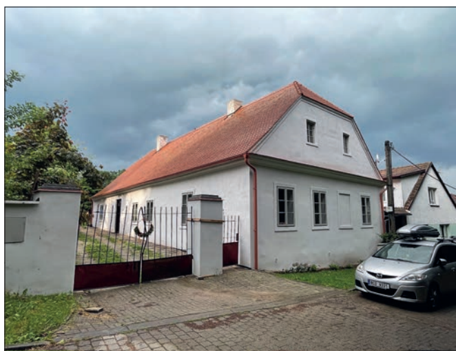
Neustupov (okres Benešov), fara, celková obnova. Celková obnova fary, která byla ještě nedávno v havarijním stavu a jejíž krytina byla zcela degradovaná, byla v tomto roce téměř dokončena. V minulých letech zde byla opravena střecha a okení výplně. Letos bylo provedeno odvlhčení, statické zajištění a doždění operádků u narušené východní obvodové zdi budovy fary. Téměř dokončené jsou také úpravy interiérů přízemí pro bydlení (foto D. Primusová).
