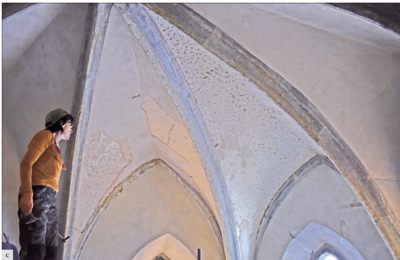
Kolín (správní obvod ORP Kolín), chrám sv. Bartoloměje: a – interiér Kokovské kaple, nálezná situace odkrytá po sejmutí podlahy a násypu v kapli, byla odhalena patní partie raně gotického portálu (foto D. Havlíková, stav 2021); b – interiér Kokovské kaple, zaměření nalezeného portálu u vstupu do kaple (nákres F. Laval 2021); c – interiér Kokovské kaple, nálezná situace na klenbě odkrytá po částečném sejmutí omítek z přelomu 19. a 20. století. Jsou viditelné pekované barokní omítky, polychromie na žebrech a malovaná bordura kolem žeber (foto D. Havlíková).
