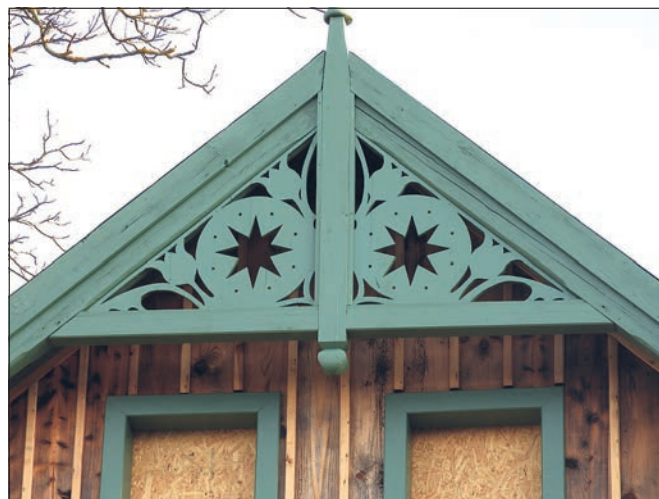
Víska (správní obvod obce Mladá Boleslav), VPR čp. 7. Detail ozdobné výplně ve vrcholu štítu, jejíž ornamentální řezba byla rekonstruována na základě dochovaných dobových fotografií (foto J. Berková).
