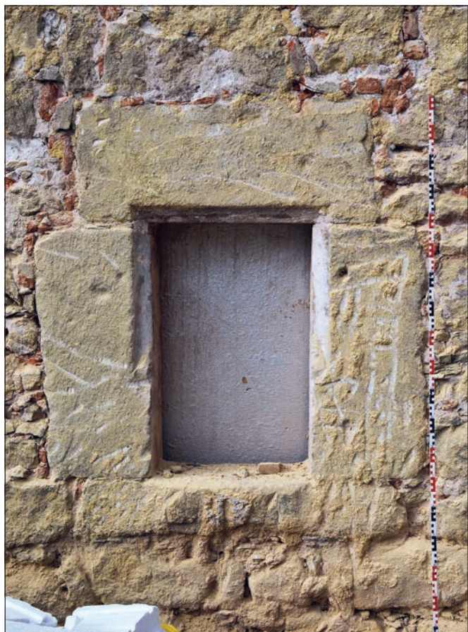
Rakovník (okres Rakovník), dům Grillova čp. 227 – Odkryté pozdně gotické okno s pískovcovým ostěním je nejen hodnotným památkovým detailem, ale i důležitým pramenem zpřesnění datace i srovnání s analogiemi a zařazení domu do dobové stavební produkce ve městě (foto V. Jesenský, 2022).
