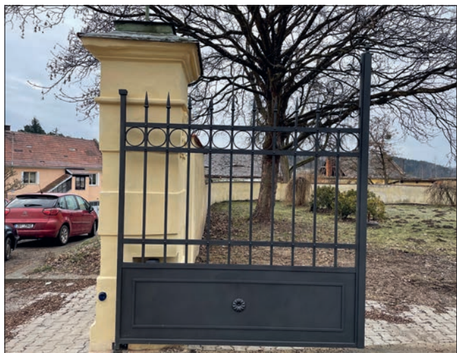
Vojkov (okres Benešov), zámek, obnova zámecké brány. V předdvorí zámecké budovy byla nefunkční a nevhledná novodobá křídla vrat a branky vyměněna za nová, která byla navržena podle analogických kovových konstrukcí, které se nacházejí v areálu zámku (foto D. Primusová).
