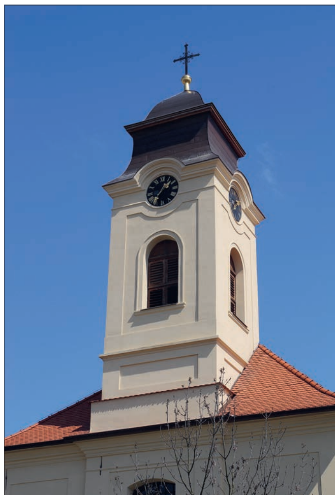
Kostelní Lhota (správní obvod obce Nymburk). Kostel před opravou působil celkem nevábně a jeho vzhled výrazně pozvedla poslední oprava. Znehodnocené členění fasád bylo velice zdařile obnoveno podle nákresů Ing. Markéty Gottwaldové na základě starých fotografií. Prosadila tu i jednobarevnost, která je v tomto případě patřičná a přispívá k vizuální celistvosti průčelí (foto V. Láška).
