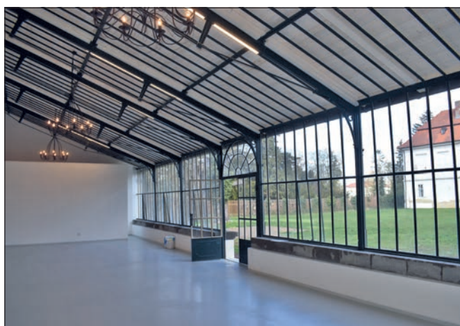
Liteň (správní obvod ORP Beroun), oranžerie v zámeckém areálu: a – celkový pohled na opravenou oranžerii; b – pohled do interiéru po opravě. Zásadním počinem bylo navrácení kopie vstupních dveří vyhotovených podle archivní fotografie. Původní prosklení střechy se neobnovovalo (foto D. Havlíková, únor 2023).
