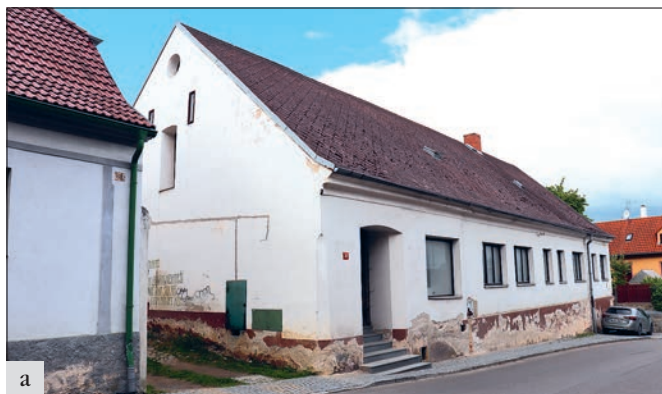
Sedlec-Prčice (správní obvod obce Sedlčany), MPZ, Sedlec čp. 69: a – vzhled domu byl ve 2. polovině 20. století narušen nevhodnou úpravou okenních otvorů a výplní; b – obnova okenních otvorů a jejich osazení adekvátními dvojitými okenními výplněmi pomohly výrazně rehabilitovat podobu historického domu (foto J. Černochová).
