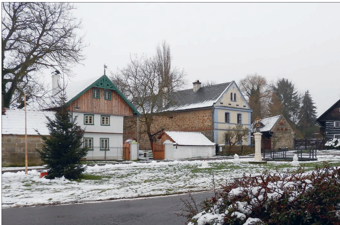
Víska (správní obvod obce Mladá Boleslav), VPR. Dům usedlosti čp. 7, stav průčelí po dokončení obnovy. V rámci akce byla na roubené stěny vrácena štuková omítka s lizénami v nárožích, doplněna ostění oken s navrácením profilovaných říms a menších oken s členěnými křídly. Novodobá makovička byla nahrazena hrotnicí s replikou původní korouhve s datací (foto J. Berková).
