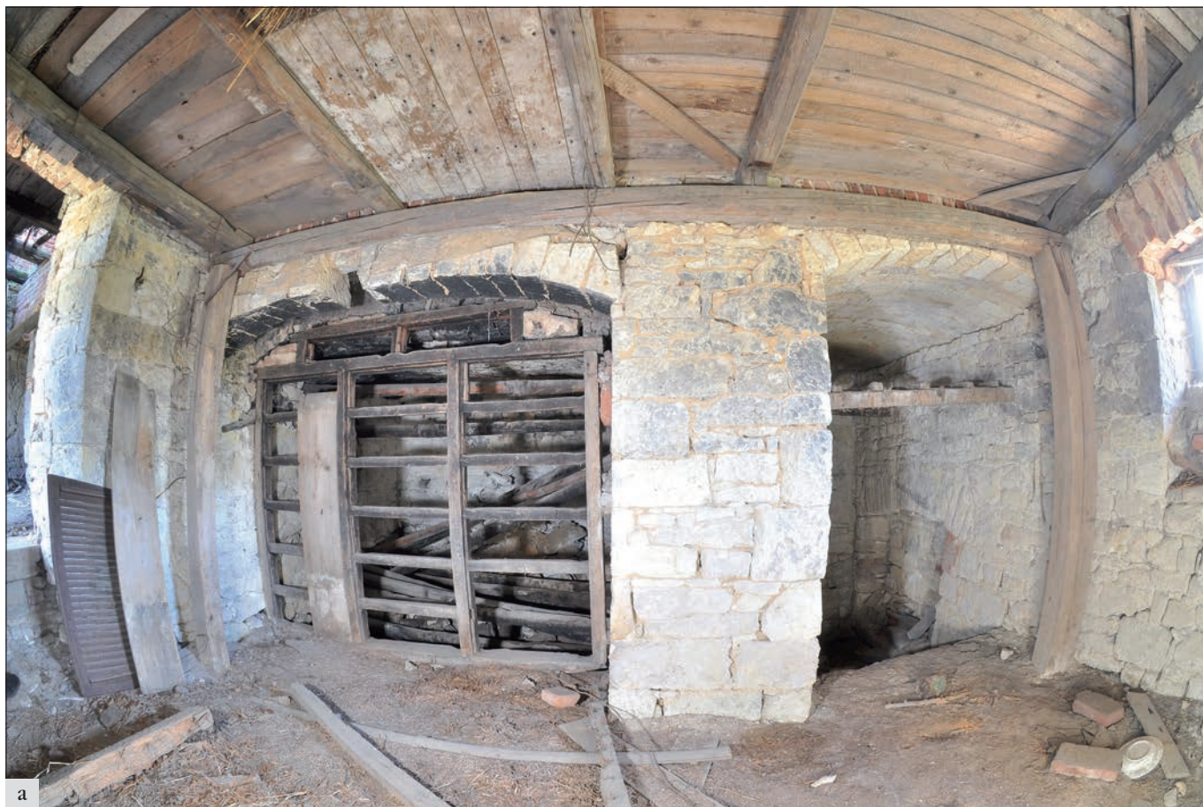
Kroučová (okres Rakovník), sušárna švestek v areálu usedlosti čp. 20: a – Celkový pohled na západní stěnu síně starší části sušárny. Vlevo dřevěný rám v ústí sušící komory, se zásuvkami pro lísy s ovocem, vpravo vstup do prostoru pro obsluhu vyhřívací pece (foto J. Veselý, 2022); b – Rekonstrukce původní podoby starší části objektu sušárny. Plán ukazuje ideální podobu, včetně nedochované vyhřívací pece, jež byla převzata z publikace Jiřího Trejbalu Třebízské sušárny. Třebíz 1979 (zaměření a kresba J. Veselý, 2022).
