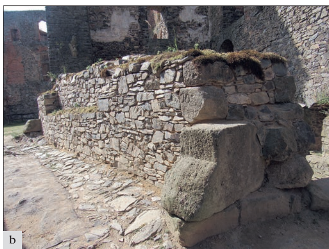
Krakovec (správní obvod obce Rakovník), a – obnova částečně zřícené zídky mezi 1. a 2. nádvořím s nálezem štětových dlažeb, jejichž skřívka pokračuje k hlavní bráně (foto M. Bergel); b – obnovená zídka s první vrstvou zadrnování (foto D. Konstatská).
