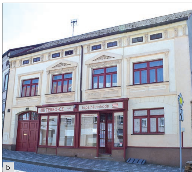
Mšeno, dům čp. 262: a – původní stav; b – stav po obnově (foto P. Kalinová).
