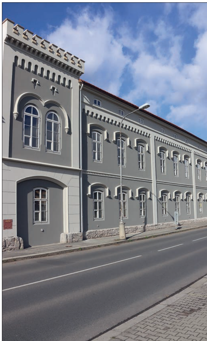
Kutná Hora, bývalý Tellerův cukrovar. Zcela degradované omítky exponované jižní fasády si vyžádaly rekonstrukci architektonického členění, ukončující prvky cimbuří byly ochráněny deskami z umělého kamene. Pozitivním efektem byl návrat k historické barevnosti kombinující teple šedý a krémový odstín, doložené jak nálezy na chráněné dvorní fasádě, tak i archivně a ikonograficky (foto A. Pospíšil).
