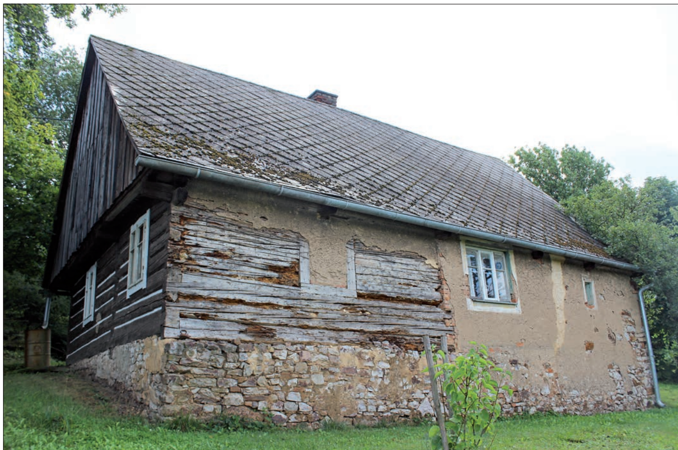
Kleštěnice (okres Beroun), dům čp. 18, celkový pohled od severozápadu. Částečně roubený dům na podezdívce z lomového kamene obsahuje původní trojdílné jádro, později v jižní části přezděné. Vlevo je patrné severní průčelí s předstupujícím, svísele bedněným štítem a okny do světnice a světničky, dále západní podélné průčelí s roubenou stěnou světničky se zazděným oknem a navazující zděnou částí světničky a komorou. Na celém západním průčelí se nacházejí zbytky hrubé béžové omítky s hladce utaženými obílenými pásy kolem oken (foto A. Jankulíková).
