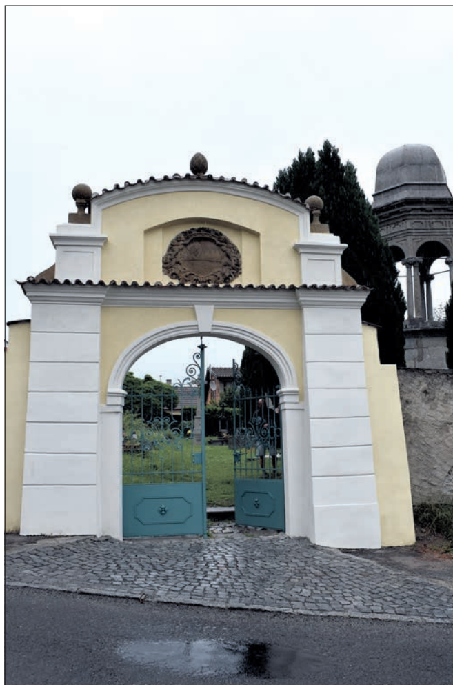
Votice (správní obvod obce Votice), areál Božího hrobu, brána, celková obnova. Kromě obnovy omítek, zakrytí horních ploch a kovových křídel výplně barokní brány, byly zrestaurovány i kamenné prvky. Opraveny byly také přilehlé úseky ohradní zdi hřbitova, včetně dvou výklenkových kaplí (foto D. Primusová).
