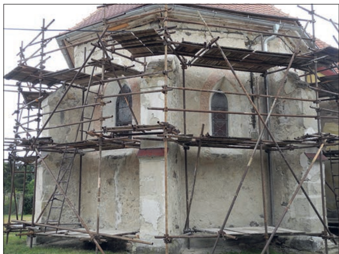
Řitonic (správní obvod obce Mladá Boleslav), kostel, presbytář v průběhu prací statického zajištění a konzervace omítek. Na průčelí se ve spodní vrstvě zachovala omítka s paspartami oken s iluzivními cihlami, která je cenným dokladem úpravy průčelí presbytáře z předbarokního období. Omítky byly restaurátorský zajištěny. Dále bylo provedeno vyklínování a hloubkové spárování trhlin, u opěráků i částečné znovu osazení uvolněných kvádrů, aby byla zajištěna jejich stabilita a nemusely být prováděny další z památkového hlediska nežádoucí zásahy do zdiva a základů (foto E. Vyletová).
