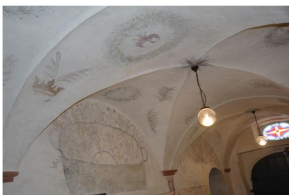
Stav po dokončení 1. etapy – Aplikace odsolovacích zábalů
