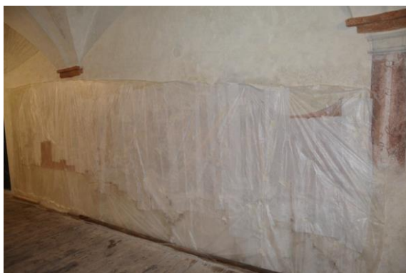
Stav po dokončení 1. etapy – Aplikace odsolovacích zábalů
