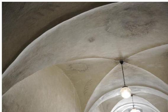
Stav po vytmelení klenby a horní části stěn
