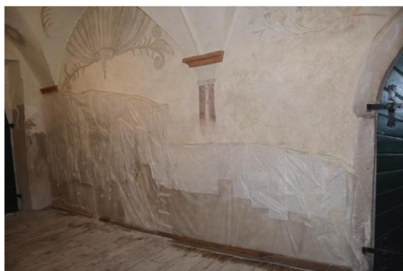
Stav po dokončení 1. etapy – Aplikace odsolovacích zábalů
