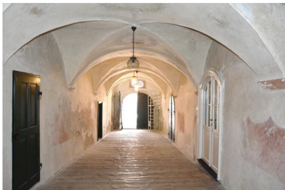
Stav po vytmelení klenby a horní části stěn
