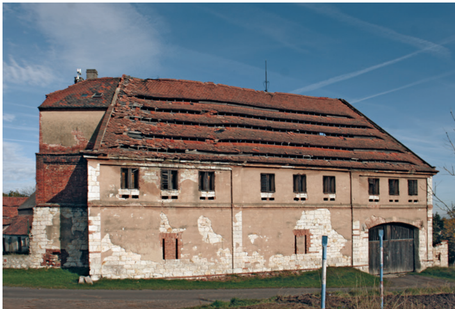
3.4 Sušící půda s pásovými vikýři a polopatro s žaluziovými okenicemi větracích otvorů, hvozdová sušárna v obci Dobříčany na p. č. 20, foto: Roman Švec 2016.
