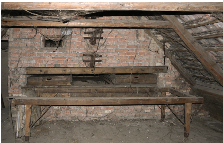
3.18 Manipulační prostor hvozdů s lísami a vozíkem, sušárna chmele v obci Zahořany, p. č. 35-1, foto: Roman Švec 2017.
