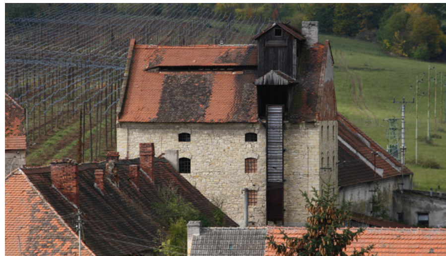
2.9 Sušárna chmele v kontextu chmelářské obce Nečernice, p. č. 1/1, foto: Jaroslav Skopec 2017.
