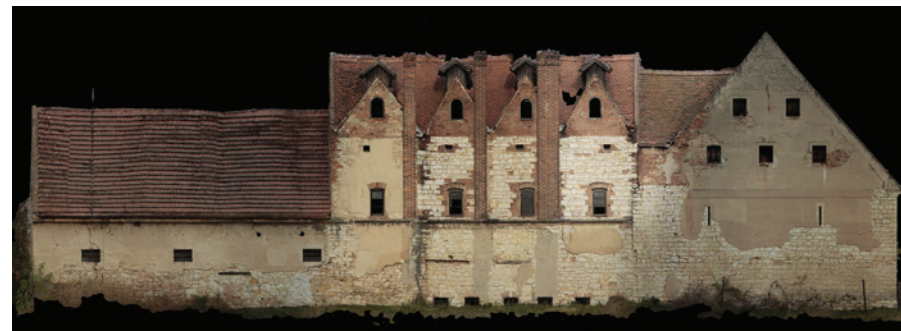
4.1 Ortofotomozaika jižního průčelí čtyřhvozdové sušárny chmele v Trnovanech u Žatce, č. p. 9, autoři: Jan Horák, David Skalický 2017.
