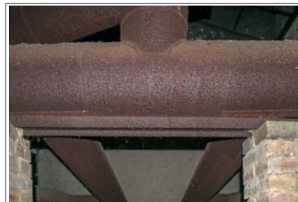
010 – Pohled na teplovzdušný rozvod
