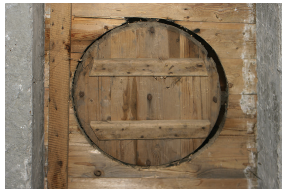
3.19 Detail žokovacího otvoru, sušárna chmele v obci Kněževěs, p. č. 792-1, foto: Monika Stará 2017.
