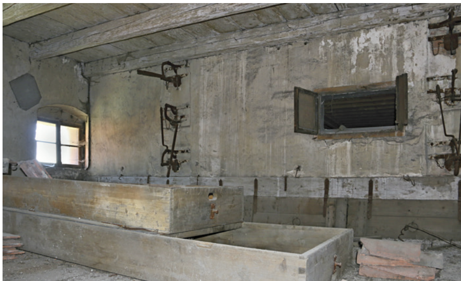
2.8 Chmelová půda u sušící komory jižního hvozdu, sušárna chmele v obci Horní Ročov, p. č. 13/1, foto: Roman Švec 2017.
