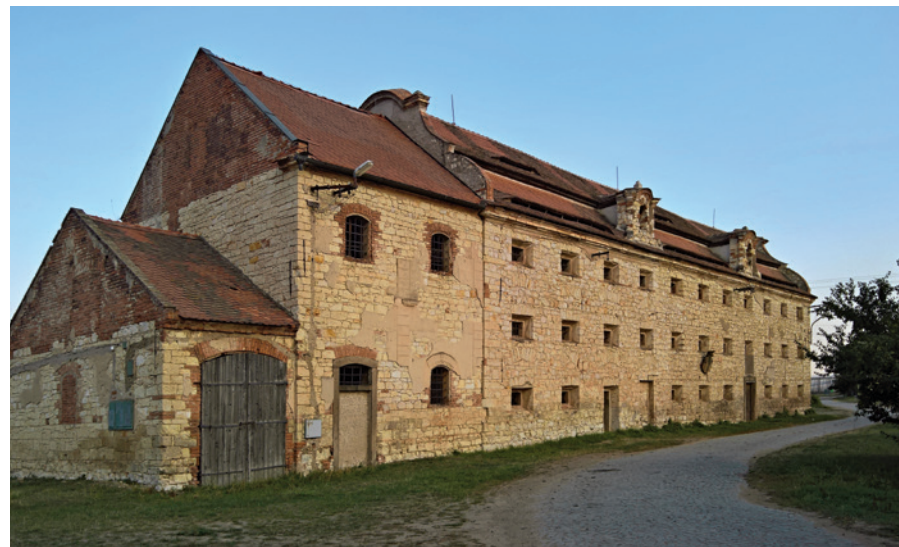
2.1 Sušárna chmele v obci Stekník, p. č. 41, prodělala složitý stavební vývoj od vrcholně barokní sýpky s monumentální rokokovou přestavbou až ke hvozdové sušárně chmele s uhelnou.
