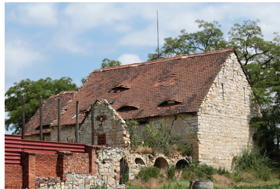
3.8 Vikýře ve tvaru volských ok otevírají střešní valbu ve dvou úrovních na pasivní sušárně v obci Dubčany, p. č. 32. Střešní valbu sousedního objektu otevírá pásové vikýř, foto: Roman Švec 2018.
