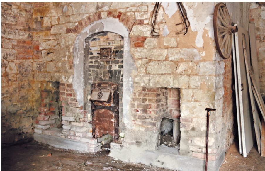
3.15 Topeniště hvozdu, sušárna chmele v obci Dubčany, p. č. 3, foto: Roman Švec 2017.
