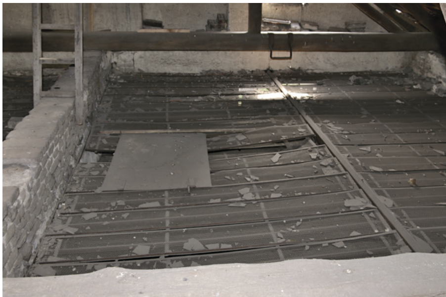
3.17 Pohled do sušící komory na ocelové žaluzie, hvozdová sušárna v obci Hořesedly, p. č. 15-13, foto: Roman Švec 2017.
