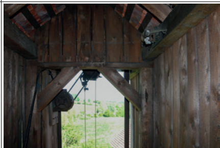
008 – Pohled elektrický na pohon vrátku
