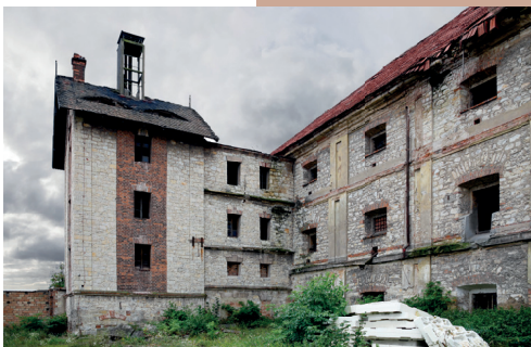
Března chmelu na p. l. 1807 v areálu bývalého schwarzenberského statku.
