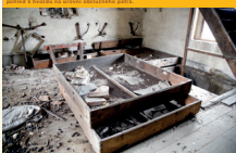
Března chmelu na p. l. 1807 v areálu bývalého schwarzenberského statku, pohled z venku na první úhelníkové patro.
