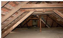
Střecha, stávek na p. č. 58. Podkroví stávků před jeho zánem a v době vzniku oboustranné funkce jako právně.
