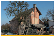
Sušárna na p. č. 62 v Nové Vsi.
