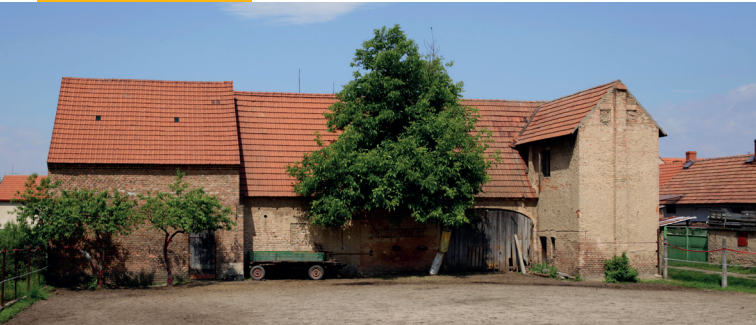
sušárna na p. 1. 91 v Dobrušce
