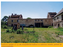
Chmelnic v usedlosti č. p. 58, hospodářská budova se sušárnou chmele, patřící do usedlosti č. p. 58.
