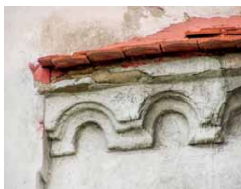
Detail obloučkového vlysu apsidy rotundy. Foto: Jan Koloc, 2006.
