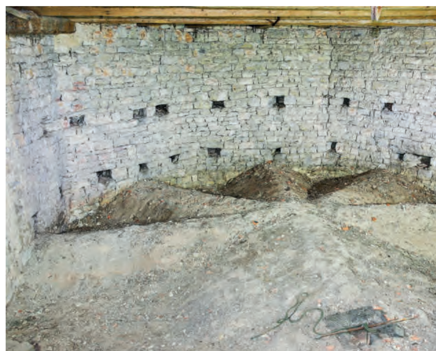
Smolnice, naděždíka obvodového zdiva presbytáře nad úrovní klenby s patrným systémem pravidelně rozmístěných kapes po trámčích lešení. Foto: Kateřina Neumannová, 2015.
