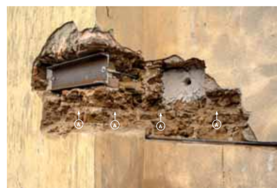
Detail jihovýchodního nároží lodí a přilehlého koutu svíraného s presbytářem. Ve struktuře zdí, která je shodná pro loď i presbytář, je patrná zarovnaná řada ukončená utaženou vrstvou malty, po jejímž zatvrdnutí na ni byla nanášena vrstva došl. A – Tato situace zřejmě vznikla po přerušení stavby a zároveň dokládá, že loď a presbytář byly stavěny v jedné etapě. Foto: Jaroslav Skopec, 2013.
