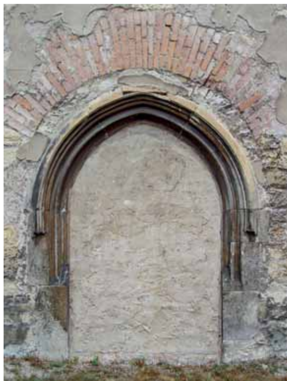
Čelní pohled od jihu na jižní portálu patrové předsíň. Foto: Jaroslav Skopec, 2017.
