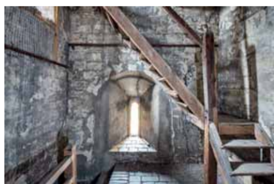
Západní strana prvního patra věže s nikou exteriérového vstupu opatřené zazdívkou, v níž je otevřen okenní otvor. Foto: Marta Pavlíková, 2018.
