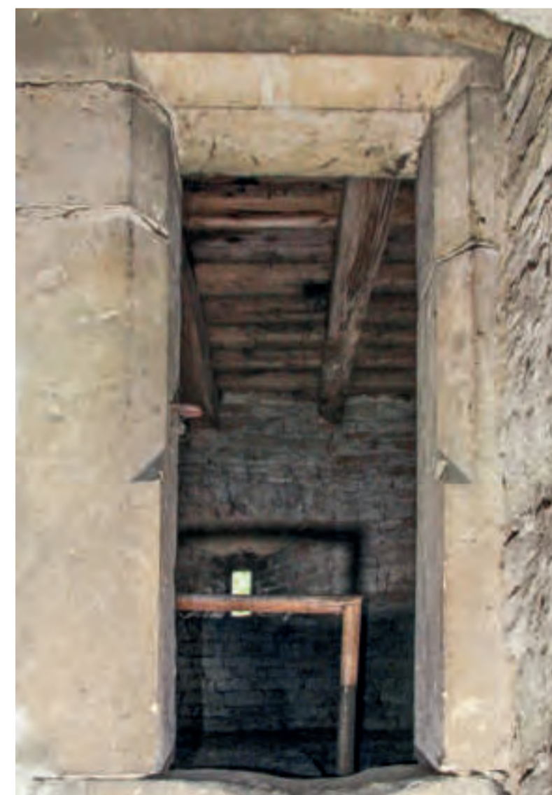
Obara, portál směřující ze schodiště v tloušče zdi do druhého patra věže. Foto: Jaroslav Skopec, 2018.
