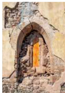
Čelní pohled od východu na východní okenní otvor presbytáře. Foto: Marta Pavlíková, 2020.
