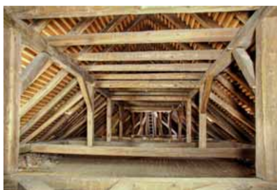
Průhled krovem nad lodí s pohledem k východu. Foto: Jaroslav Skopec, 2019.
