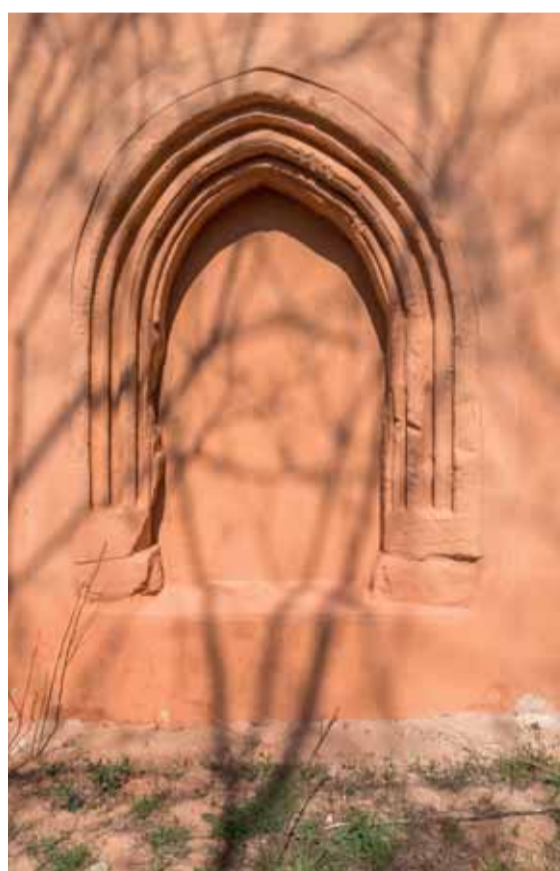
Čelní pohled od jihu na jižní hrotitý portál lodi. Foto: Marta Pavlíková, 2020.
