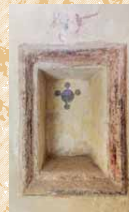
Čelní pohled od severozápadu na odkládací niku umístěnou v jihovýchodní stěně zdivu presbytáře. Foto: Marta Pavlíková, 2022.
