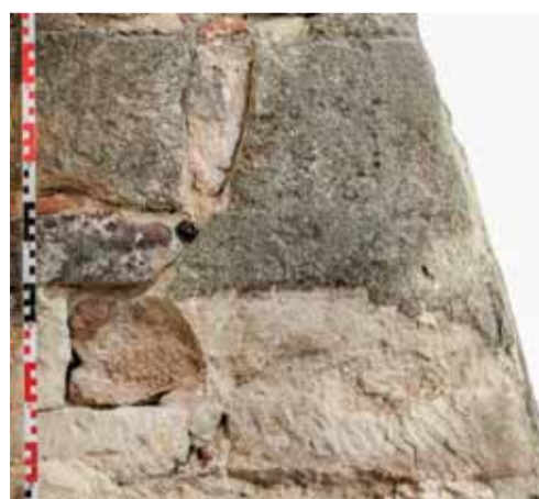
Fotoplán části dílu středověkého okenního ostění druhotně využitého jako zdicí materiál jihovýchodního opěrného pilíře presbytáře. Zaměření a kresba: Jaroslav Skopec, 2020.
