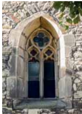
Čelní pohled od východu na východní okenní otvor presbytáře. Foto: Marta Pavlíková, 2019.
