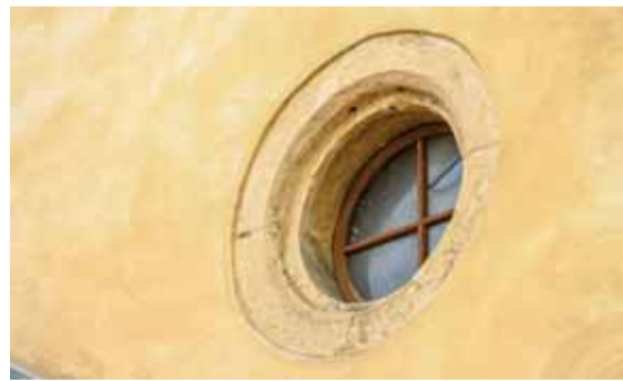
Severní kruhový okenní otvor kruchty v pohledu od severozápadu. Foto: Jaroslav Skopec, 2015.
