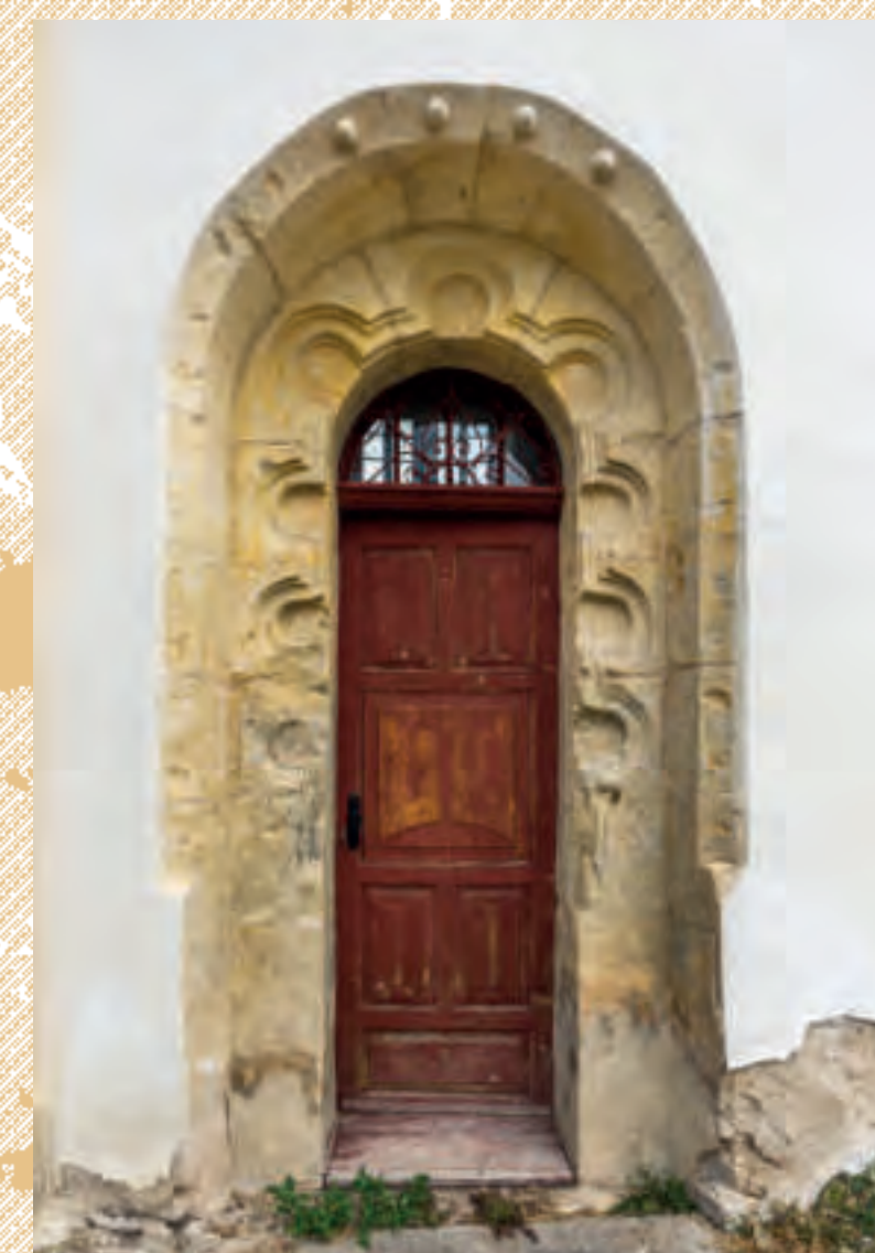
Želkovic, čelní pohled od jihu na jižní portál lodi. Foto: Marta Pavlíková, 2019.
