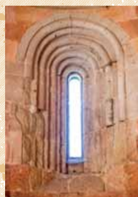
Čelní pohled od západu na východní okenní otvor apsidy. Foto: Kateřina Neumannová, 2016.
