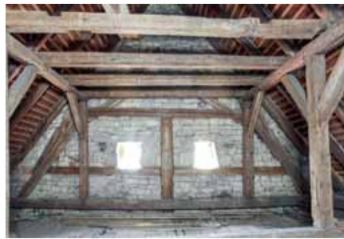
Průhled krovem k západu. Ve štítě je zazděna konstrukce krovu, jehož trámy byly dendrochronologicky datovány do roku 1550. Foto: Jaroslav Skopec, 2019.
