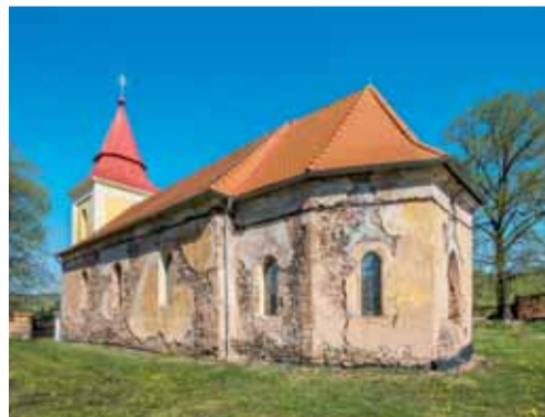
Celkový pohled od jihovýchodu. Foto: Marta Pavlíková, 2020.
