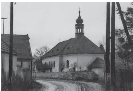
Celkový pohled na areál kostela od východu. Na snímku z 50. let 20. století je kostel zachycen ještě s předsíní, sakristií a ohradní zdí. Zdroj: NPÚ GR, Sbirka negativů, sign. N170847.
