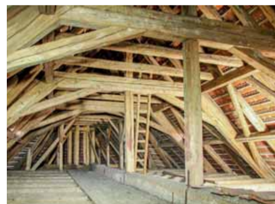
Průhled krovem lodí směrem k východu. Foto: Jaroslav Skopec, 2018. Prvky barokního krovu byly dendrochronologicky datovány do sezóny 1722/23. Na snímku je patrný průvlak, který společně se stropními trámy byl druhotně využit ze stropu dendrochronologicky datovaného do rozmezí let 1543 až 1545.
