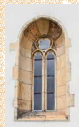
Čelní pohled od jihu na jihovýchodní okenní otvor lodi. Třinácti čtveřice dílů ostění zókulku a spodní díl levé západní stojky jsou středověkého původu. Foto: Jaroslav Skopec, 2020.
