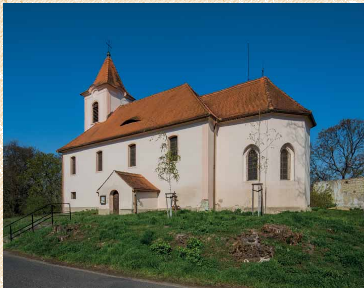
Celkový pohled od jihovýchodu. Foto: Marta Pavlíková, 2019.
