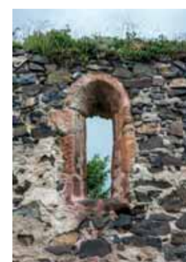
Detail středního gotického okenního otvoru jižní strany kostela. Foto: Marta Pavlíková, 2019.
