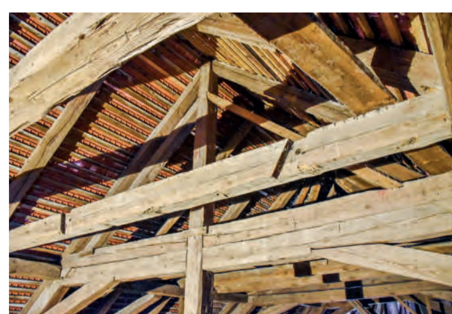
Vinařice, kostel sv. Jiljí, krov lodi. Krokev druhotně použita jako hambalek pocházející z pozdně gotického krovy datovaného 1439/40 (d). Foto: Michal Panáček, 2018.
