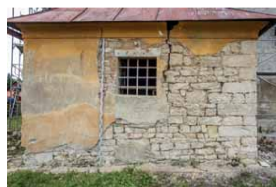
Čelní pohled od severu na severní průčelí sakristie s patrným nárožním armováním. Okenní otvor byl na stávající velikost zvětšen v roce 1900 a jako jeho překlad byla využita stolka ostění předešlého pozdně gotického otvoru. Foto: Jaroslav Skopec, 2015.
