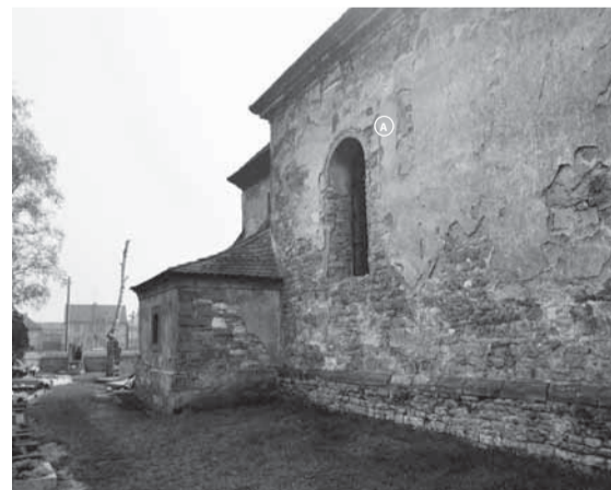
Východní část severní strany lodi a sakristie v pohledu od severozápadu na snímku z roku 1987. Zdroj: NPÚ ÚOP v Ústí n. L., Sbírká negativů, sign. 95900. A – Zazděný středověký okenní otvor.
