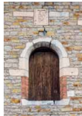
Detail východního zvukového otvoru třetího patra věže a nad ním zazděné kamenné desky. Foto: Marta Pavlíková, 2018.
