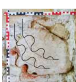
Čelní pohled od severu na fragment dlu ostění středověkého portálu v zadní části severního portálu lodi. Do snímku jsou zakresleny jedny z možných rekonstrukcí profilu ostění vycházející z analogických příkladů. Foto a zářez: Jaroslav Skopec, 2015.
