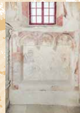
Čelní pohled od severu na sedle umístěné v jižní stěně presbytáře. Foto: Marta Pavlíková, 2022.
