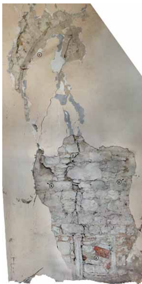
Výřez z fotoplánu jihovýchodní stěny závěru presbytáře. A – Ostění středověkého odkládacího výklenku. B – Dochované parapetní části ostění středověkého okenního otvoru. C – Část odhaleného záklenku mladšího okenního otvoru.
