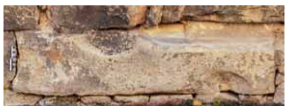
Díl stajky ostění portálu pozdně gotického charakteru, který je zazděný v ohradní zdi po jižní straně sakristie. Foto: Jaroslav Skopec, 2018.
