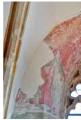
Detail kružby východního okenního otvoru gotického presbytáře v pohledu od západu. Foto: Kateřina Neumannová, 2016.
