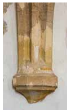
Detail severní konzoly gotického presbytáře. Foto: Marta Pavlíková, 2019.
