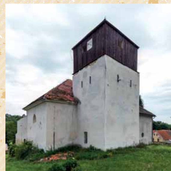
Celkový pohled od severovýchodu. Foto: Marta Pavlíková, 2018.
