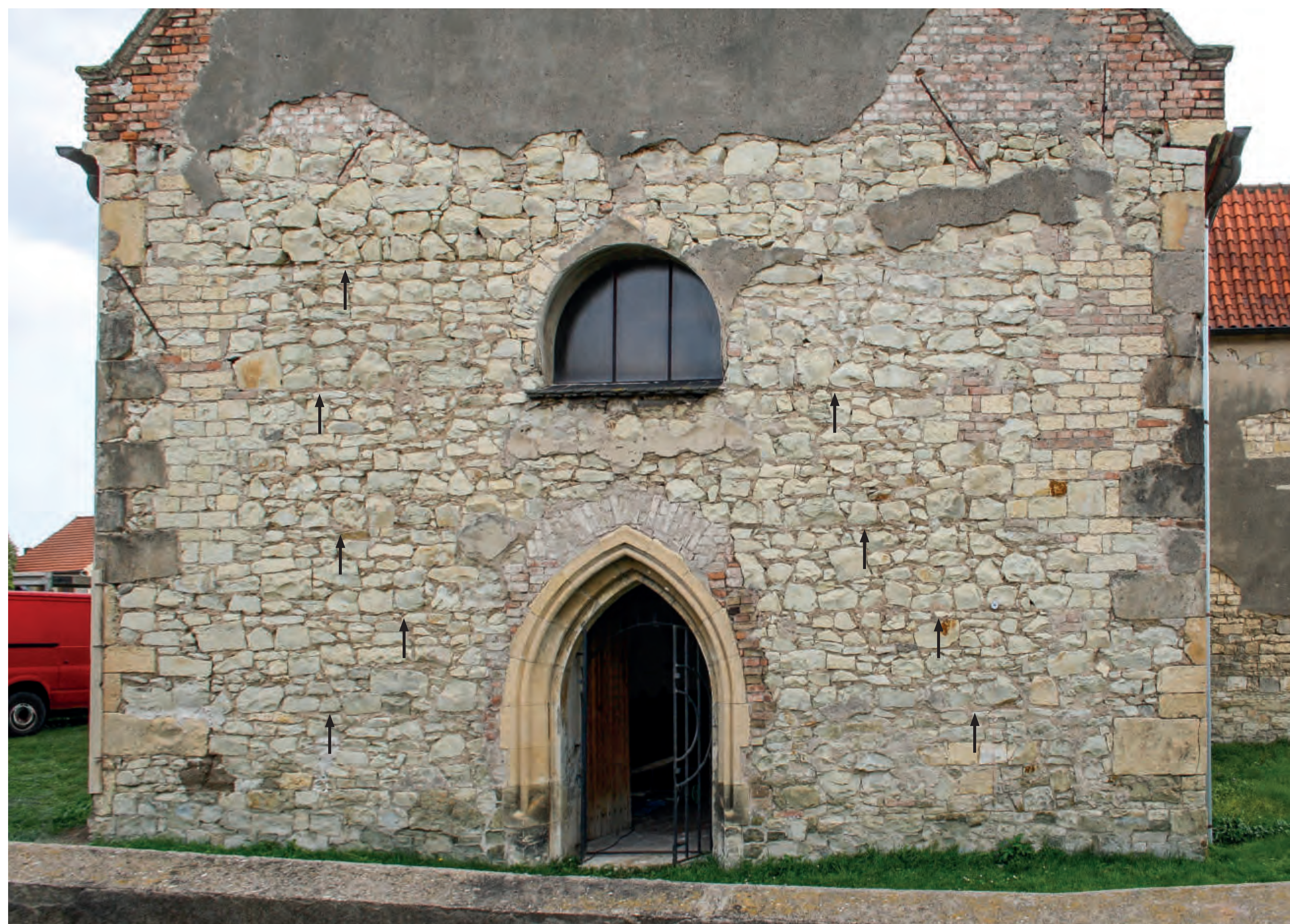
Dobroměřice, západní průčelí lodi s patrným přezděním nároží a zejména s horizontálními liniemi v lomovém zdivu oddělujícími jednotlivé pracovní úseky. Foto: Jaroslav Skopec, 2017.
