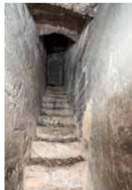
Spodní rameno schodiště v tloušťce zdi věže s pohledem k západu na podestu se zazděným okenním otvorem. Foto: Marta Pavlíková, 2019.
