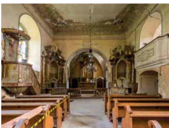
Pohled do interiéru lodi směrem k východu. Foto: Marta Pavlíková, 2019.
