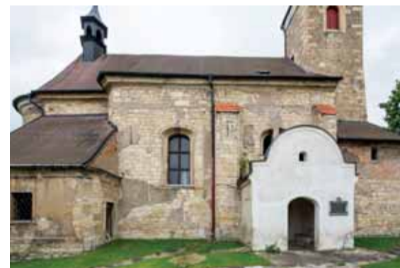
Severní strana kostela v pohledu od severu. Mezi předsíní a sakristií jsou opět v hojném množství využity ve zdivu románské a gotické kvádry. Foto: Marta Pavlíková, 2014.
