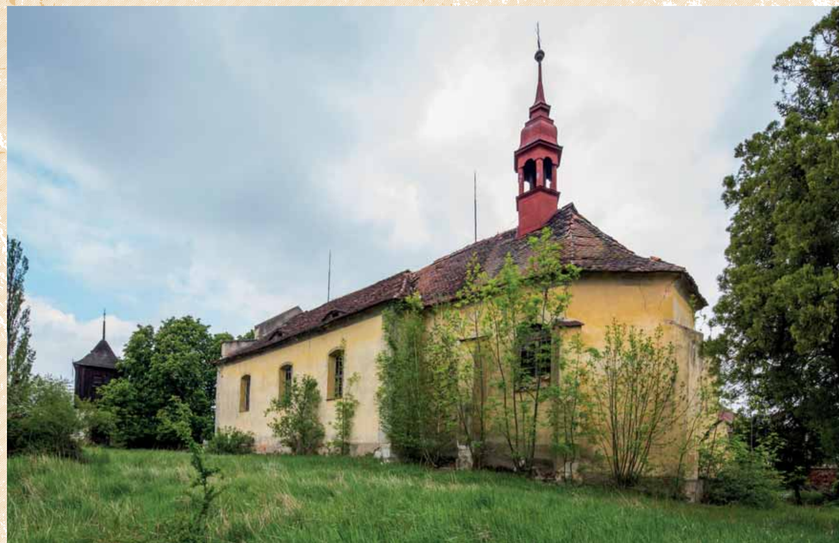
Celkový pohled od jihovýchodu. Foto: Marta Pavlíková, 2019.
