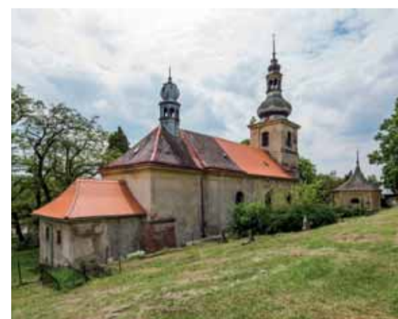
Celkový pohled od severovýchodu. Foto: Marta Pavlíková, 2020.
