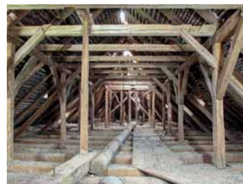
Průhled krovem lodi a presbytáře směrem k východu. Foto: Jaroslav Skopec, 2019.
