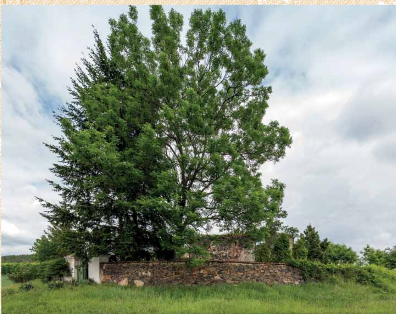
Celkový pohled od jihovýchodu. Foto: Marta Pavlíková, 2019.
