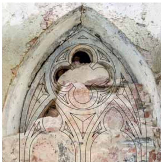
Fotoplán odhaleného fragmentu kružby východního hrotitého okenního otvoru presbytáře se zářezem možné rekonstrukce. Foto a zářez: Jaroslav Skopec, 2015.
