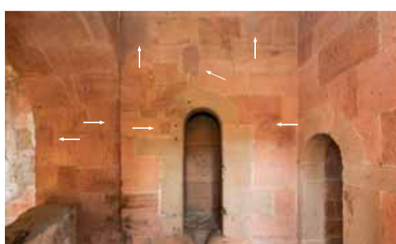
Interiér východní prostory prvního patra věže s pohledem k jihu. V čele vstup do schodiště v tloušče zdi, napravo vstup do západní prostory s trezorem, vlevo široký klenutý otvor na někdejší románskou tribunu, s druhým parapetem. Šipkami jsou vyznačeny zazděné kapsy po dřevěných trámčích, které sem byly dodatečně vkládány v době utilitárního využití kostela v 19. století. Foto: Kateřina Neumannová, 2016.
