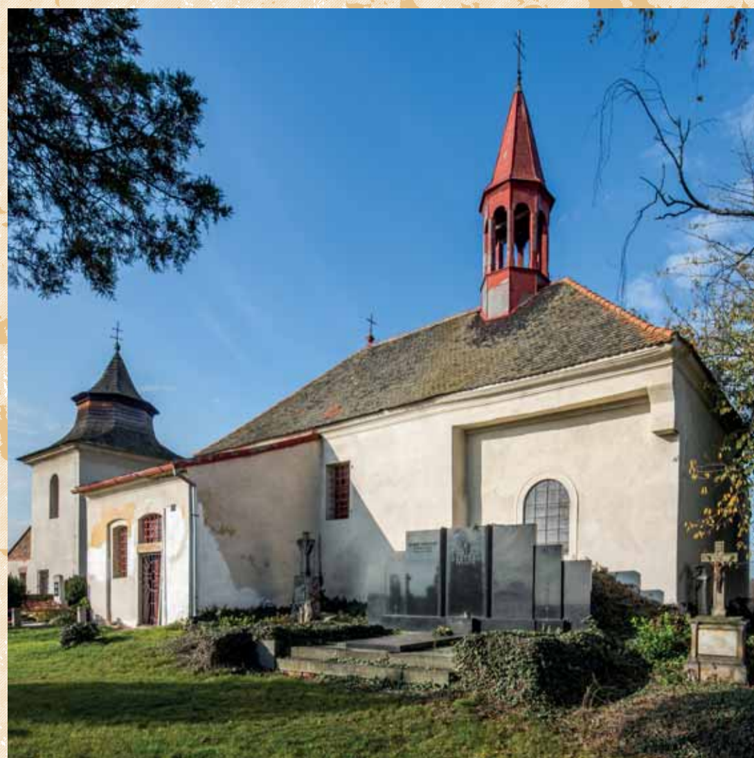
Celkový pohled od jihovýchodu. Foto: Marta Pavlíková, 2020.
