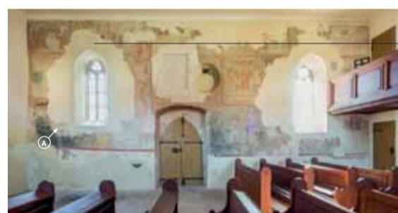
Čelní pohled od severu na jižní stěnu lodi. A – Pravoúhlé zalomení spodního pásu dokládající existenci středověkého bočního oltáře. Foto: Marta Pavlíková, 2018.
