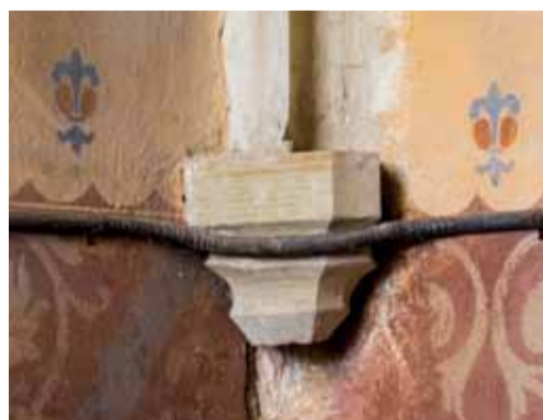
Detail severozápadní konzoly presbytáře. Foto: Marta Pavlíková, 2019.
