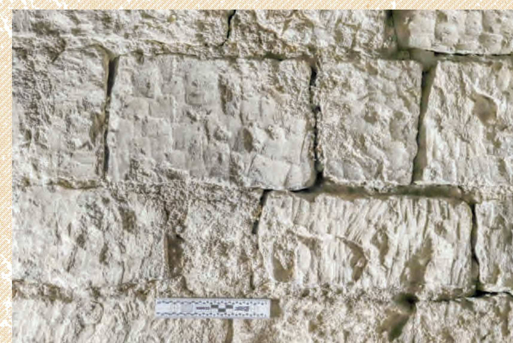
Rané, detail opracování kvádrů v interiéru prvního patra věže. Foto: Michal Cihla, 2019.
