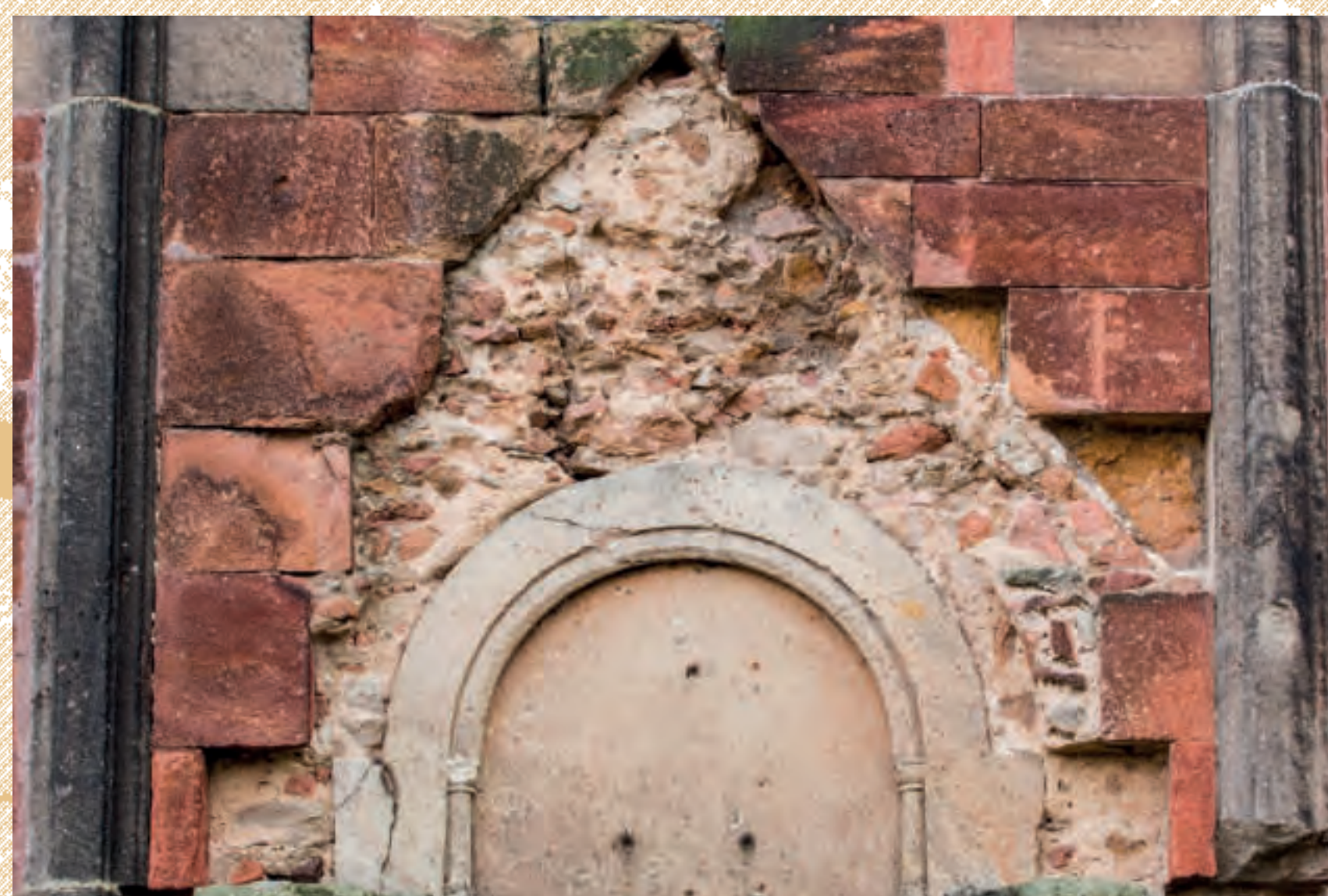
Vroutek, odhalená část jádrového zdiva v místě odstraněného vimperku jižního portálu lodi. Foto: Kateřina Neumannová, 2016.
