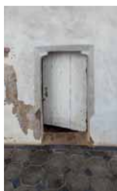
Čelní pohled od západu na západní portál lodi vedoucí do podvěží. Foto: Marta Pavlíková, 2019.
