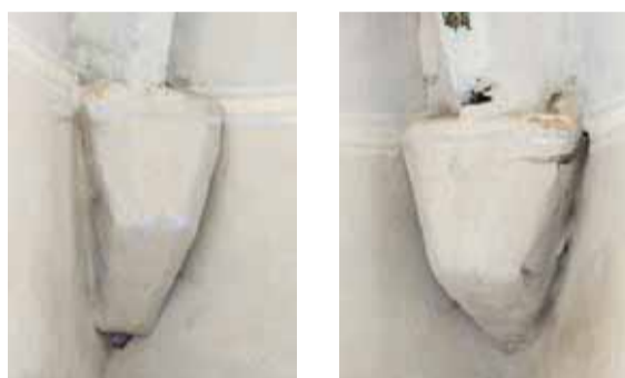
Detail severovýchodní konzoly klenby presbytáře. Foto: Kateřina Neumannová, 2016.
