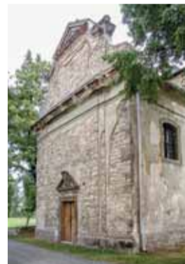
Západní průčelí lodi v pohledu od jihozápadu s odhaleným lícem zdiva a rozvolněnou strukturou nárožního armování. Foto: Tomáš Brož, 2006.
