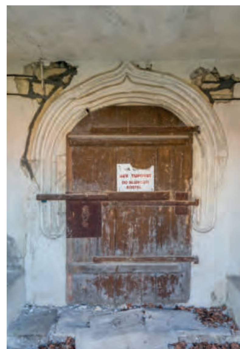
Rané, čelní pohled od severu z předsíně na severní portál. Foto: Marta Pavlíková, 2020.
