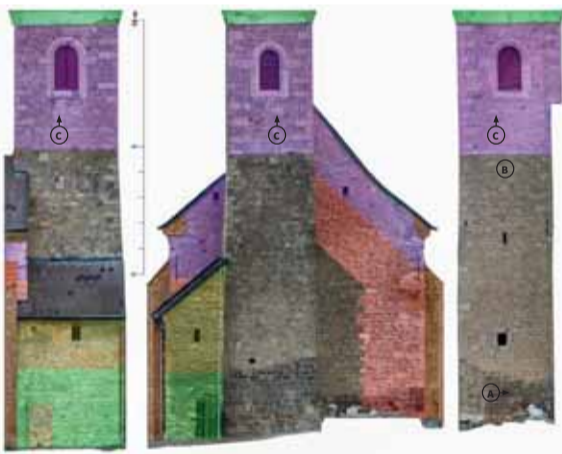
Zleva: fotoplán severního, západního a jižního průčelí věže. Sedlá – rozsah románského zdiva, které bylo ve vyšších partiích na exteriéru částečně přezděno, v interiéru však zůstalo zachováno. Červená – vrcholné gotické. Fialová – pozdně gotické. Hnědá – 80. léta 18. století. Zelená – 20. léta 19. století. Žlutá – první polovina 20. století. A – Zazděný štěrbinový otvor přízemí věže. B – Dolní část uzavřené ramánské galerie nad podzemní galerií sružených otvorů. C – Zazděné štěrbinové otvory odstraněných hodinových ciferníků.
