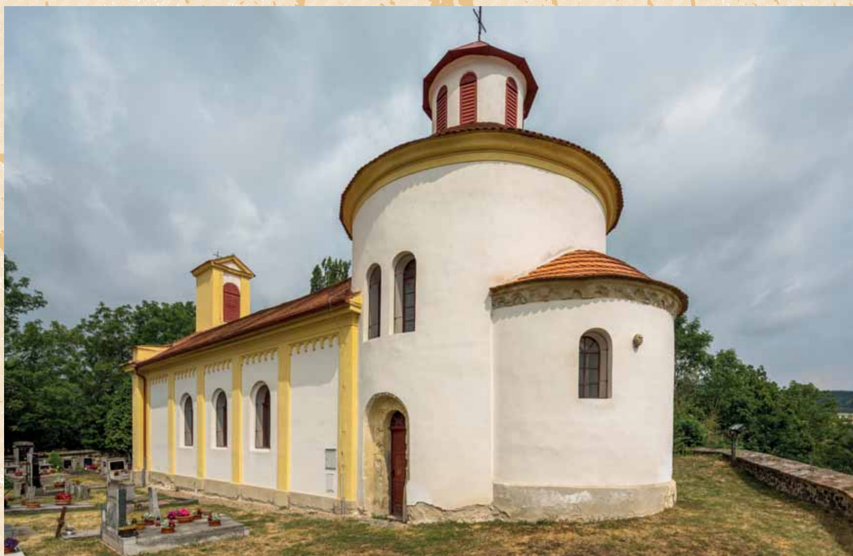
Celkový pohled od jihovýchodu. Foto: Marta Pavlíková, 2019.
