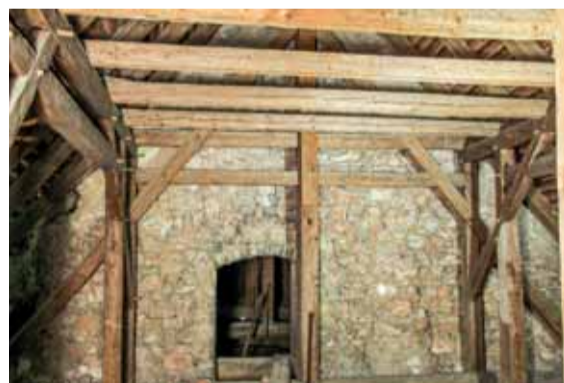
Krov nad lodí a její východní štít v pohledu od západu. Opukové zdivo štítu je zřetelně ponižené požárem, který kostel zachvátil v roce 1802. Foto: Jaroslav Skopec, 2018.
