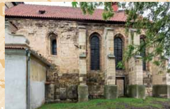
Jižní průčelí lodi a presbytáře v pohledu od jihu. Foto: Marta Pavlíková, 2014.
