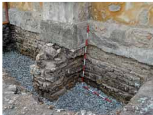
Střední část jižní strany mariánské kaple s odhaleným základovým zdivem a základem osového opěrného pilíře, který byl druhotně využit jako základ pro současný náhrobek. Foto: Vojtěch Peksa, 2017.
