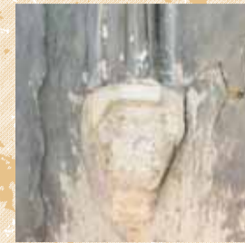
Detail severozápadní konzoly sakristie. Foto: Marta Pavlíková, 2018.
