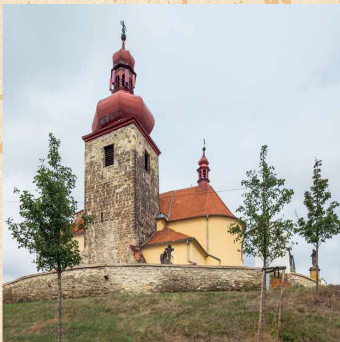
Celkový pohled od jihovýchodu. Foto: Marta Pavlíková, 2019.
