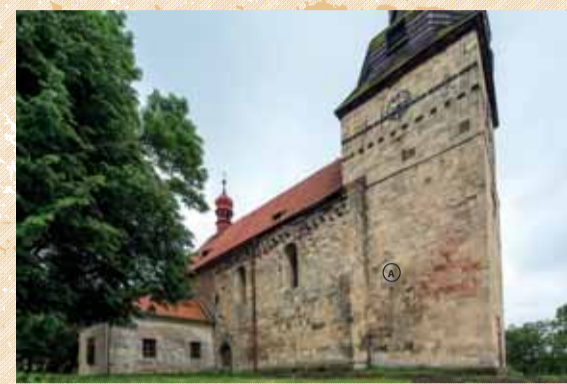
Severní průčelí kostela v pohledu od severozápadu. Foto: Marta Pavlíková, 2014. A – Zazděný vstup do prvního patra věže.
