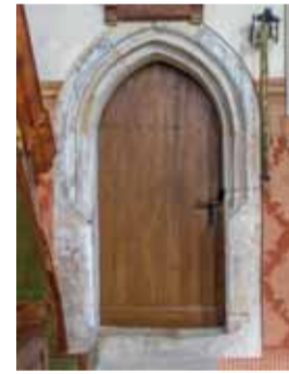
Čelní pohled od jihu na portál vedoucí z presbytáře do sakristie. Foto: Jan Kaloc, 2009.
