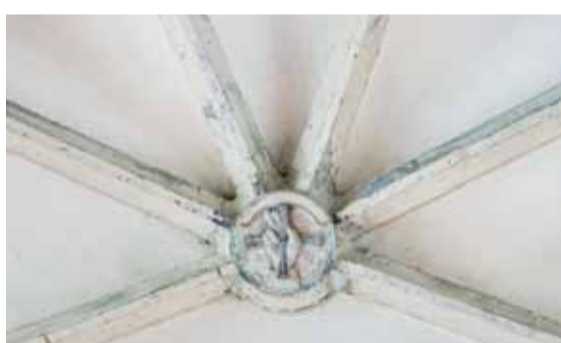
Detail závěrového svorníku klenby presbytáře. Foto: Marta Pavlíková, 2018.
