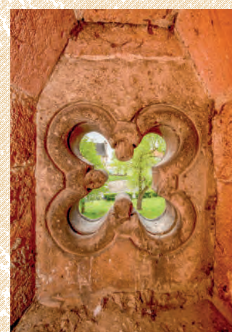
Vroutek, čelní pohled od severu na spodní okenní otvor schodiště v tlušče zdi. Foto: Kateřina Neumannová, 2016.
