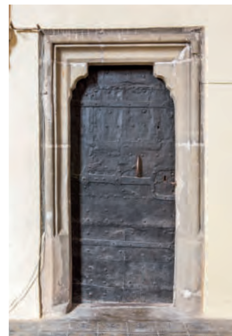
Vrbno nad Lesy, čelní pohled od jihu na portál vedoucí z presbytáře do sakristie. Foto: Marta Pavlíková, 2019.
