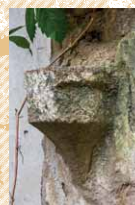
Detail konzoly presbytáře osazené ve východjihovýchodním koutě závěru presbytáře. Foto: Marta Pavlíková, 2019.
