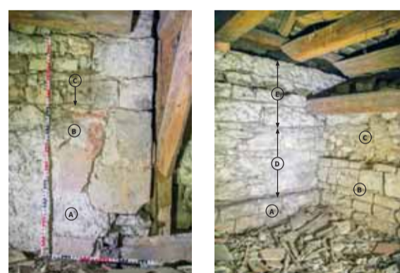
Detail dochované omítkové úpravy severovýchodního nároží lodí pozorovatelného od východu z krovu nad sakristií. Pohled do jihozápadního kouta presbytáře nad rubem klenby. A – Jižní pozdně gotické zdivo presbytáře. B – Východní pozdně gotické zdivo lodí nad úrovní vítězného oblouku. C – Nadezdvíka z počátku 18. století se zřetelným lícem přizdívaným patrně k později odstraněnému východnímu štítu lodí. D – nadezdvíka presbytáře z počátku 18. století. E – Nadezdvíka z doby výstavby současného krovu z počátku 20. století.
