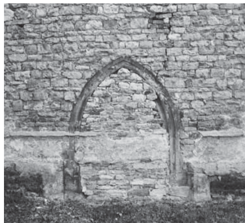
Čelní pohled od západu na zazděný západní hrotitý portál lodi na snímku z roku 1987. Zdroj: NPÚ ÚOP v Ústí n. L., Sbírká negativů, sign. 95901.
