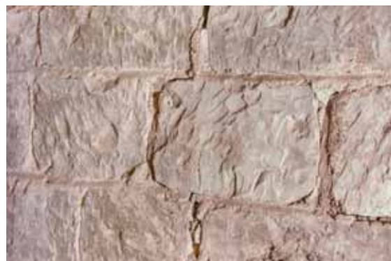
Detail kamenického opracování kvádrů a úpravy spár tzv. podřezáváním na jižní stěně prvního patra věže. Foto: Jaroslav Skopec, 2008.
