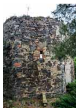
Západní zdivo kostela se šterbinovým okenním otvorem v pohledu od západu. Foto: Marta Pavlíková, 2019.
