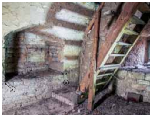
Interiér prvního patra věže s pohledem k severovýchodu. Na snímku je patrný východní okenní otvor s ostěním určeným pro osazení výplně a severní nika sloužící pro odkládání cenností, či sezení, jak to naznačují dochované zbytky prkenného obkladu parapetu (A). Foto: Jaroslav Skopec, 2018.
