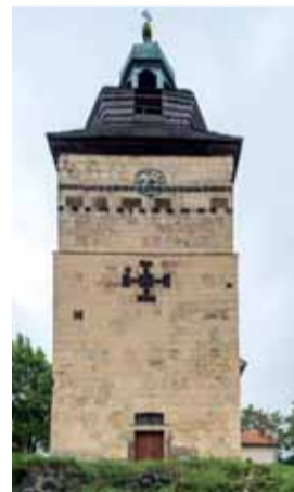
Západní průčelí věže v pohledu od západu. Foto: Marta Pavlíková, 2014.
