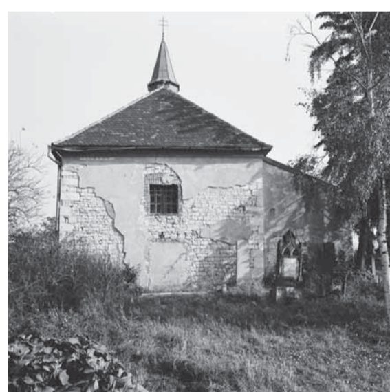
Západní průčelí lodí s odhalenou strukturou líce zdiva na fotografii z roku 1987. Zdroj: NPÚ ÚOP v Ústí n. L., Sběrka negativů, sign. 96233.
