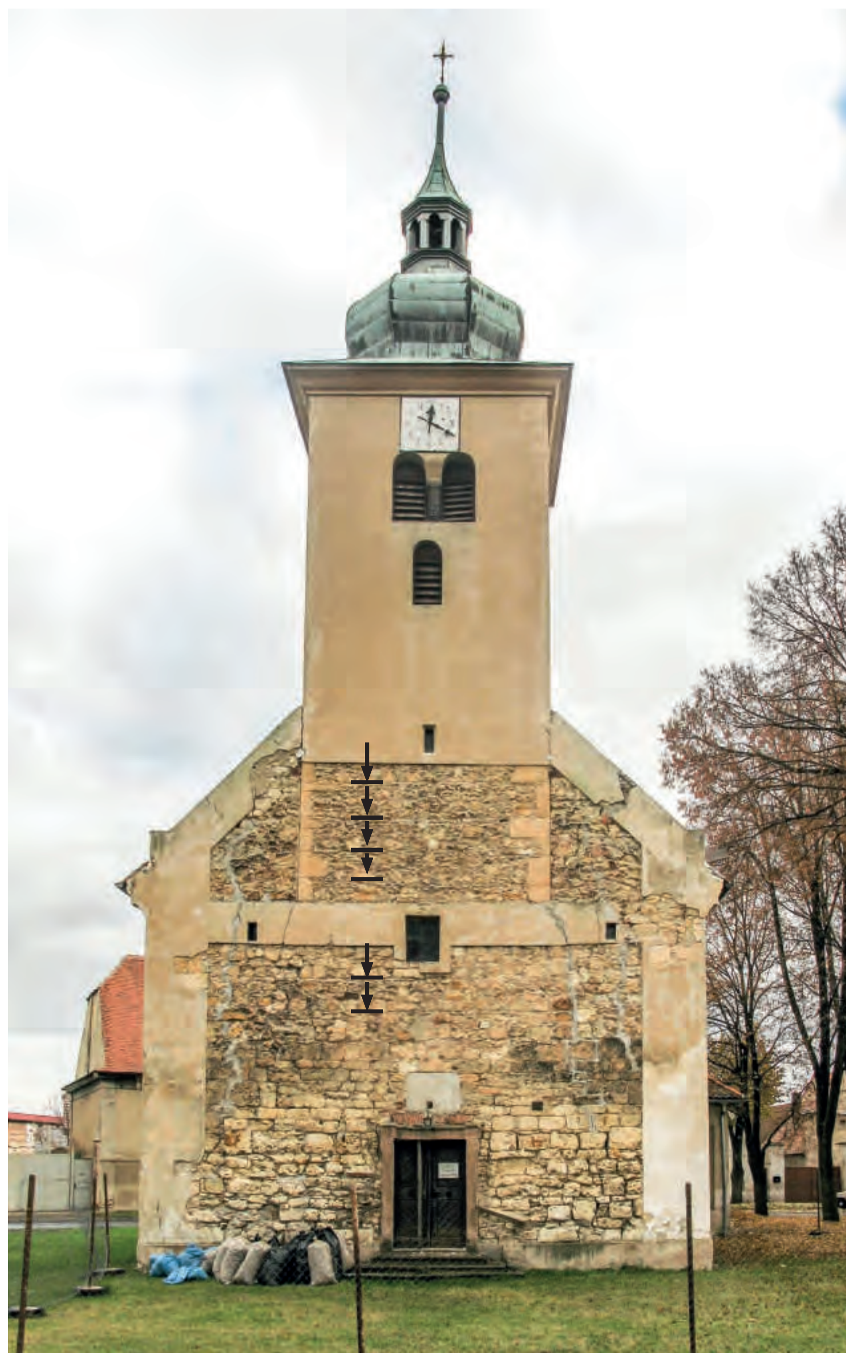
Lenešice, západní průčelí kostela s vyznačenými horizontálními liniemi oddělujícími jednotlivé zdící úseky v lomovém zdivu. Foto: Vojtěch Peksa, 2007.
