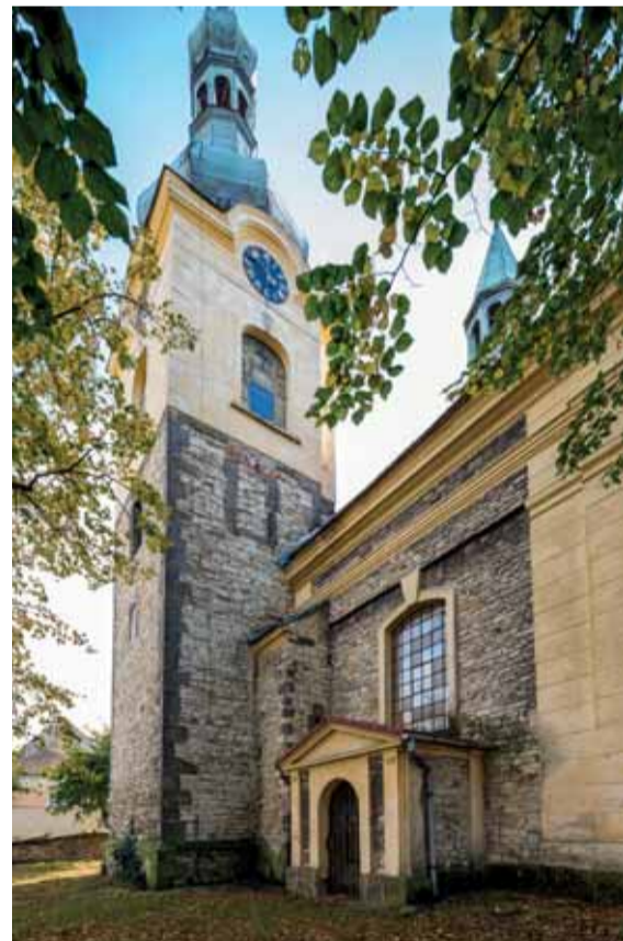
Severovýchodní strana kostela v pohledu od severozápadu. Severní okenní otvor lodi vznikl na místě dvojice menších patrně barokních otvorů na počátku 20. století, stejné jako navýšení zdiva nad klenákem otvoru. Nad zazděným obdélňým zvukovým otvorem věže je patrná středověká kamenná římsa, jejíž profil byl odsekán při navýšení věže na počátku 30. let 18. století. Foto: Marta Pavlíková, 2019.
