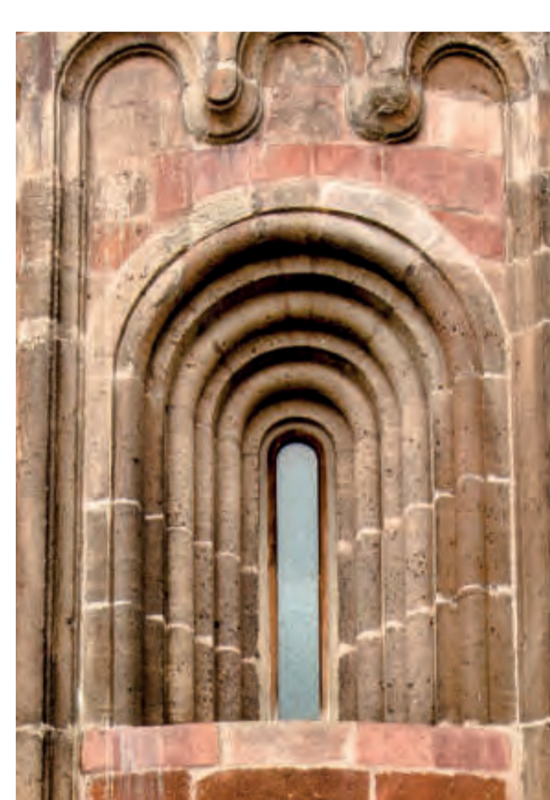
Vroutek, čelní pohled od východu na východní okenní otvor apsidy. Foto: Kateřina Neumannová, 2016.
