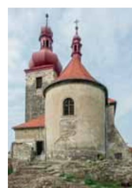
Celkový pohled od východu s patrným částečně odhaleným kvádřovým lícem zdivu presbytáře a opěrného pilíře severovýchodního nároží lodi. Foto: Jan Koloc, 2004.
