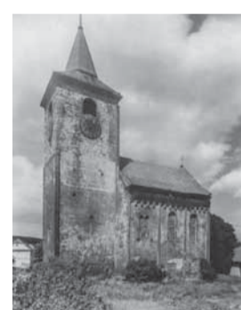
Celkový pohled od jihozápadu na snímku z roku 1953. Na fotografii je zachycen stav před opravami započatými na konci 50. let. Zvonové patro je v s výjmkou západního zdiva tvořeno lomovým kamenem, má osazené cílemky hodin a patrný je i narušený kvádrový líc přízemí věže. Okenní otvory lodi jsou opatřeny cihelnými mřížemi, stejně jako jižní dodatečný vstup. Jihovýchodní mladší otvor je již zazděn lomovým zdivem. Pod sruženým okenním otvorem lodi jsou zřetelné kapsy po zavazání trámů schodiště a otvor po zábradlí. Patrný je i starší stav dřevěné korunní římsy. Zdroj: NPÚ GŘ, Sbirka negativů, sign. N059381.
