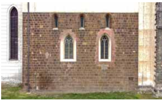
Jižní průčelí lodi v pohledu od jihu s odhalenými románskými kvádrovým lícem zdva, trojicí románských okenních otvorů, jejichž záklenky byly upraveny do zahrocených tvarů, a dvojicí vrcholně gotických hrobtých okenních otvorů. Foto: Petr Hasil, 2021.
