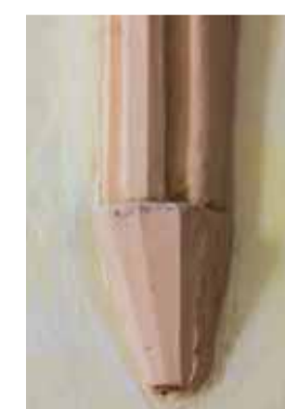
Detail jihozápadní konzoly presbytáře. Foto: Marta Pavlíková, 2019.
