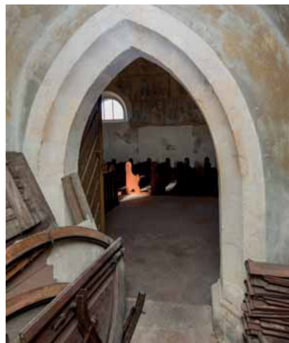
Čelní pohled od jihu z přízemí předsíňe na jižní portál lodi. Foto: Marta Pavlíková, 2018.
