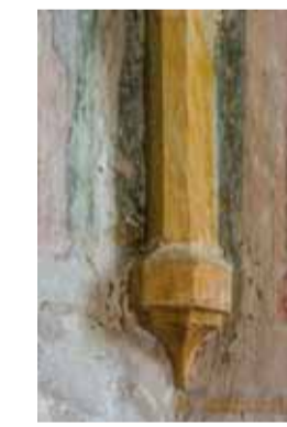
Detail východjihovýchodní konzoly gotického presbytáře. Foto: Marta Pavlíková, 2019.
