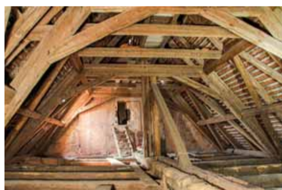
Přůhled krovem nad lodí ve směru k západu. Foto: Jaroslav Skopec, 2019.
