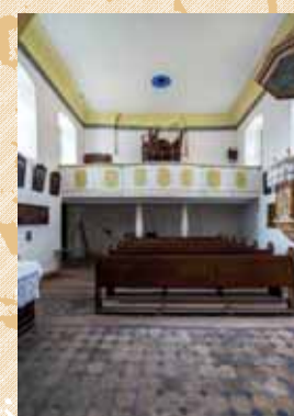
Interiér lodi s pohledem k západu. Na kruchtě za zbytky varhan je patrný ústupek ve zdivu, který může indikovat korunu zdiva románské lodi. Foto: Marta Pavlíková, 2019.
