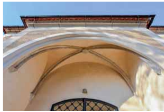
Klenba jižní předsíně v pohledu. Foto: Kateřina Neumannová, 2015.
