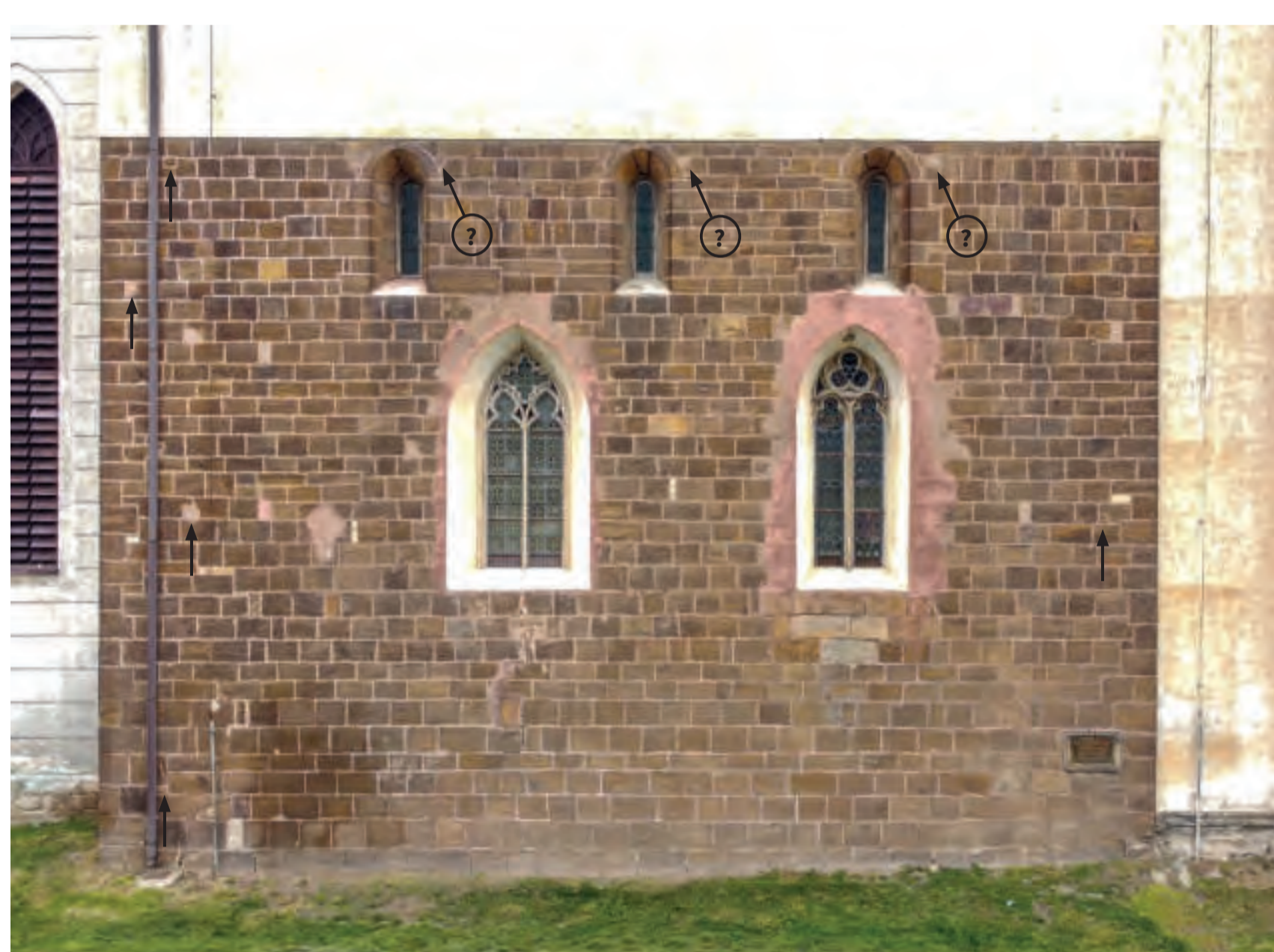
Stavětín, jižní průčelí lodi s odhaleným románským kvádrovým lícem zdiva s vyznačenou polohou zazděných kapes po trámčích stavebního lešení. Foto: Petr Hasil, 2021.
