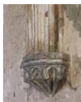
Detail jižní konzoly presbytáře. Foto: Jan Koloc, 2009.
