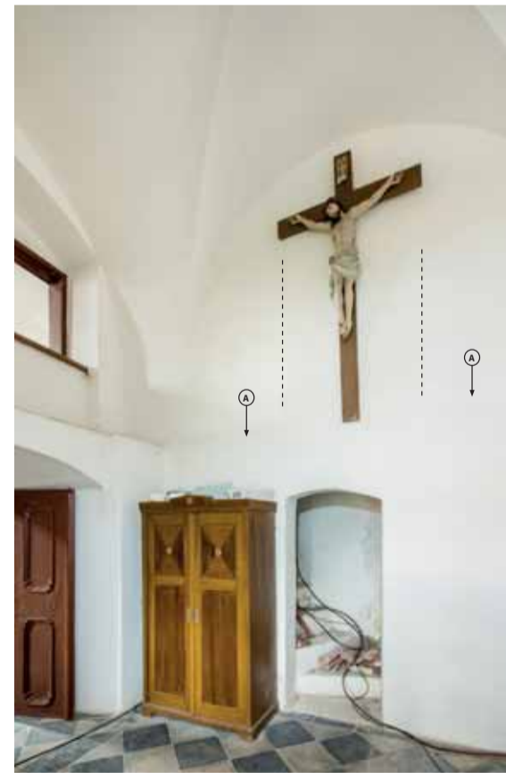
Západní strana sakristie v pohledu od východu. Přerušovanou čarou jsou vyznačeny praskliny v omítce dokládající zasedlý vstup z točitého schodiště na zvažovanou pavlač. A – Úroveň podlahy pavlače. Foto: Marta Pavlíková, 2018.
