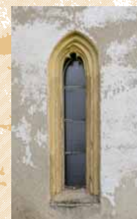
Čelní pohled od východu na východní okenní otvor sakristie. Foto: Tomáš Braž, 2013.
