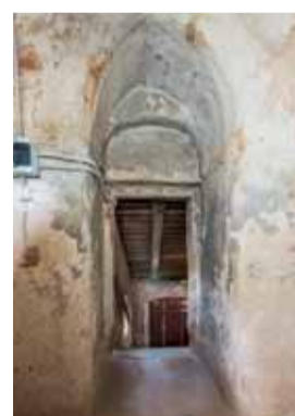
Čelní pohled od jihu na románský vstupní otvor otevřený v severní zdi prvního patra věže. Foto: Marta Pavlíková, 2019.
