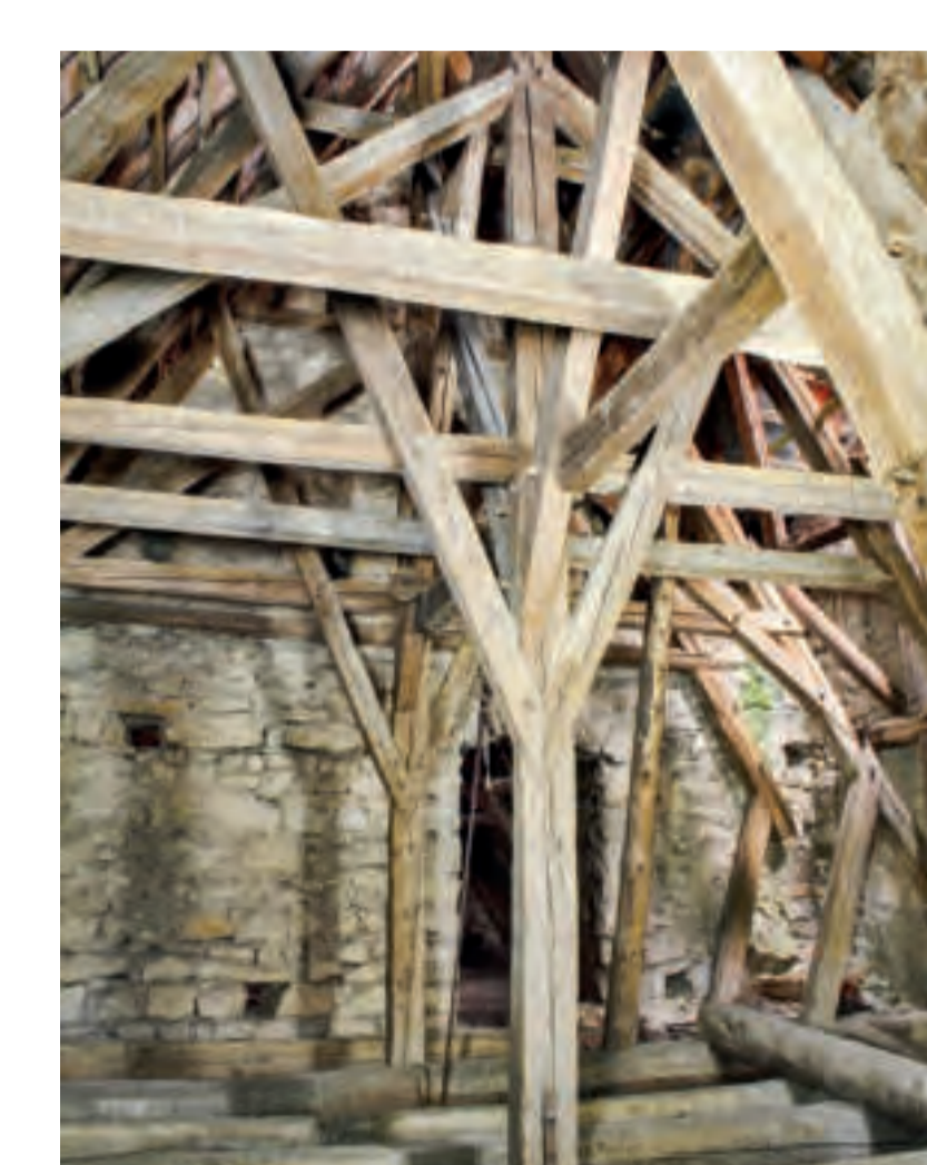
Bitoveves, kostel sv. Michaela, krov presbytáře datovaný pravděpodobně 1510–1512 (d) v pohledu od jihovýchodu. Foto: Jaroslav Skopec, 2018.
