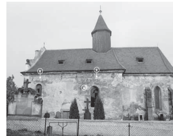
Celkový pohled od jihu na snímku z roku 1987. Zdroj: NPÚ ÚOP v Ústí n. L., Sbírká negativů, sign. 95895. A – Částečně dochované ostění středověkého okenního otvoru. B – Souvislá fada kvadrátů náležející patrně nějaký středověké římsě.
