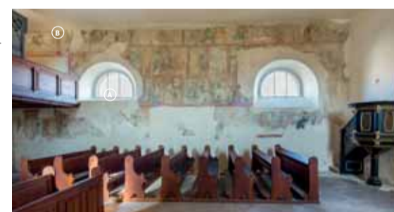
Čelní pohled od jihu na severní stěnu lodi. A – Šikmý pruh s červeným pásem vymezující prostor pro schodiště vedoucí na nedochovanou středověkou západní kruchtu. B – Široké pole fixující hloubku středověké kruchty. Foto: Marta Pavlíková, 2018.
