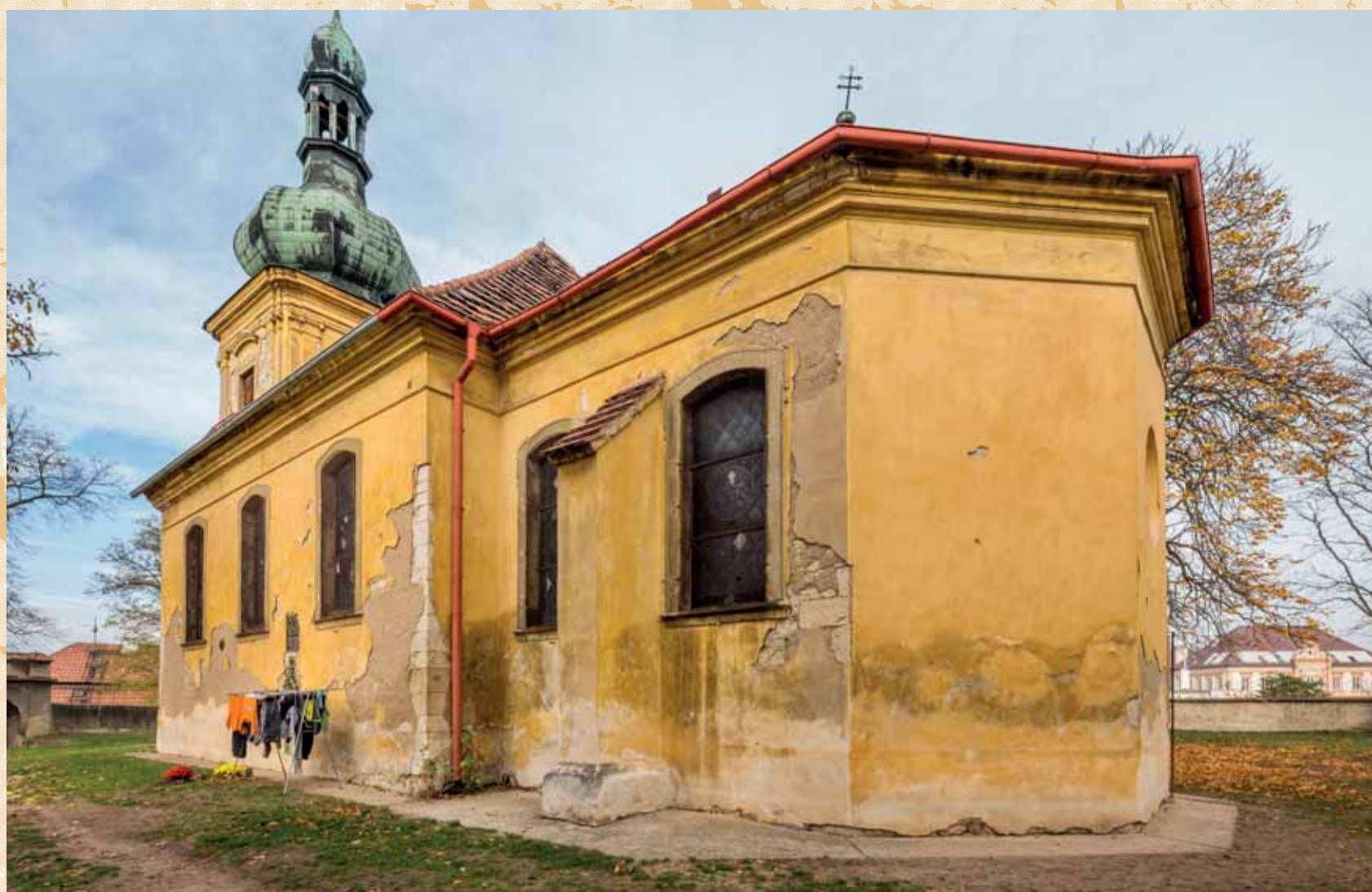
Celkový pohled od jihovýchodu. Foto: Marta Pavlíková, 2018.
