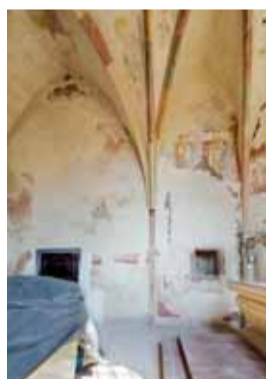
Severní strana presbytáře v pohledu od jihu. Nalevo od vstupu do sakristie je patrná dochovaná část středověkého portálu. Nad výklenkem sanktuária je fragmentární malovaná zjevně renesančně malovaná architektura sanktuária, nad níž se nachází starší pozdně gotická vrstva sřídami. Foto: Marta Pavlíková, 2022.
