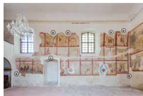
Severní strana lodi v pohledu od jihu. A – Stupňovitě narušené nástěnné malby, které může svědčit o realizaci schodiště na předbarokní kruchtu. B – Výškové ustupující pole nástěnné malby indikující možnost existence menší bočního oltáře. C – Střechovitý záklenek středověkého severního vstupu. D – Narušení nástěnné malby vzniklé po instalaci trámů stropu z doby před velkou barokní přestavbou na počátku 18. století. Foto: Marta Pavlíková, 2022.
