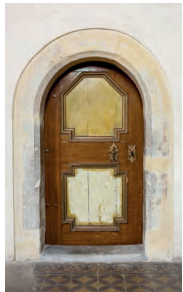
Staňkovic, čelní pohled od jihu na portál vedoucí z presbytáře do sakristie. Foto: Marta Pavlíková, 2018.
