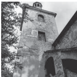
Západní průčelí věže s patrným arkádovým vlysem a zazděným ostěním obdélného okenního otvoru druhého patra věže v pohledu od západu. Foto: Petr Dostál, 1992.
