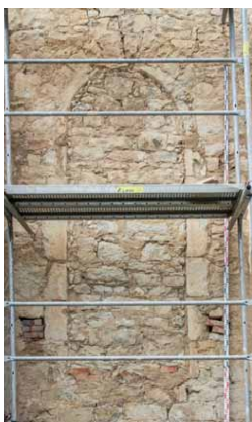
Čelní pohled od východu na zazděný východní středověký okenní otvor závěru presbytáře. Foto: Jaroslav Skopec, 2015.
