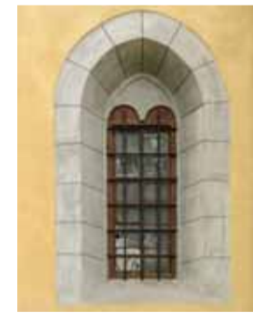
Západní okenní otvor jižní strany lodi v pohledu od jihu. Foto: Jaroslav Skopec, 2019.
