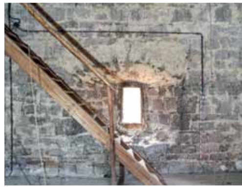
Jižní strana druhého patra věže v pohledu od severu. Interiérové líce zdiva pozdně gotické věže jsou vyzděny z velkého množství románských kvádrů. Foto: Jaroslav Skopec, 2019.
