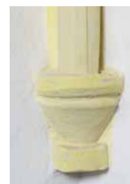
Detail severozápadní konzoly presbytáře. Foto: Marta Pavlíková, 2020.
