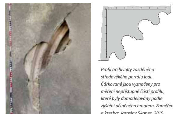
Detail profylace ostění zazděného středověkého portálu lodi. Foto: Jaroslav Skopec, 2019.
