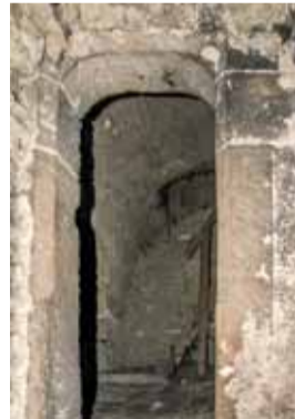
Detail portálu směřujícího z točitého schodiště do prvního patra věže. Foto: Jaroslav Skopec, 2018.
