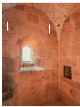
Interiér západní prostory prvního patra věže s pohledem k severozápadu. Vpravo otvor trezoru, na klenbě jsou patrné otisky po prknech šalování. Šipkami jsou označeny drobné otvory, které se nacházejí i na protilehlé straně a sloužily snad pro osazení tyčovin v době utilitárního využití kostela v 19. století. Foto: Kateřina Neumannová, 2016.
