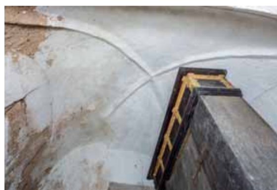
Románská klenba podvěží s dodatečnými štukovými hřebínky a odstraněnou částí jihozápadního výběhu. Foto: Marta Pavlíková, 2019.
