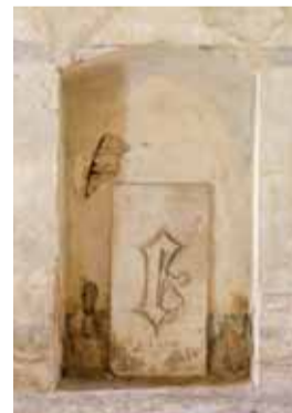
Interiérová nika západního vstupu lodi, ve které se částečně propisuje zazděný hrotitý portál a do níž je osazen náhrobek Elišky z Polenska zemřelé v roce 1474. Foto: Jan Koloc, 2009.
