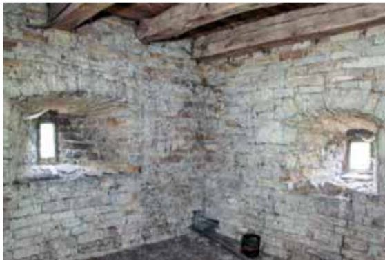
Interiér druhého patra věže s pohledem k severozápadnímu koutu. Foto: Jaroslav Skopec, 2018.
