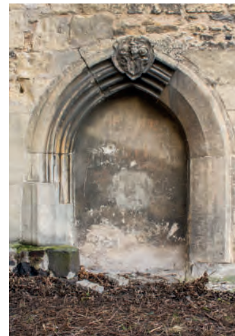
Libčevy, čelní pohled od severu na severní portál lodi. Foto: Lucie Radová, 2009.
