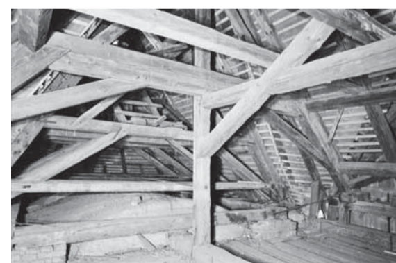
Východní plná příčná vazba krovu lodi a průhled do krovu nad presbytářem k jihovýchodu na snímku z roku 2001. Zdroj: NPÚ ÚOP v Ústí n. L., Sběrka negativů, sign. 143148.
