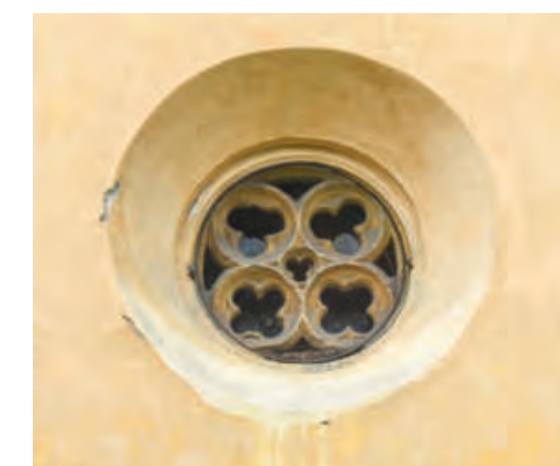
Staňkovicích, východní okenní otvor závěru presbytáře v pohledu od východu. Foto: Lucie Radová, 2009.
