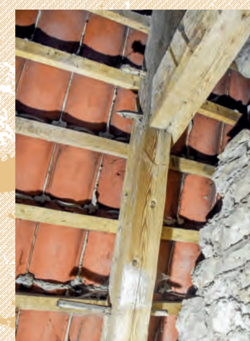
Smolnice, kostel sv. Bartoloměje, krovy datované 1373/74 (d). Gotický montážní žebřík na krokvi první příčné vazby krovy lodi od západu v pohledu od severovýchodu. Foto: Michal Panáček, 2019.
