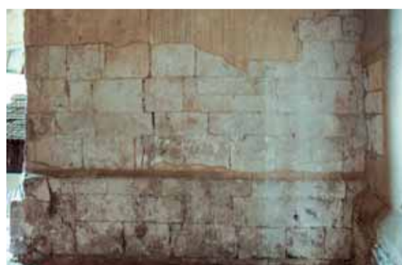
Centrální pohled od jihu z prostoru bývalé márníce na odhalený románský kvádrový líc jižního zdiva lodi po západní straně mariánské kaple. Foto: Jaroslav Skopec, 2014.
