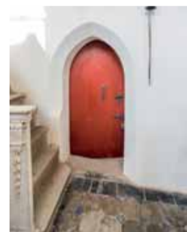
Portál vedoucí z presbytáře do sakristie v pohledu od jihovýchodu. Foto: Marta Pavlíková, 2018.
