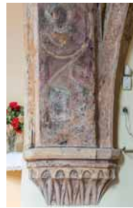
Severní výběh vítězného oblouku a severozápadního žebra klenby presbytáře a jejich konzol v pohledu od jihu. Foto: Marta Pavlíková, 2019.
