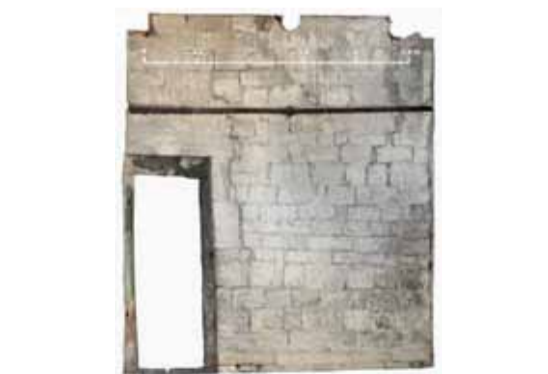
Fotoplán severní stěny prvního patra věže se vstupním portálem, jehož nadpraží bylo upravováno v rámci zajištění statických poruch. Fotoplán sestavil: Jaroslav Skopec, 2020.
