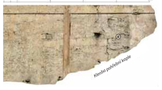
Fotoplán západní strany mariánské kaple nad stropem bývalé márníce. A - Zřetelný negativ po odstraněném pilíři, který se nacházel v ose západního průčelí kaple. Autor fotoplánu: Jaroslav Skopec, 2019.
