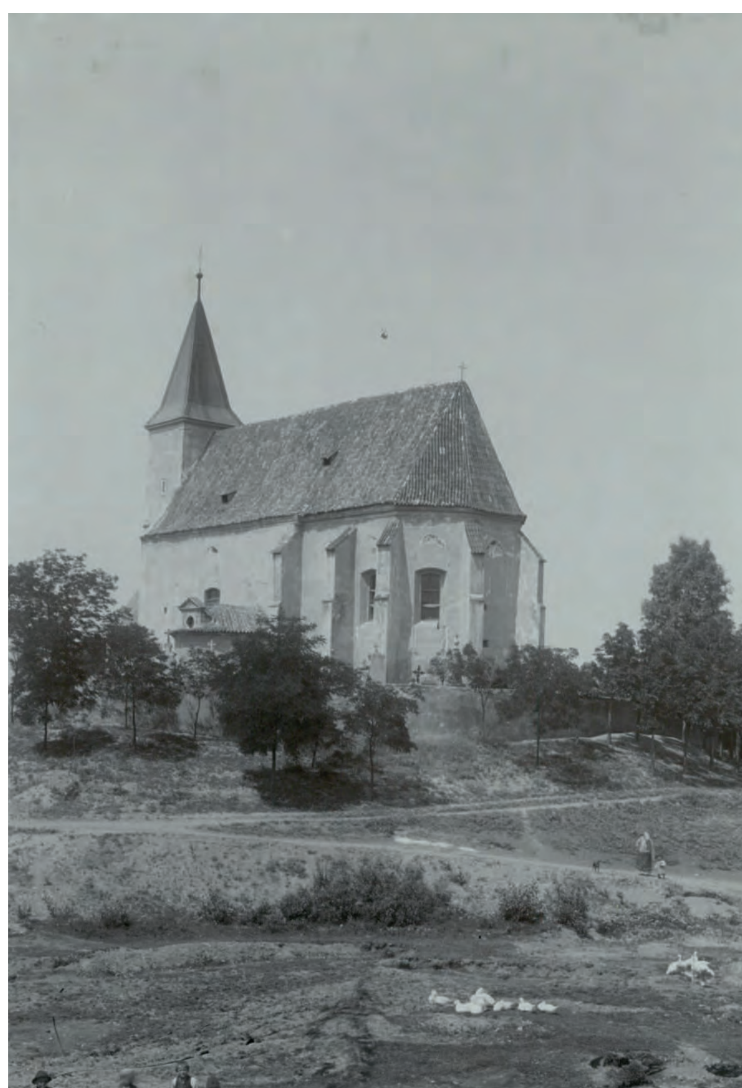
Radonice nad Ohří, zaniklý kostel Povýšení sv. Kříže v pohledu od jihovýchodu. Kostel mezi lety 1906–1907 nahradila neogotická novostavba. Zdroj: NPU GR, Sběrka negativů, sign. HF 0997-1.
