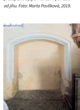
Čelní pohled od severu na jižní výklenek presbytáře. Foto: Marta Pavlíková, 2019.
