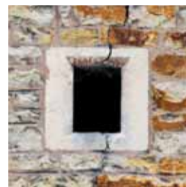
Detail východního okenního otvoru druhého patra věže. Foto: Marta Pavlíková, 2018.
