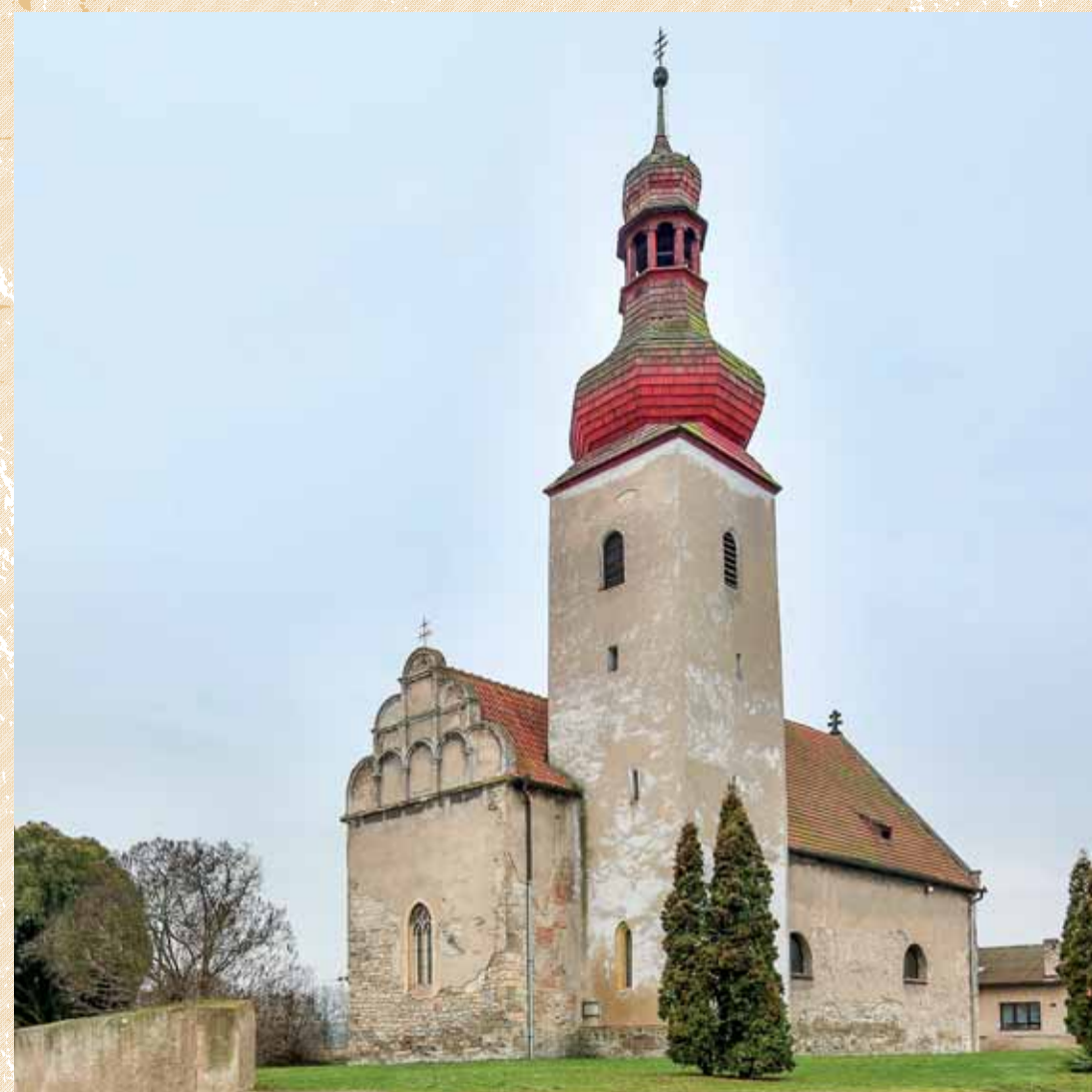
Celkový pohled od severovýchodu. Foto: Kateřina Neumannová, 2015.
