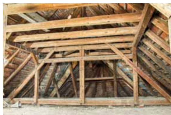
Průhled krovem nad lodí směrem k východu. Foto: Jaroslav Skopec, 2018.
