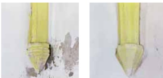
Detail severozápadní konzoly presbytáře. Foto: Marta Pavlíková, 2018.
