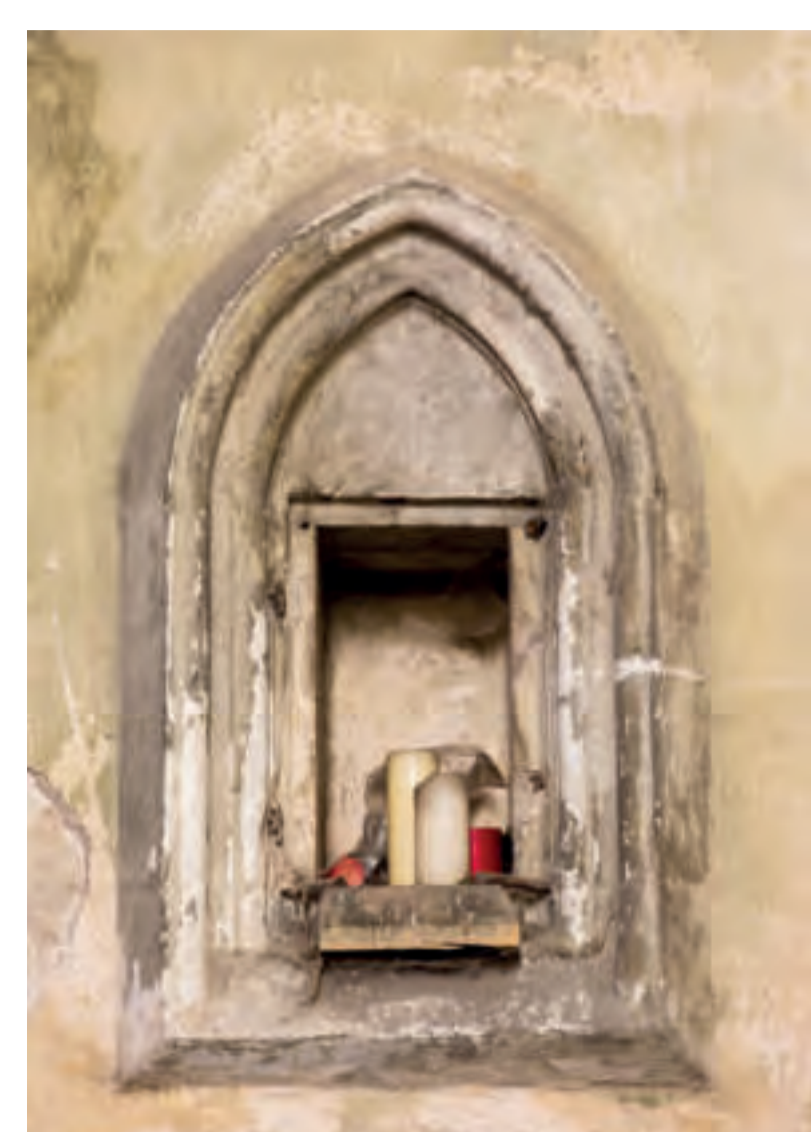
Počedčice, čelní pohled od jihu na sanktuárium. Foto: Marta Pavlíková, 2018.
