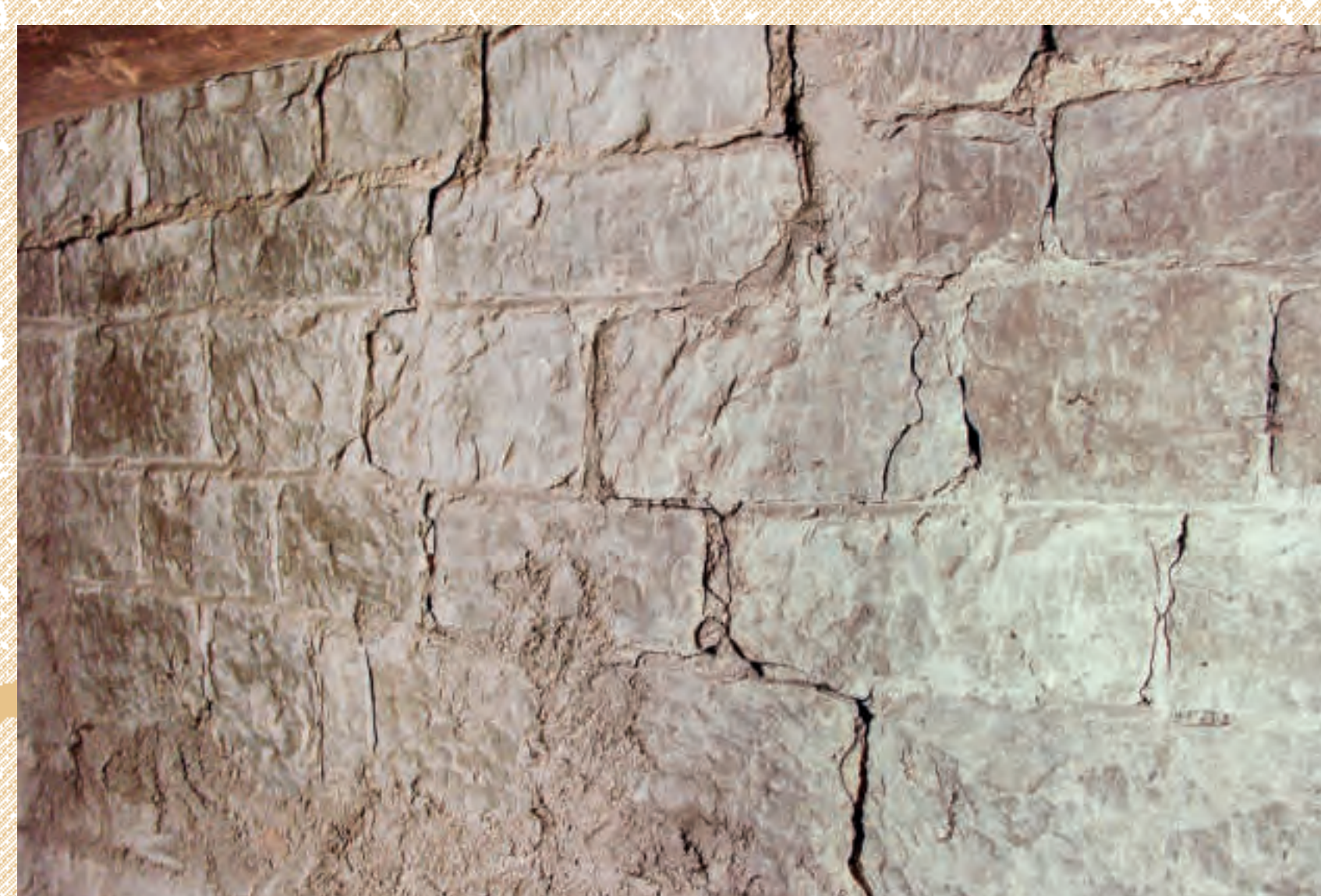
Rané, kvádrkové zdivo v interiéru prvního patra věže s dobře patrnou úpravou spár tzv. padřezáváním. Foto: Jaroslav Skopec, 2008.
