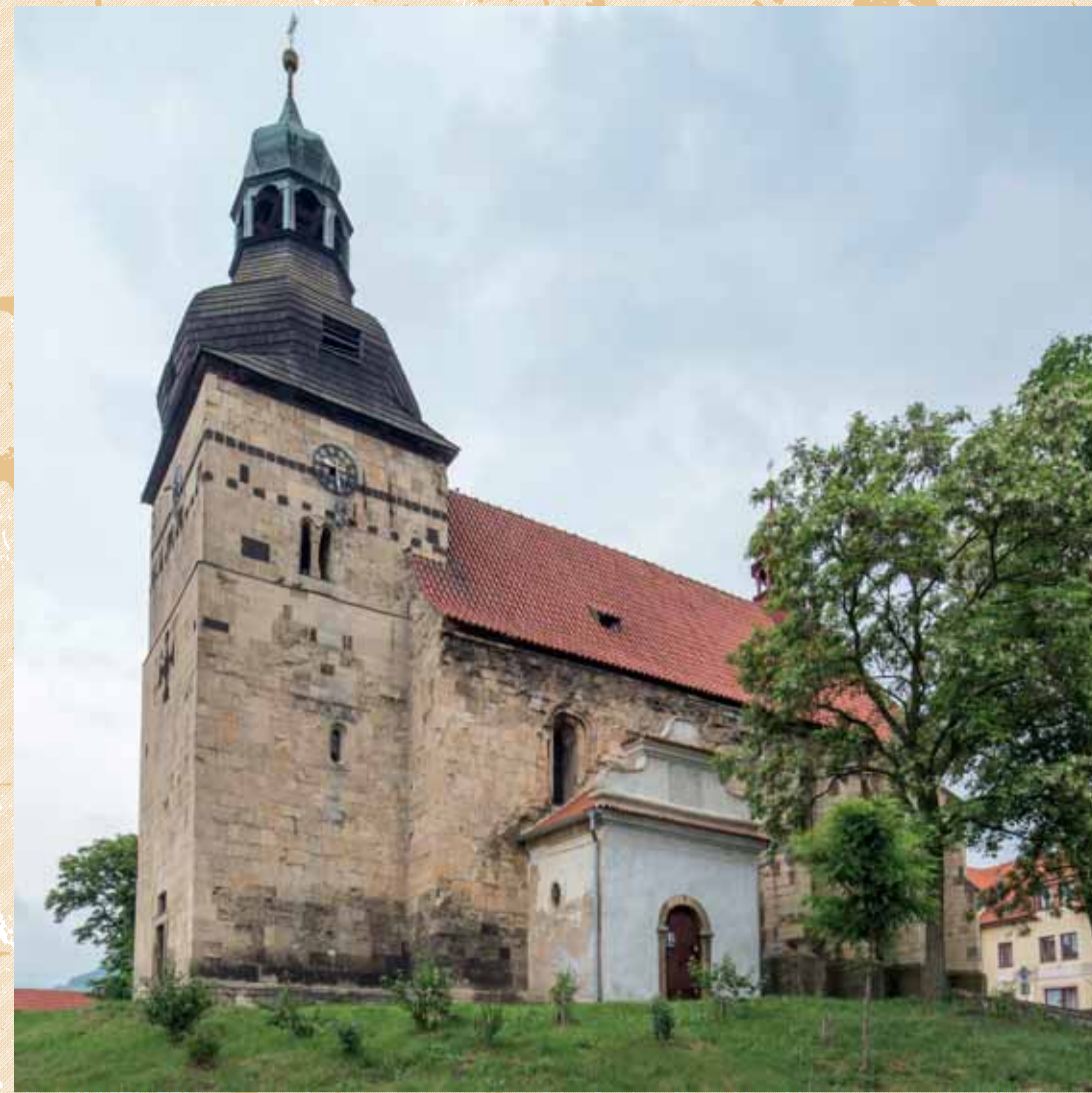
Celkový pohled od jihozápadu. Foto: Marta Pavlíková, 2014.
