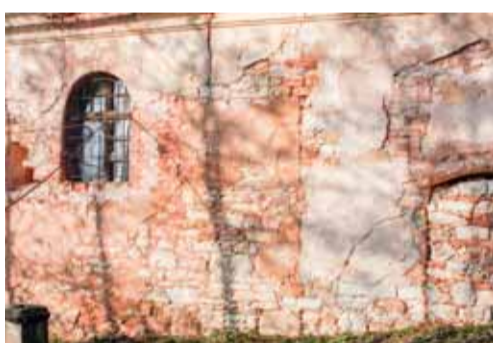
Rozhraní mezi lodí a presbytářem v pohledu od jihu. Na snímku je zřetelné armování jihovýchodního nároží středověké lodi. Napravo se nachází zazděný jižní vstupní otvor presbytáře, který snad může souviset se starší barokní sakristií, nebo prostorem budovaným pro křtitelnicí v 80. letech 18. století. Foto: Lucie Radová, 2015.
