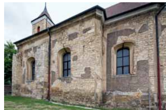
Jižní strana lodi a presbytáře v pohledu od jihovýchodu. Nad úrovní terénu jsou pozorovatelné úseky využívající ve velkém množství románských kvádrů a v náročných kvádry pocházející z vrcholné gotické přestavby románského kostela. Foto: Marta Pavlíková, 2014.
