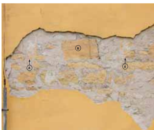
Detail odhalené části exteriérového zdiva východní strany závěru presbytáře. Foto: Marta Pavlíková, 2022.
