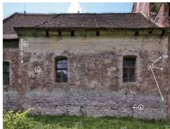
Čelní pohled na severní průčelí lodi. A – vertikální spára určující původní délku středověké lodi s dochovanými kvádry spodní partie nárožního armování. B – středověké kvádry druhotně použité při prodloužení lodi v roce 1788. C – zazděný okenní otvor pocházející z blíže neurčitelné doby před rozšířením lodi roku 1788. D – přezděné nároží související patrně s rozšířením lodi roku 1788. Foto: Kateřina Neumannová, 2016.
