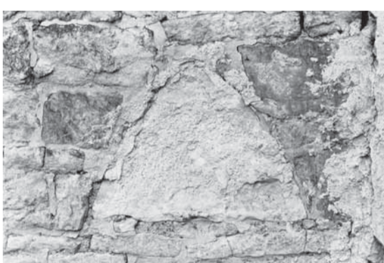
Detail většího trojúhelného kvádrů s jednou zaoblenou stranou, který je zazděný do lince severozápadního opěráku lodi. Kvádr snad lze interpretovat jako část románského tympanonu. Snímek z roku 2001. Zdroj: NPÚ ÚOP v Ústí n. L., Sběrka negativů, sign. 143131.
