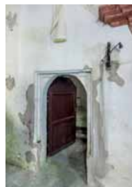
Portál směřující z presbytáře do sakristie v pohledu od jihovýchodu. Nad portálem je patrný kamenný reliéf, který patrně představuje klenot, nebo část figury erbovního znamení v podobě hříče, jehož držitelé byli v uvažované době vzniku kostela páni z Touchovic. Foto: Marta Pavlíková, 2018.
