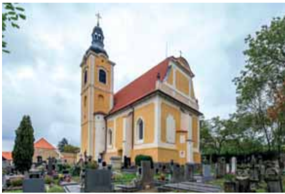
Celkový pohled od severovýchodu. Foto: Kateřina Neumannová, 2015.
