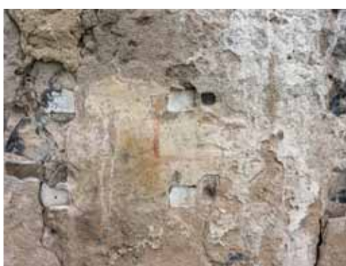
Detail starší povrchové úpravy při jihovýchodním náraží východního závěru kostela. Foto: Marta Pavlíková, 2019.
