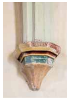
Detail první jižní konzoly od východu severní boční lodi. Foto: Marta Pavlíková, 2019.
