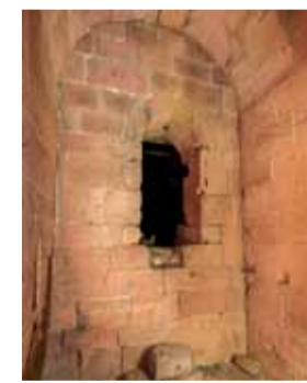
Interiér druhého patra věže s pohledem k východu. Na snímku je patrný vstup do dnešního podkroví se zazděnou tyčevinou ve vrcholu záklenku. Pod otvorem je deponován kvádr prahu s důlčkem. Nad otvorem se nachází klenutý pas vynásající východní zeď věže nad rovinou západního štítu lodi. Foto: Kateřina Neumannová, 2016.
