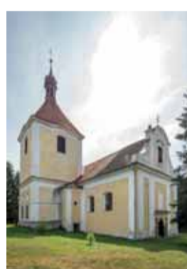
Celkový pohled od severozápadu. Foto: Marta Pavlíková, 2019.
