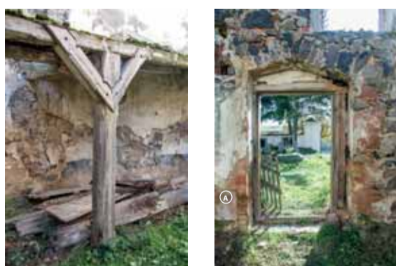
Detail dnes zaniklého sloupku s pásky, který vynášel čelo západního křídla kruchty dendrochronologicky datované do přelomu let 1608/1609. Foto: Lucie Radová, 2007. Čelní pohled od severu na niku jižního vstupu lodi. Foto: Lucie Radová, 2007. A – Kvádr armování východní hrany špalety niky, která byla jinak přezděna.
