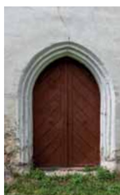
Čelní pohled od jihu na jižní portál lodi. Celkový pohled od severu. Foto: Marta Pavlíková, 2019.
