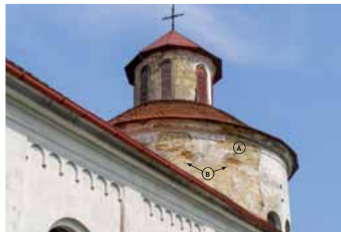
Vrchní partie lodi a lucerny rotundy v pohledu od jihozápadu s částečně odhalenými kvádrovými lícem. A – Nadezdívka pocházející z doby přestavby kostela realizované v první polovině 50. let 19. století. B – Pás nižších kvádrů se zřetelnými stopami po odsekaném profilu korunní římsy. Foto: Jan Koloc, 2009.
