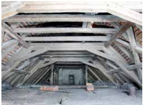
Průhled krovem nad lodí směrem k východu. V popředí část krovu s barokní ležatou stolicí z 30. let 18. století, v pozadí část krovu s podélnými stojatými stolicemi z počátku 20. století. Foto: Jaroslav Skopec, 2020.
