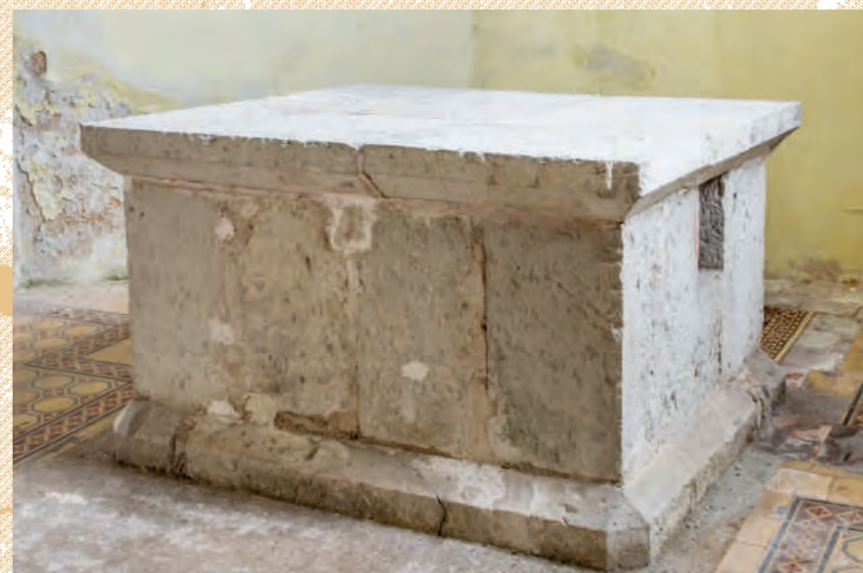
Hradštit, menza hlavního oltáře od severozápadu. Foto: Marta Pavlíková, 2019.
