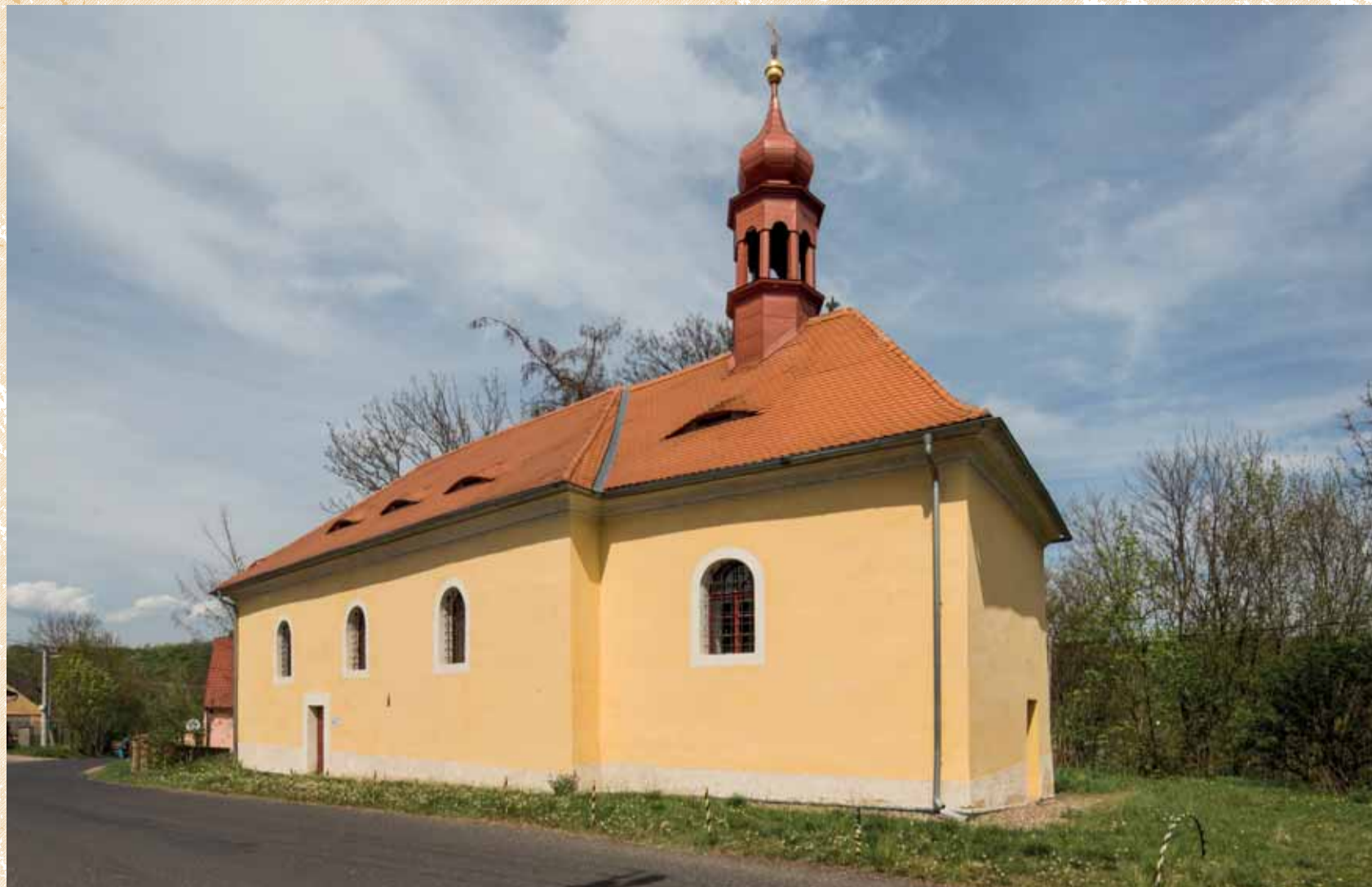
Celkový pohled od jihovýchodu. Foto: Marta Pavlíková, 2019.
