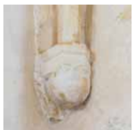
Detail jihozápadní konzoly presbytáře. Foto: Marta Pavlíková, 2020.
