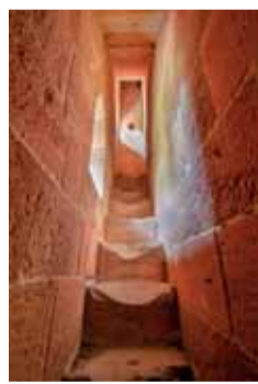
Spodní rameno schodiště v tloušče zdi s pohledem k západu. Ve stupnici schodu zcela dole je zřetelný maltou vyplněný důlek, který se nachází na všech stupních a také parapetech okenních otvorů schodiště a prázdných portálů. Foto: Kateřina Neumannová, 2016.
