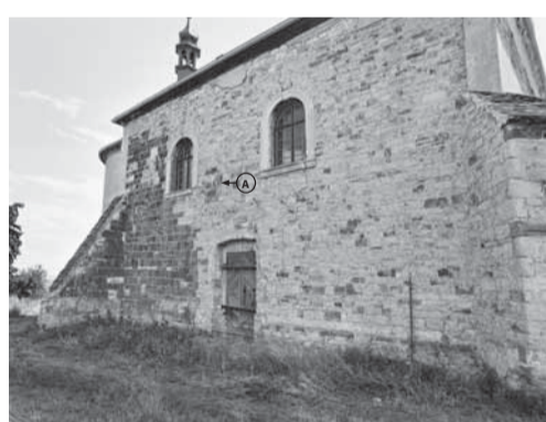
Severní průčelí lodi v pohledu od severozápadu na snímku z roku 2006. Na fotografii je patrný zřetelný předěl mezi obvodovým zděvem skládaným z opakových kvádrů a pískovcových kvádrů, rozdílná podoba a výše jejich soklů. A – V zazděnce částečně dochované pískovcové ostění drobnějšího obdélného okenního otvoru. Zdroj: NPÚ ÚOP v Ústí n. L., Sběrka negativů, sign. 179530.
