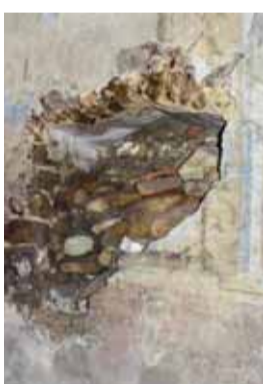
Detail části odhalené niky se střešovitým záklenkem severního středověkého vstupu lodí v pohledu od jihovýchodu. Foto: Lucie Radová, 2007.
