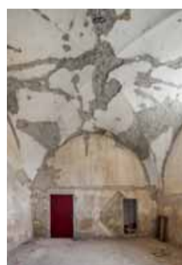
Interiér presbytáře s pohledem k východu. Foto: Marta Pavlíková, 2019.
