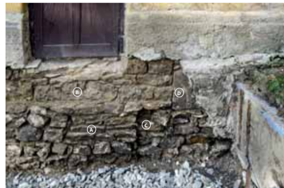
Severní konec východního zdiva sakristie v pohledu od jihovýchodu s patřným odhaleným základovým zdivem. A - Předzáklad východního zdiva sakristie. B - Východní zdivo sakristie. C - Předzáklad jižního opěrného pilíře presbytáře. D - Kvádr armování opěráku.
