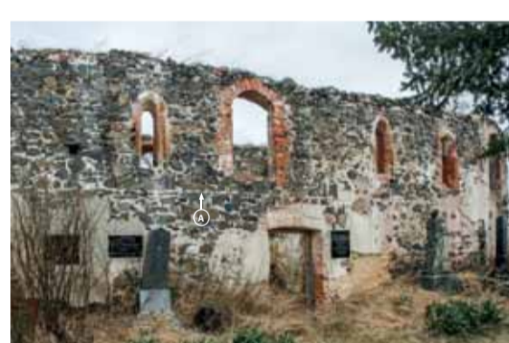
Jižní průčelí lodi v pohledu od jihozápadu. Foto: Jaroslav Skopec, 2012. A – Stavební spára.
