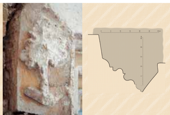
Profil západní stajky sedile presbytáře. Zaměření a kresba: Jaroslav Skopec, 2020.
