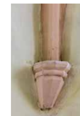
Detail východjihovýchodní konzoly presbytáře. Foto: Marta Pavlíková, 2019.
