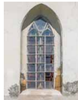
Čelní pohled od jihovýchodu na jihovýchodní okenní otvor zvěru presbytáře. Foto: Marta Pavlíková, 2019.
