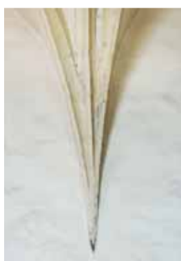
Detail severního meziklenbového výběhu presbytáře. Foto: Marta Pavlíková, 2018.
