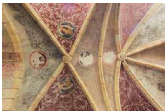
Klenba presbytáře v podhledu s odhalenými nástěnnými malbami pocházejícími patrně ze 40. let 15. století. Foto: Marta Pavlíková, 2020.
