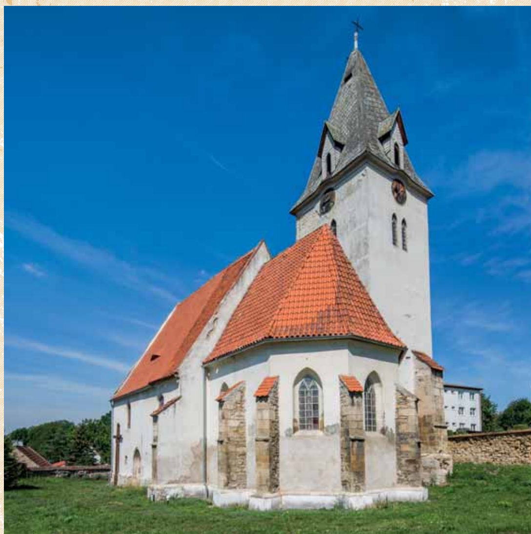
Celkový pohled od jihovýchodu. Foto: Marta Pavlíková, 2019.
