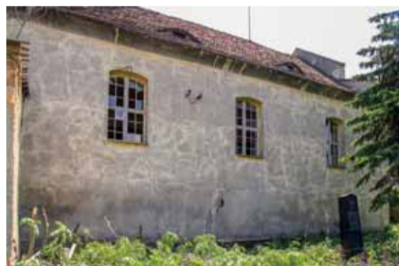
Severní průčelí lodi v pohledu od severovýchodu s patrným zazděným středověkým portálem v jeho středu. Foto: Jaroslav Skopec, 2019.
