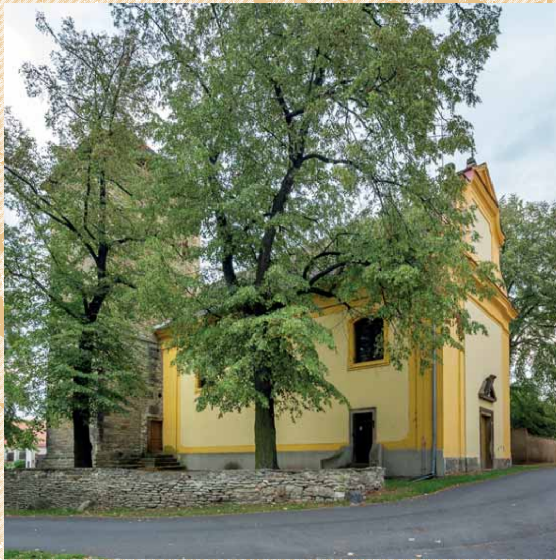
Celkový pohled od severozápadu. Foto: Marta Pavlíková, 2018.
