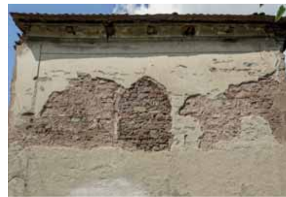
Pohled na východní průčelí presbytáře se zazděným středověkým okenním otvorem. Foto: Kateřina Neumannová, 2016.
