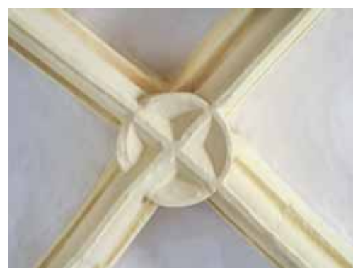
Detail svorníku klenby presbytáře. Foto: Jaroslav Skopec, 2015.
