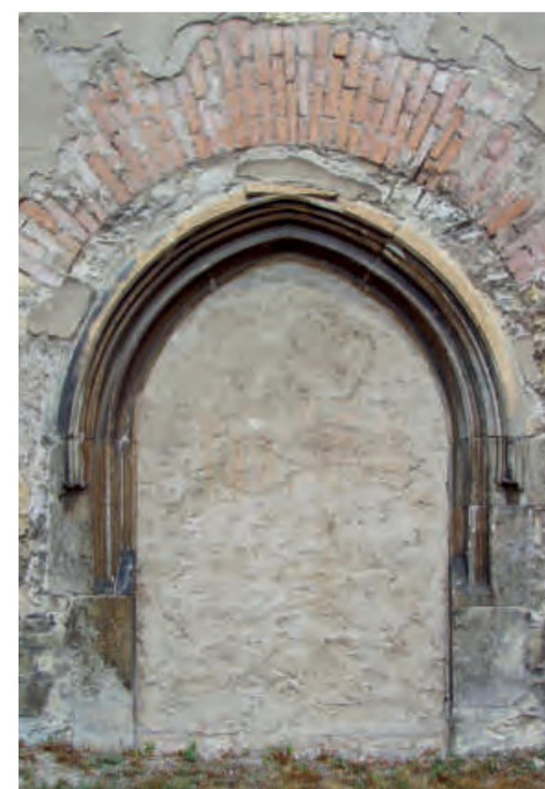
Dobroměřice, čelní pohled od jihu na jižní portál předsíně. Foto: Jaroslav Skopec, 2017.
