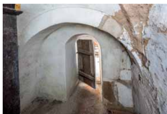
Východní strana podvěží v pohledu od jihozápadu. Foto: Marta Pavlíková, 2019.
