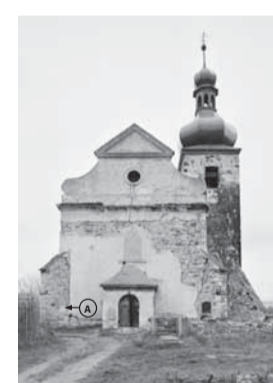
Západní průčelí kostela s částečně odhalenou strukturou zdiva lodi a jejich opěrných pilířů na snímku z roku 2001. A – Umístění trojúhelného kvádrů se zaoblenou stranou. Zdroj: NPÚ ÚOP v Ústí n. L., Sběrka negativů, sign. 143149.
