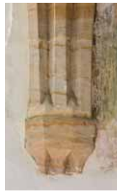
Detail jižní konzoly gotického presbytáře. Foto: Marta Pavlíková, 2019.
