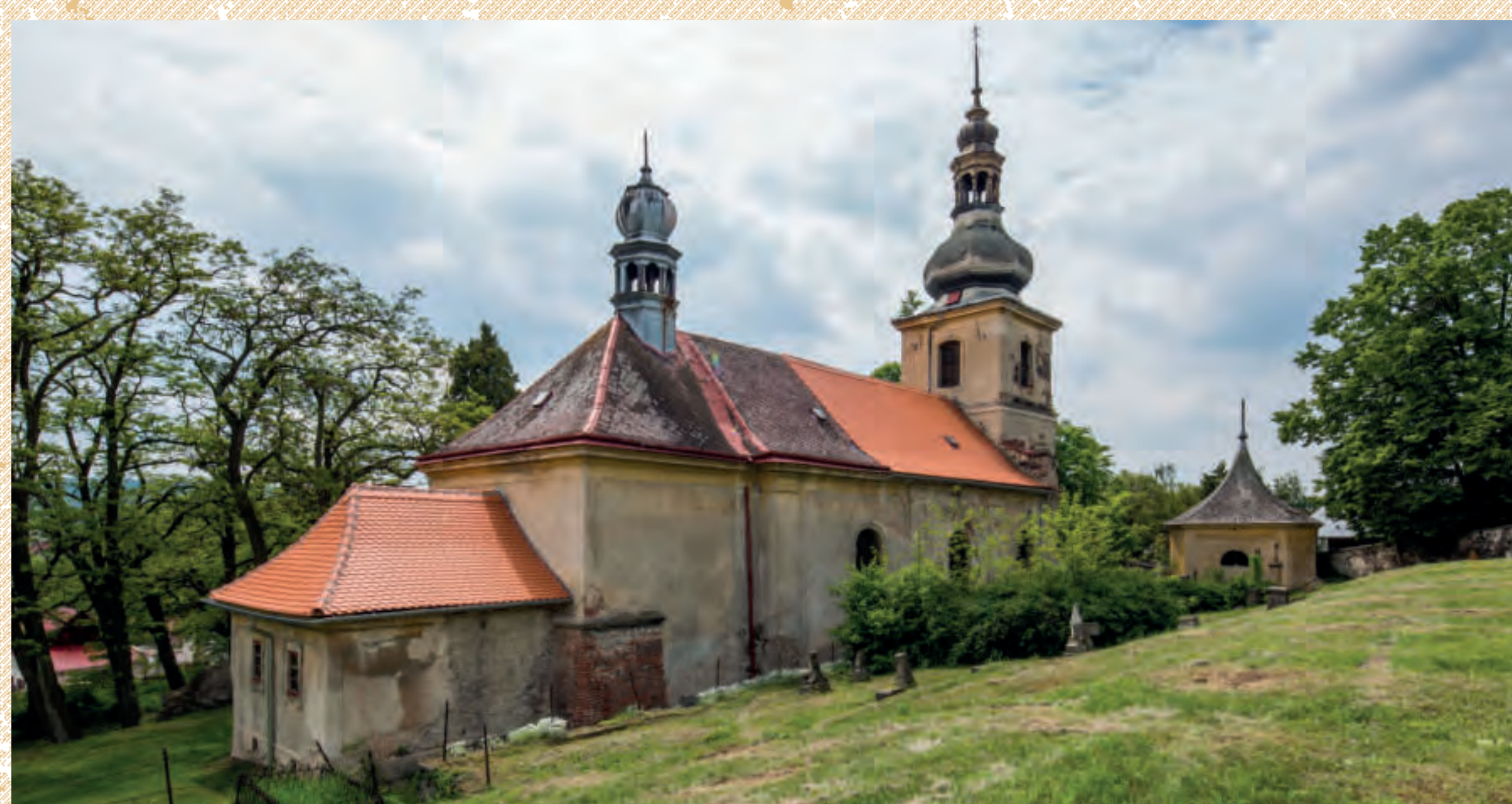
Farní kostel Narození Panny Marie nad Buškovicemi byl původně filiální a nesl zasvěcení sv. Jana. Po třicetileté válce, kdy zpustl kostel sv. Bartoloměje v centru obce, získal jeho farní statut i nové patronátium. Foto: Marta Pavlíková, 2019.
