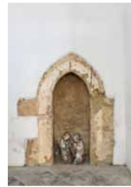
Čelní pohled od východu na hrotitý portál osazený v západní stěně sakristie, který původně vedl na točité schodiště. Foto: Kateřina Neumannová, 2015.
