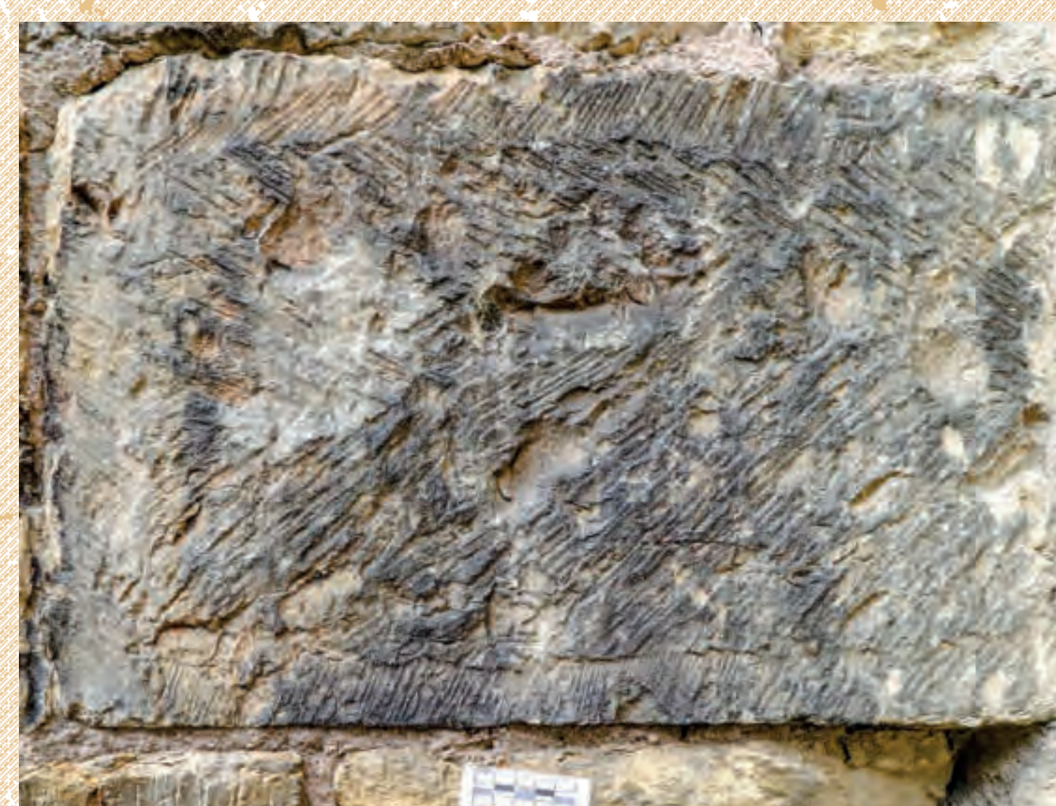
Libčevce, kvádr na jímání exteriérovém lici lodi. Ukázka typického líce pozdně románského kvádrů nesoucího charakteristické stopy po finálním přerovnání dlátem, kterým byla nejprve zhotovena i obvodová stezka. Foto: Michal Cihla 2019.
