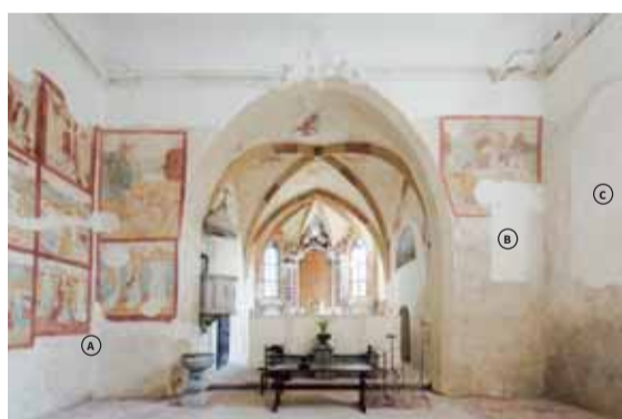
Východní strana lodi s průhledem do presbytáře v pohledu od západu. A – Výškové ustupující pole nástěnné malby indikující možnost existence menší bočního oltáře. B – Zaděný barokní vstup na oratoř. C – Zaděný jediný zjištěný středověký okenní otvor lodi. Foto: Marta Pavlíková, 2022.
