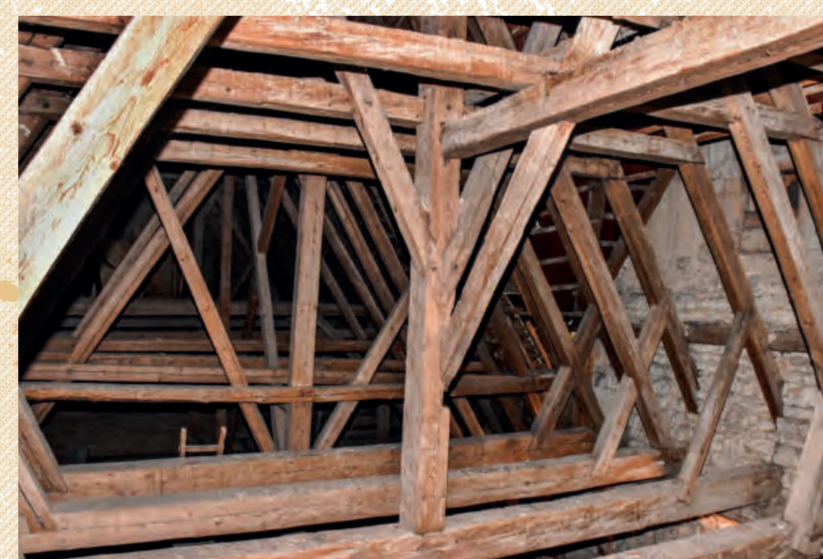
Smolnice, kostel sv. Bartoloměje, krovy datované 1373/74 (d). Celkový pohled od východu do krovy presbytáře i lodi. Foto: Michal Panáček, 2019.
