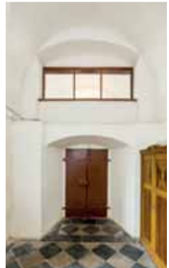
Jižní strana sakristie v pohledu od severu se zřetelným horizontálním předělem po odstranění podlahy zvažované pavlače. Foto: Marta Pavlíková, 2018.
