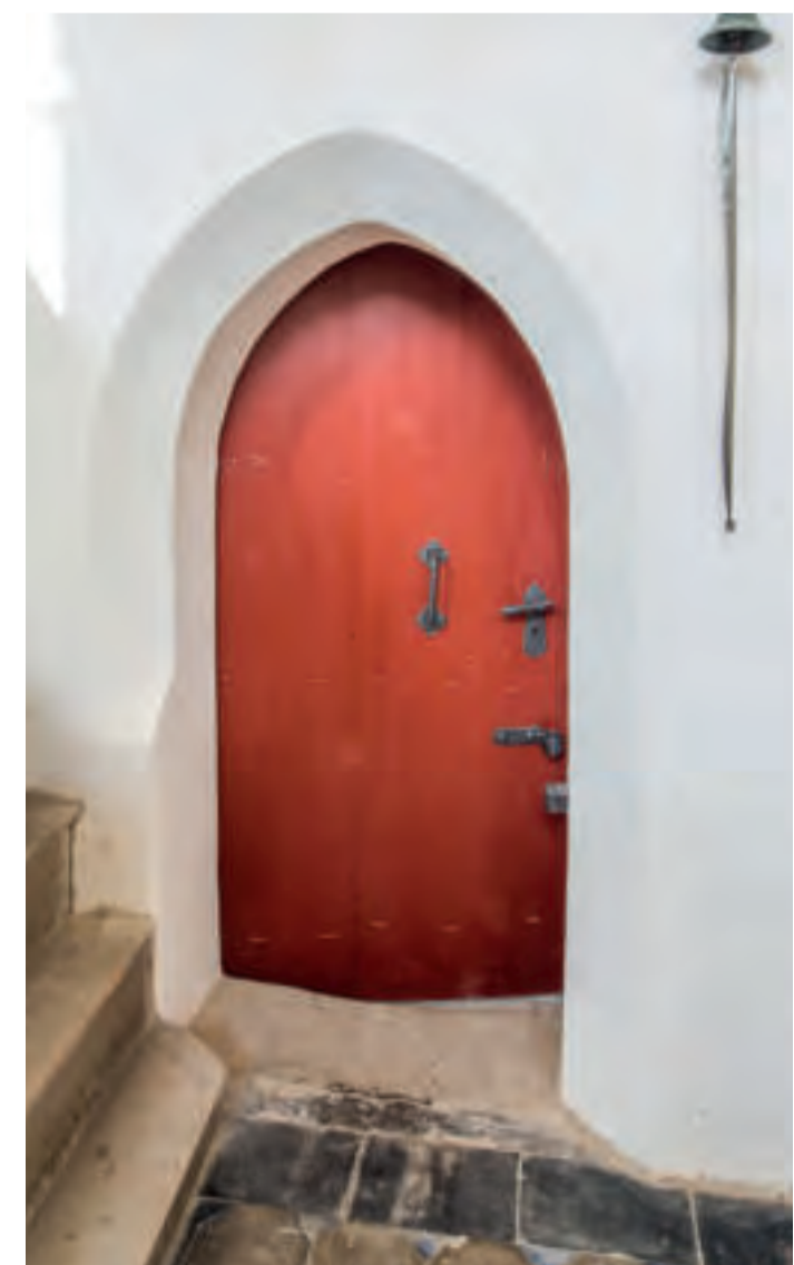
Radčevy, portál vedoucí z presbytáře do sakristie v pohledu od jihovýchodu. Foto: Marta Pavlíková, 2018.
