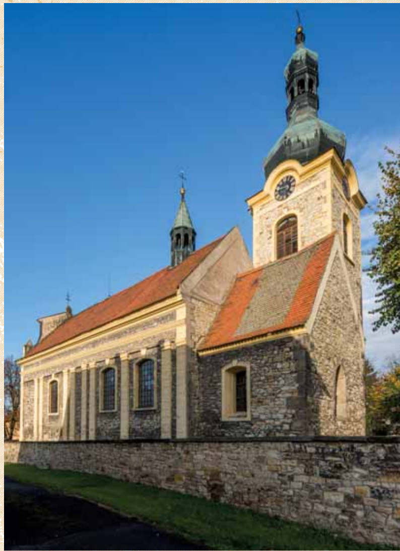
Celkový pohled od jihovýchodu. Foto: Marta Pavlíková, 2019.
