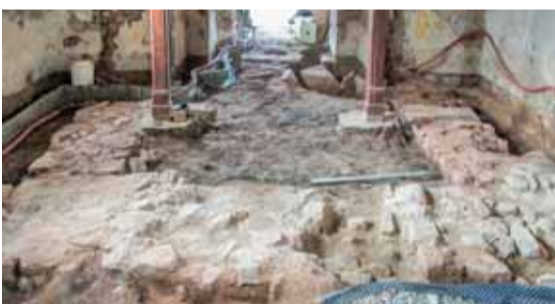
Západní třetina lodi s odhalenými základy starší věže připojené na spáru k původní západní zdi lodi v pohledu od východu. Foto: Vojtěch Peksa, 2014.
