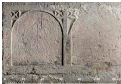
Fotoplán druhého zazděného kvádrů s lichými arkádami v severní špaletě západního okenního otvoru třetího patra věže. Tvorba fotoplánu: Jaroslav Skopec, 2019.
