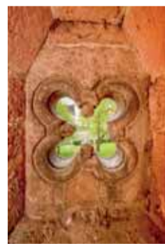
Čelní pohled od severu na spodní okenní otvor schodiště v tloušče zdi. Foto: Kateřina Neumannová, 2016.
