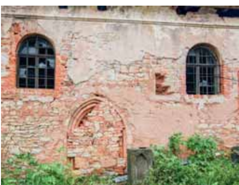
Jižní průčelí lodi v pohledu od jihozápadu. Foto: Veronika Bartošová, 2007.
