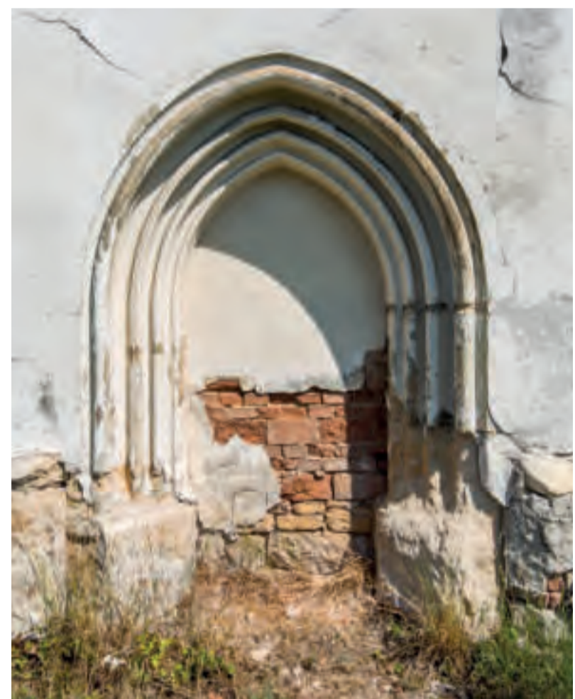
Bitozeves, čelní pohled od jihu na jižní portál lodi. Foto: Marta Pavlíková, 2019.
