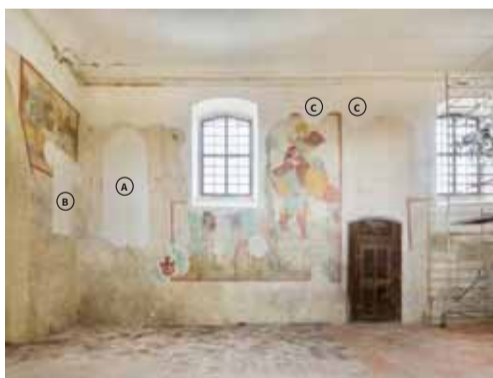
Jižní strana lodi v pohledu od severu. A – Zaděný jediný zjištěný středověký okenní otvor lodi. B – Zaděný barokní vstup na oratoř. C – Narušení nástěnné malby vzniklé po instalaci trámů stropu z doby před velkou barokní přestavbou na počátku 18. století. Foto: Marta Pavlíková, 2022.
