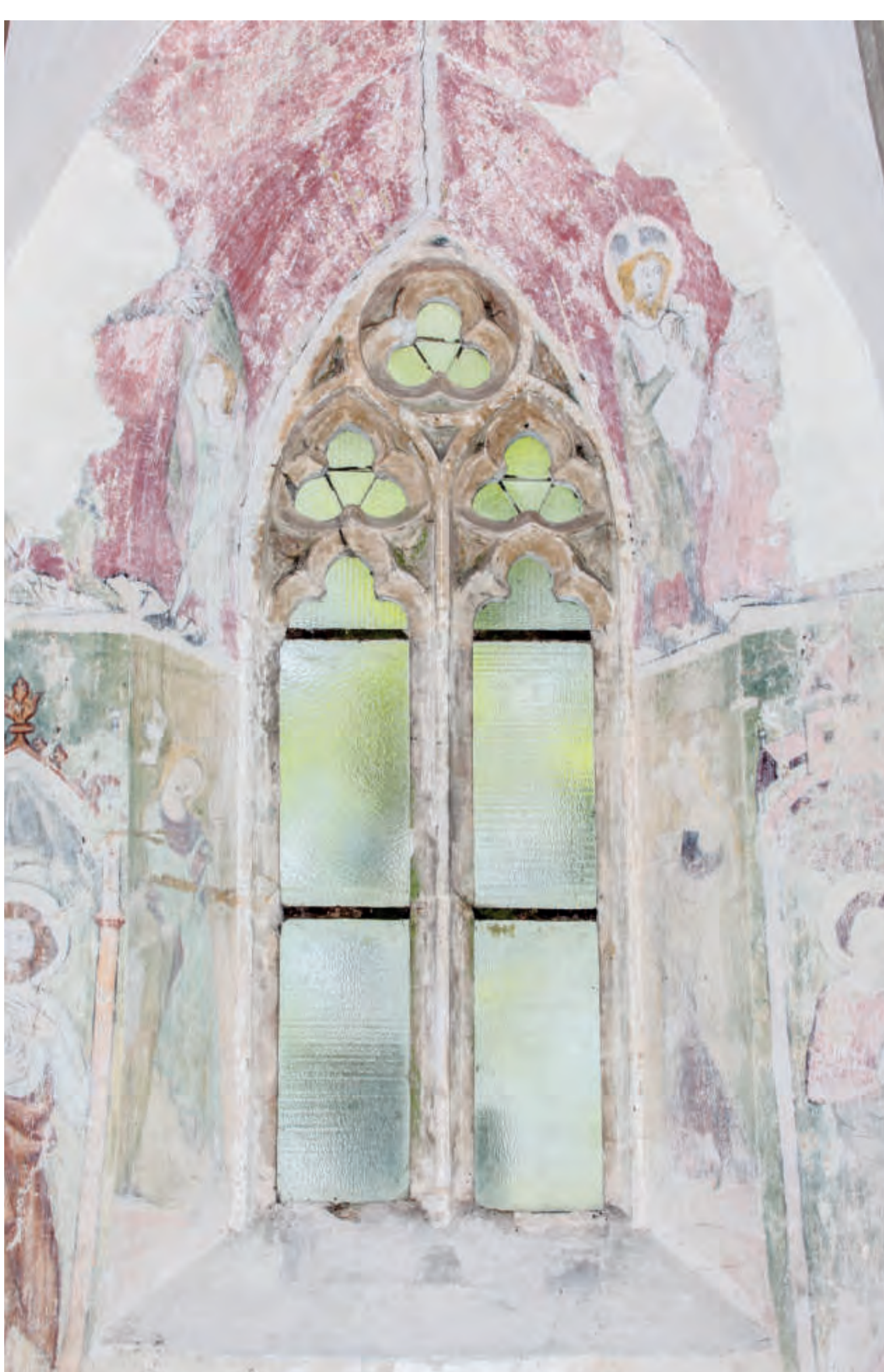
Černochove, čelní pohled od západu na východní okenní otvor závěru presbytáře. Foto: Marta Pavlíková, 2019.
