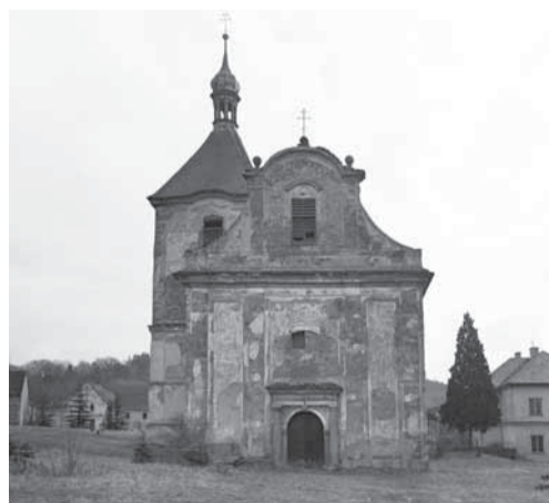
Západní průčelí kostela na fotografii z roku 1988. Ze snímku je patrné, že zdivo postrádá nárožní armování a líženy jsou zděné společně s obvodovým zdívkem, ve kterém jsou místy pozorovatelné kvádry pocházející snad ze středověkých konstrukcí, což dokládá jeho vznik až při barokní obnově kostela. Zdroj: NPÚ ÚOP v Ústí n. L., Sběrka negativů, sign. 96472.
