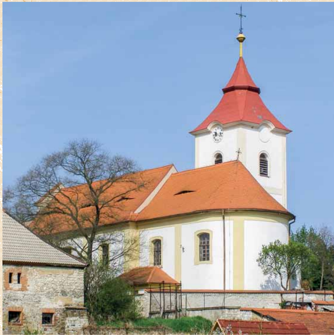
Celkový pohled od jihovýchodu. Foto: Marta Pavlíková, 2022.
