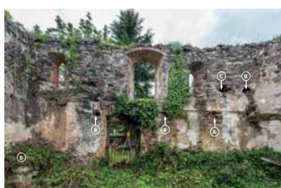
Jižní strana lodi v pohledu od severu. Foto: Marta Pavlíková, 2019. A – Kapsy pro zavazání trámů zaniklého jižního ramene kruchty. B – Kapsa pro zavazání trámů zábradlí kruchty a pod ní jeho otisk. C – Kapsa procházející celou tloušťkou zdi vážící se snad k prvotní kruchtě. D – Částečně dochovaná menza bočního oltáře.
