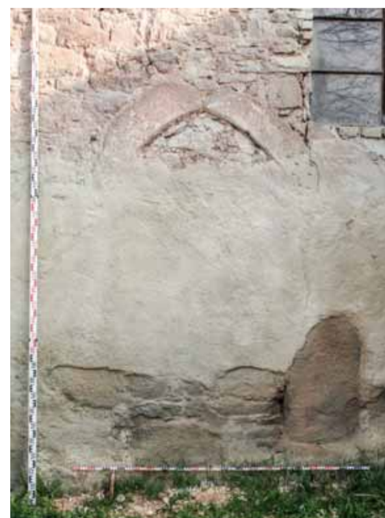
Detail zazděného středověkého portálu na jižní straně lodi. Foto: Jaroslav Skopec, 2014.
