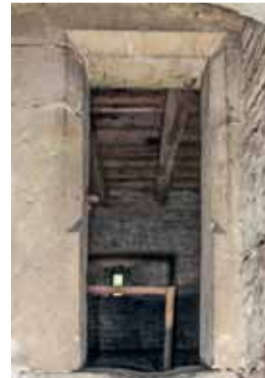
Detail portálu směřujícího ze schodiště v tloušťce zdi do druhého patra věže. Foto: Jaroslav Skopec, 2018.
