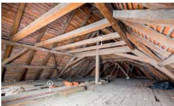
Průhled krovem nad lodí směrem k severovýchodu. A – Druhotně použitý průvlak stropu lodi datovaný po roce 1445. B – Druhotně použitá část krove datovaná do přelomu let 1439/40. Foto: Marta Pavlíková, 2018.
