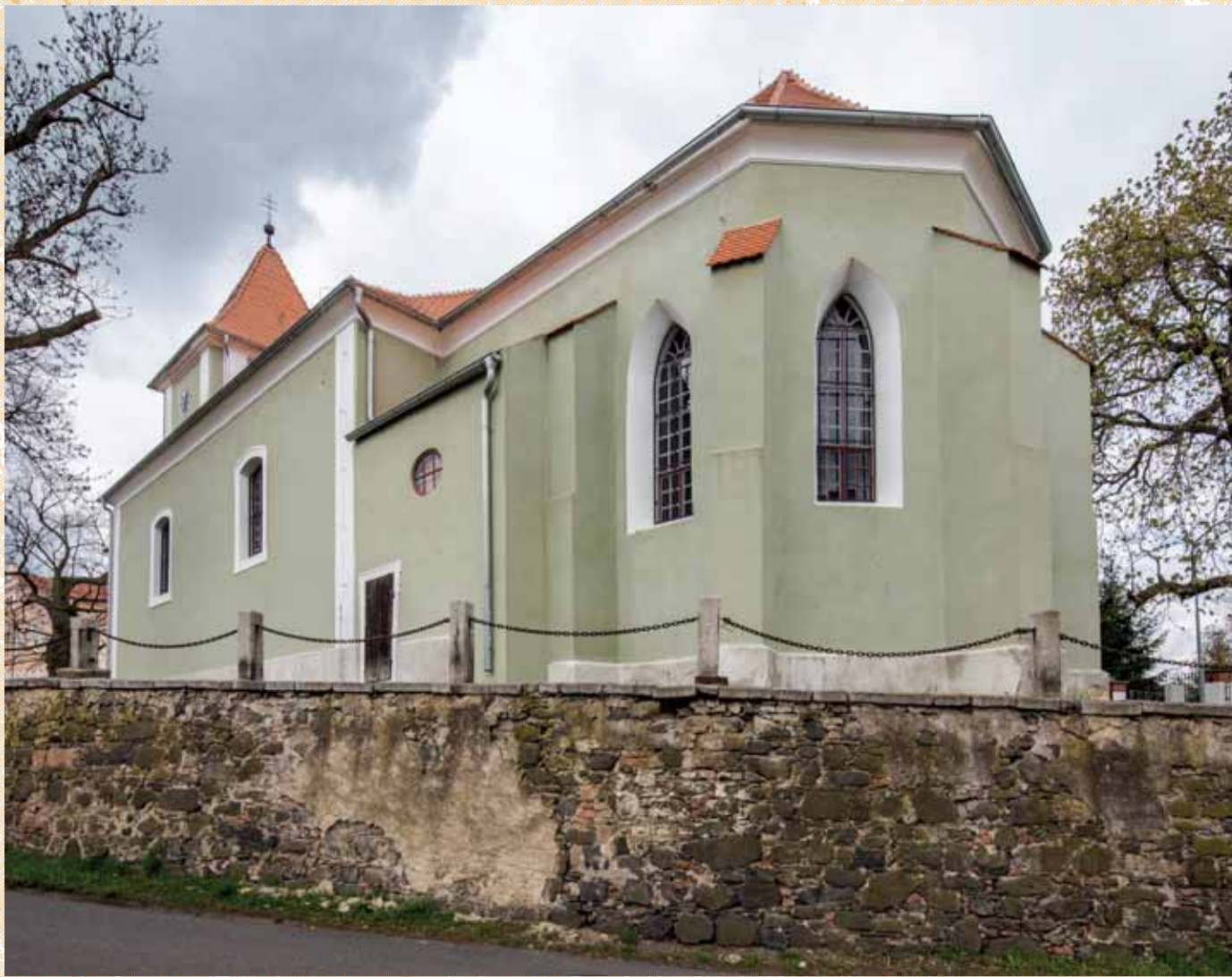
Celkový pohled od jihovýchodu. Foto: Marta Pavlíková, 2021.
