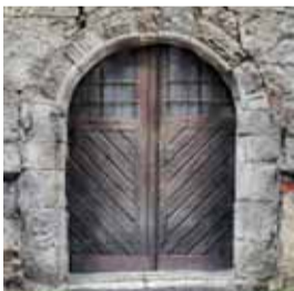
Fotoplán západního portálu věže seskládaného z druhotné použitých románských prvků. Autor fotoplánu: Michal Čihla, 2018.
