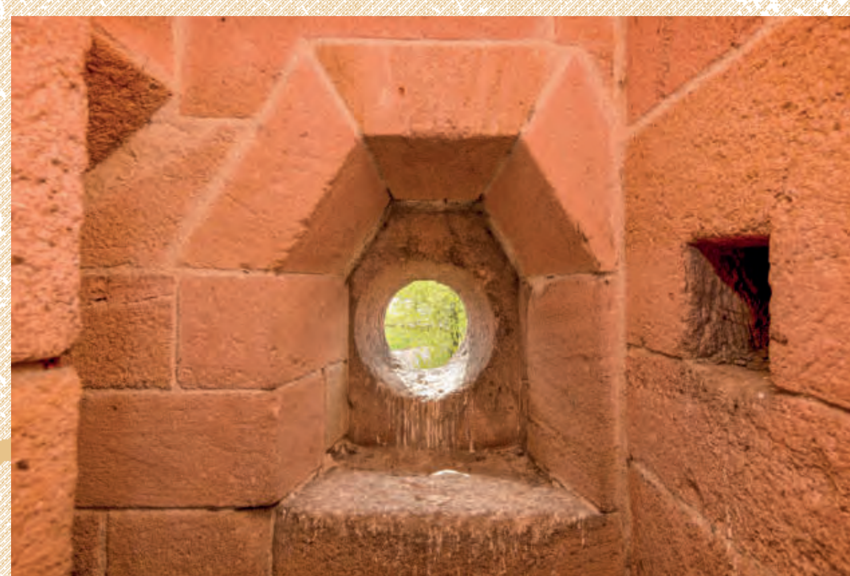
Vroutek, čelní pohled od severu na horní okenní otvor schodiště v tlušče zdi. Foto: Kateřina Neumannová, 2016.
