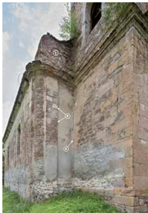
Pohled do severního koutu svíraného západní stěnou lodi a severní stěnou věže. A – dílek pilastru západního průčelí věže, který byl zakryt dodatečně přiloženou věží. B – středověké kvádry druhotně použité při prodloužení lodi v roce 1788. C – zachovaný fragment štítu z doby výstavby věže oddělený zřetelnou spárou od mladší úpravy patrné ze 30. let 19. století. Foto: Kateřina Neumannová, 2016.
