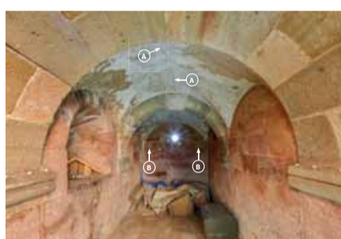
Interiér podvěží s pohledem k západu. A – Místa s odhalenými otisky prken šalování klenby. B – Zazděné kapsy zřejmě po dřevěných trámčích, které sem byly dodatečně vkládány v době utilitárního využití kostela v 19. století. Foto: Kateřina Neumannová, 2016.
