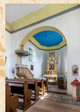
Východní strana lodi s průhledem do presbytáře směrem k severovýchodu. Foto: Marta Pavlíková, 2019.
