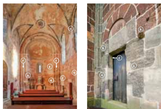
Interiér lodi s průhledem do apsidy ve směru od západu. A – Vyklenek sanktuária. B – Odkládací vyklenek. C – Zazděný mladší vstup do později odstraněné sakristie. D – Zazděný mladší jižní vstup lodi. E – Zazděný mladší okenní otvor. F – Zazděné kapsy, do kterých mohli být osazené trůny s kalvárií. G – Dobře patrná část oblouku vnitřní profilace románského okenního otvoru. Foto: Kateřina Neumannová, 2016.
