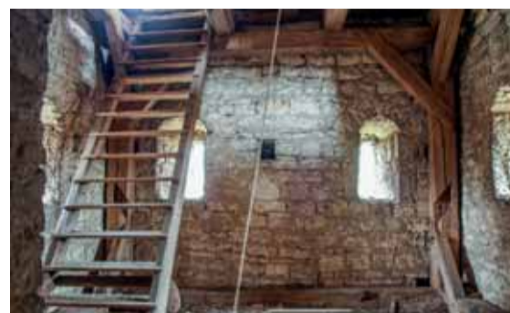
Interiér prvního patra věže s pohledem k severu. Foto: Jaroslav Skopec, 2015.
