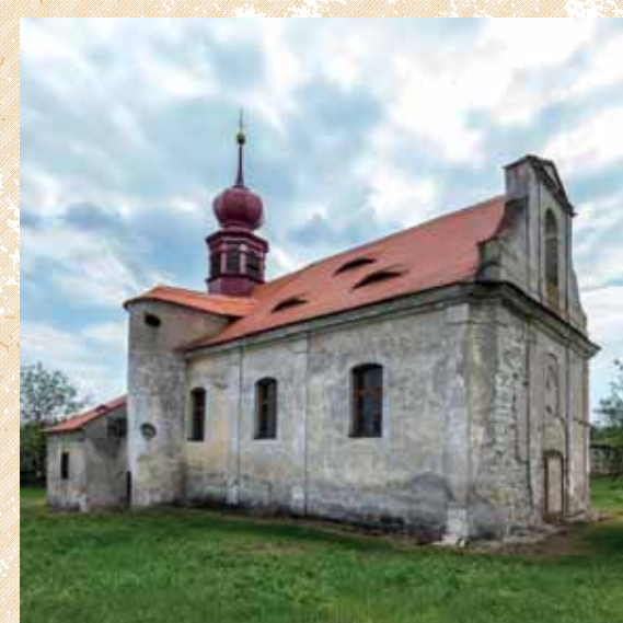
Celkový pohled od severozápadu. Foto: Marta Pavlíková, 2019.
