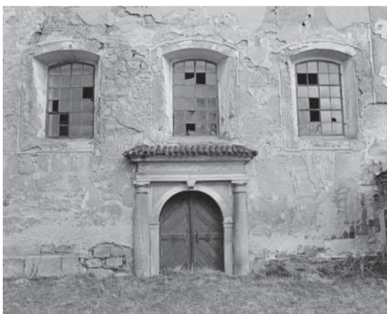
Jižní průčelí lodi na fotografii z roku 1988. Ze snímku je patrné rozdílné utváření soklu a omítková lížena jihozápadního nároží lodi se starší omítkovou vrstvou pod ní. Tyto okolnosti mohou naznačovat ještě předbarokní stáří obvodového zdiva lodi od jihozápadního nároží po začátek soklu skládaného z kamenných desek. Zdroj: NPÚ ÚOP v Ústí n. L., Sběrka negativů, sign. 96475.
