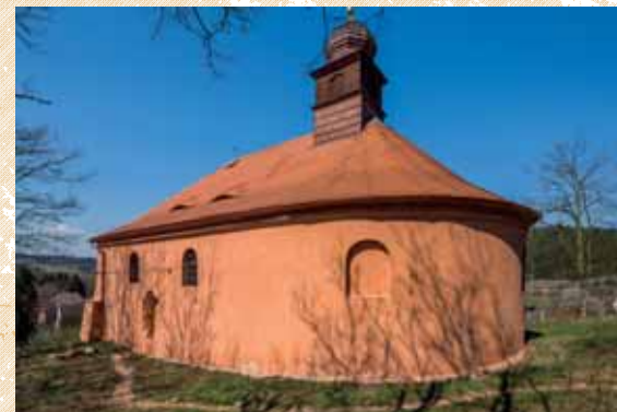
Celkový pohled od jihovýchodu. Foto: Marta Pavlíková, 2020.
