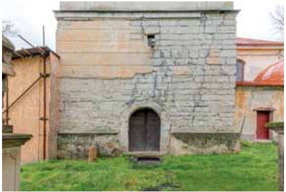
Západní průčelí věže na úrovni přízemí a prvního patra se vstupním portálem a odhalenou strukturou zdiva, které ve velkém množství druhotně využilo románských kvádrů. Foto: Marta Pavlíková, 2021.
