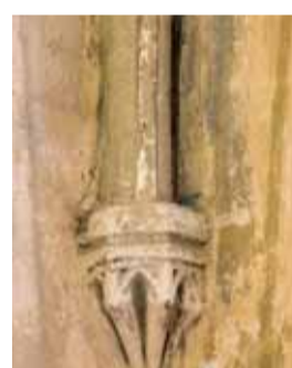
Detail jihozápadní konzoly presbytáře. Foto: Marta Pavlíková, 2018.
