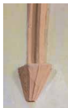
Detail severozápadní konzoly presbytáře. Foto: Marta Pavlíková, 2019.
