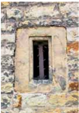
Detail horního východního okenního otvoru přízemí věže. Foto: Marta Pavlíková, 2018.
