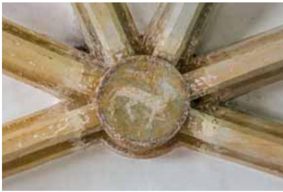
Detail svorníku klenby závěru gotického presbytáře s malbou Beránka Božího. Foto: Marta Pavlíková, 2019.
