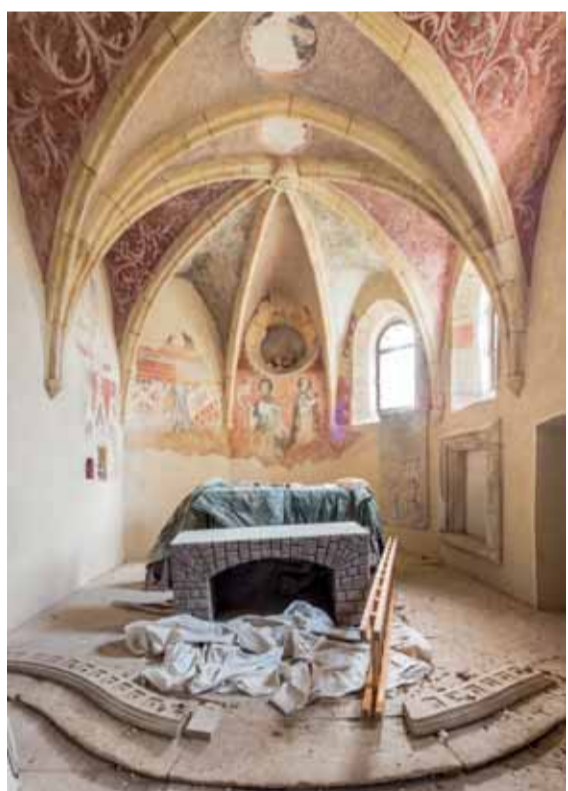
Interiér presbytáře s pohledem k východu. Foto: Marta Pavlíková, 2020
