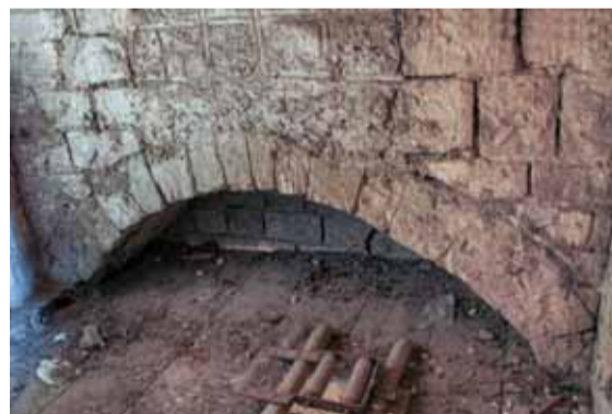
Pas na východní straně druhého patra věže, který vynáší východní zdivo věže nad úrovní koruny západního zdiva lodi. Foto: Jaroslav Skopec, 2008.
