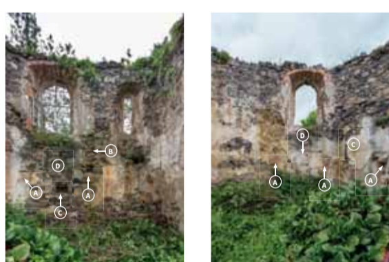
Jižní strana presbytáře v pohledu od severu. Foto: Marta Pavlíková, 2019. A – Odsekávané klenební konzoly. B – Zazděná drážka pro osazení žebra klenebního výběhu. C – Odkládací výklenek s výřevou. D – Zazděný okenní otvor (?). Severovýchodní strana presbytáře v pohledu od jihozápadu. Foto: Marta Pavlíková, 2019. A – Odsekávané klenební konzoly. B – Dochovaná východoseverovýchodní konzola. C – Zazděný severovýchodní hrotitý okenní otvor. D – Zazděný výklenek sanktuária.
