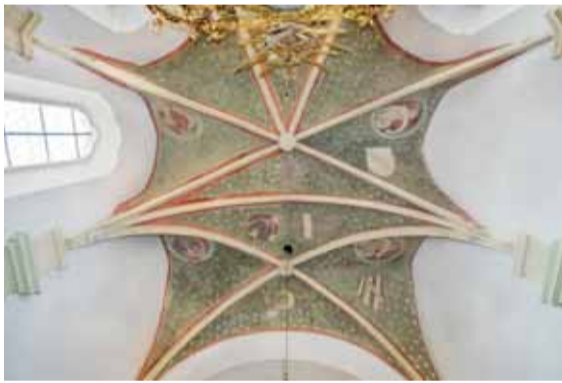
Klenba presbytáře v pohledu. Foto: Kateřina Neumannová, 2015.
