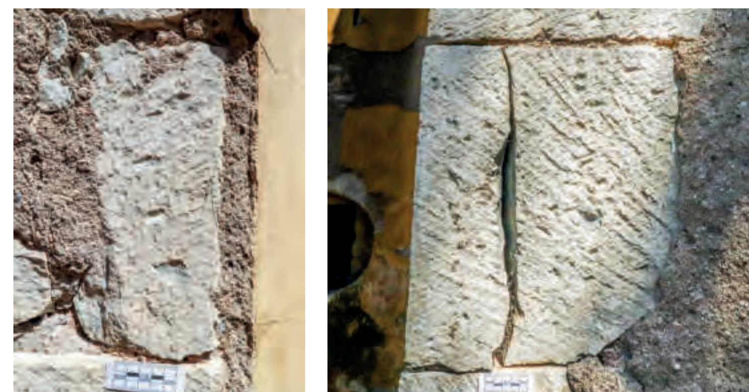
Staňkovic, kvádry nárožní armování lodi. Dva příklady typického líce gotického kvádrů nesoucího charakteristické stopy po finálním přerovnání sekerou s plochými zuby. Na levém kvádru je patrná úzká obvodová stezka zhotovená pomocí dláta s rovným ostřím. Foto: Michal Cihla, 2019.
