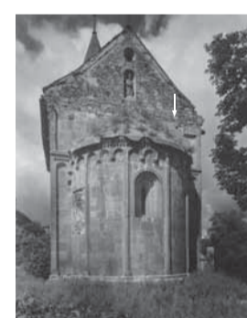
Východní průčelí kostela v pohledu od východu na fotografii z roku 1953. Zdivo štítu je dosud tvořeno lomovým kamenem, ve zdivu je otevřena půlkruhová nika pro sochu sv. Jakuba Většího a výše položený kruhový otvor. Šipka označuje fragment půlkruhového obloučku spodní části stoupavého vlysu románského štítu, který byl odstraněn v rámci chybné rekonstrukce štítu ze třetí čtvrtiny 20. století. Napravo od něj se nachází fragment pravotočitého založení vlysu s římsou. Zdroj: NPÚ GŘ, Sbirka negativů, sign. N059383.
