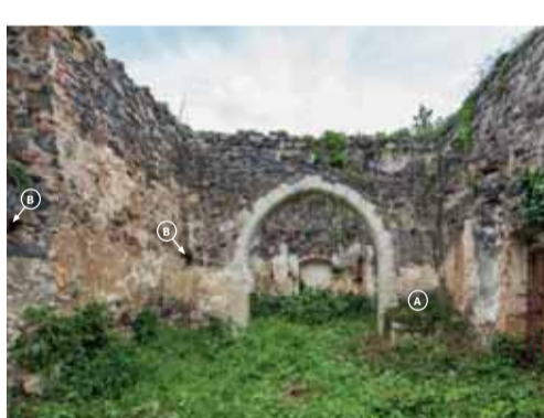
Interiér lodi v pohledu k východu. Foto: Marta Pavlíková, 2019. A – Částečně dochovaná menza bočního oltáře. B – kapsa pro zavazání trámů zaniklého severního ramene kruchty.
