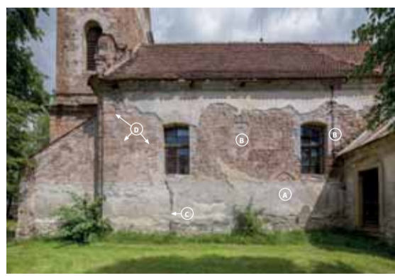
Čelní pohled na jižní průčelí lodi. A – středověký portál zazděný při rozšíření lodi roku 1788. B – dvojice středověkých okenních otvorů zazděných při rozšíření lodi a realizaci stávajících okenních otvorů roku 1788. C – vertikální spára určující původní délku středověké lodi s kvádry dochovanými v patě nárožního armování. D – středověké kvádry druhotně použité při prodloužení lodi v roce 1788. Foto: Kateřina Neumannová, 2016.
