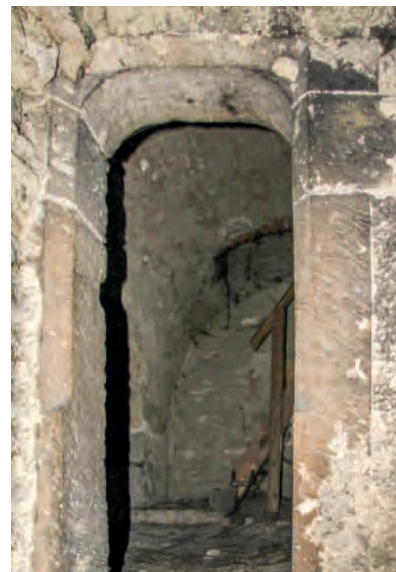
Obara, portál směřující z točitého schodiště do prvního patra věže. Foto: Jaroslav Skopec, 2018.
